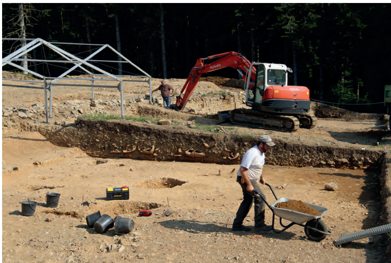
6. Bibracte, Mont-Beuvray. La terrasse PC 15. Vue des zones BA à BD, montrant l'épaisseur des remblais des états III (couche d'amphores) et IV (en cours de décapage au fond).
