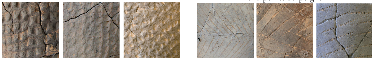
pointes de diamants = Eb40 en épi = Eb51 en goutte = Eb52 au peigne en chevron : Db31 au peigne en ligne simple : Db32
