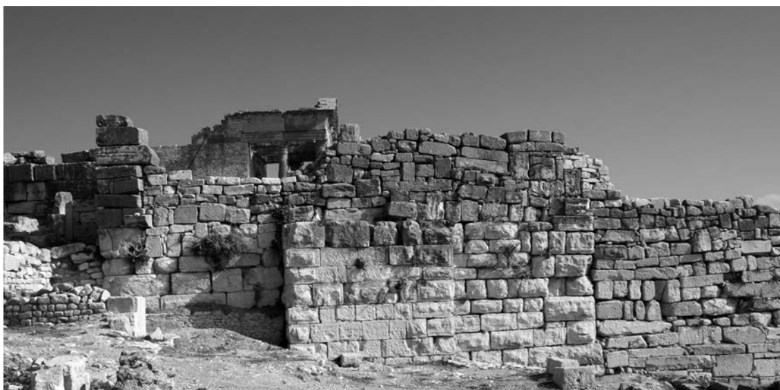
Figure 11 – Le haut podium et la niche de la façade postérieure du temple n° 21. [V. Brouquier-Reddé]
