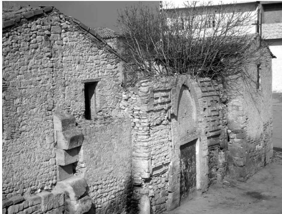
Figure 7 – Façade est, le mur antique 1 apparaît sur une hauteur de 3,20 m. [Y. Aibeche]
