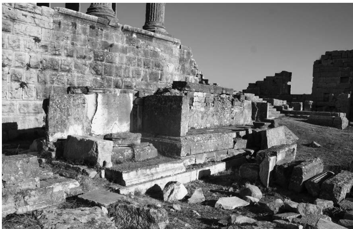
Figure 12 – Les piles de l’arc n° 25 englobées dans la tribune n° 26 devant la façade du capitole, avant restauration. [V. Brouquier-Reddé]
