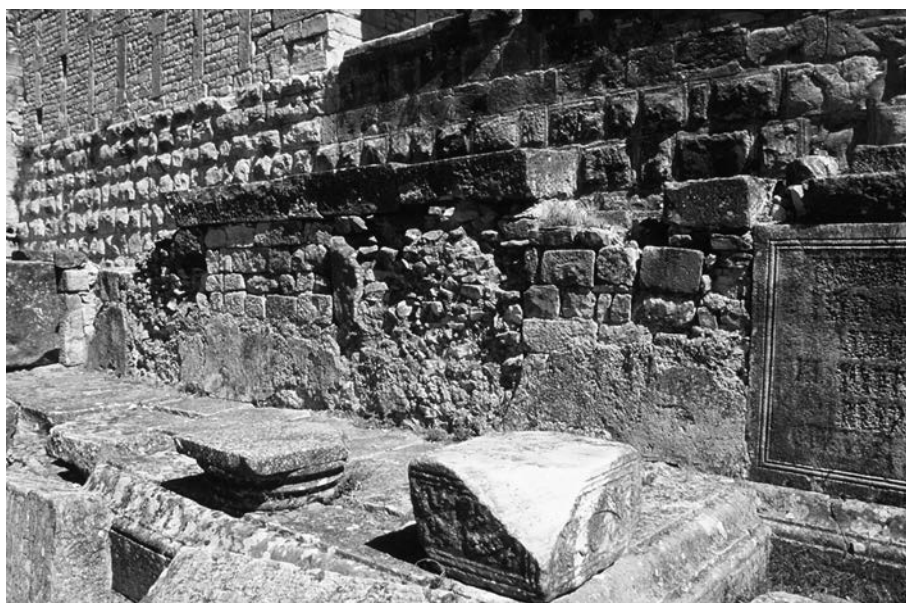
Figure 15 – L’angle rentrant sud de l’avancée de la tribune et la superposition-juxtaposition des moulures de la pile sud de l’arc et de la tribune. [V. Brouquier-Reddé]
