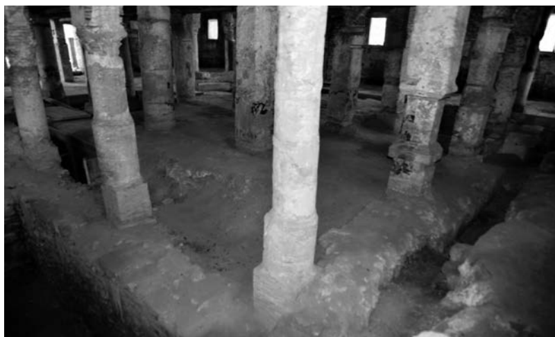
Figure 6 - Le mur antique 2 nord-est se dirige vers le sud, vu du nord-est. [Y. Aibeche]
