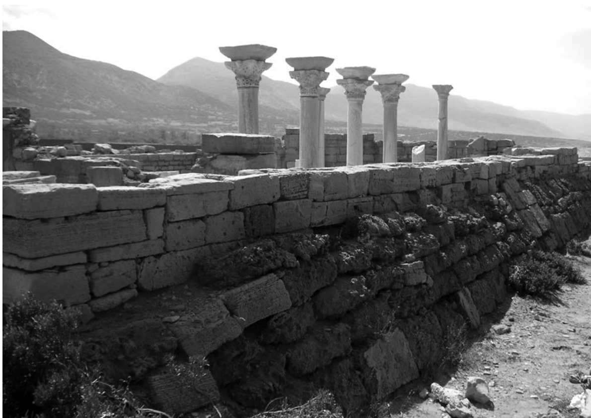
Figure 19 – Latrun : mur de soutènement contre le mur nord de la basilique occidentale. [V. Michel]
