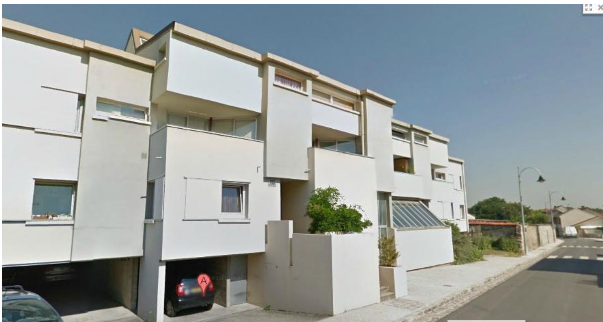
Figure 14 : Vue du bâtiment depuis la rue.
