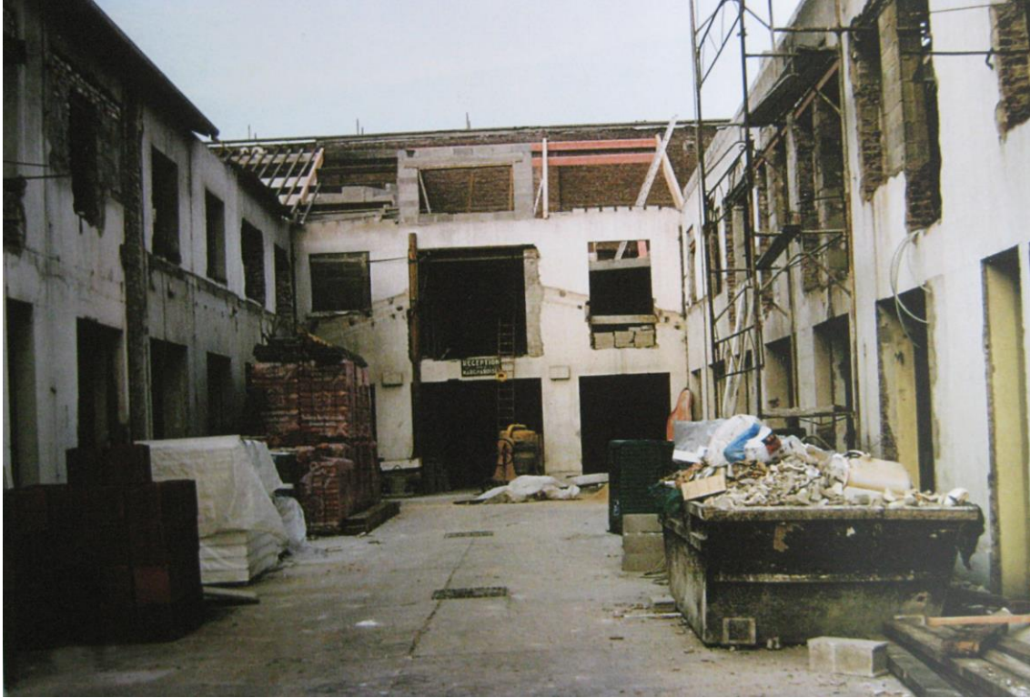
Figure 26 : Image d'archive représentant la même cour du côté de la rue Barbès et l'immeuble en U pendant les travaux. Source : Archives du groupe d'habitants.
