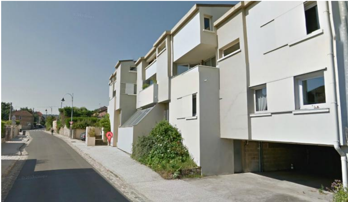
Figure 16 : Vue du bâtiment depuis la rue.
