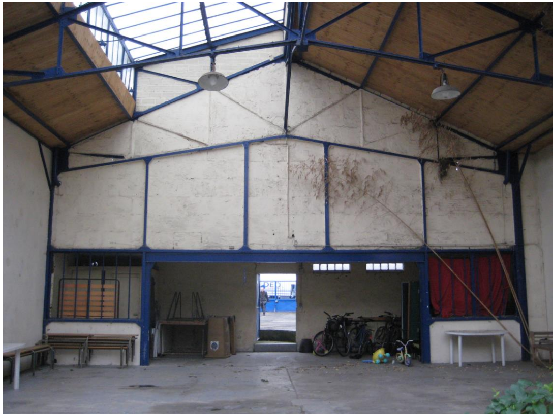
Figure 29 : La halle commune dans son état actuel. Crédits photographiques : Auteurs du rapport ; janvier 2011.
