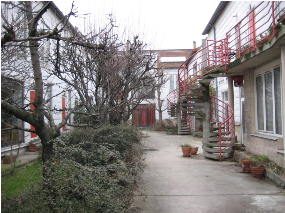
Figure 27 : La cour du côté de la rue Barbès et l'immeuble en U de nos jours. Crédits photographiques : Auteurs du rapport ; janvier 2011.
