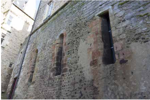
Fenêtres sur l'escalier des Pans de Gorrion (XIIIe s.)
