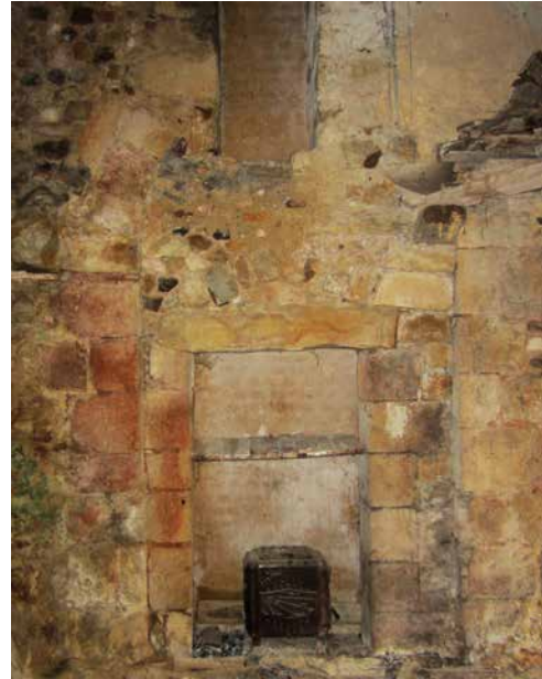
Vestiges du portail de la salle basse (XIIIe s.)
