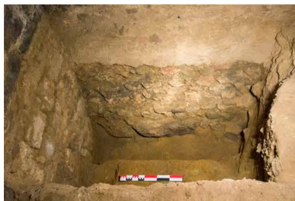
Fig. 35 - Tranchée de fondation (US 1011), au fond blocs de grès (US 2018), puis fondation maçonnée (US 1005) recouverte par l'enduit 1009 (H. Meunier - 2014)
