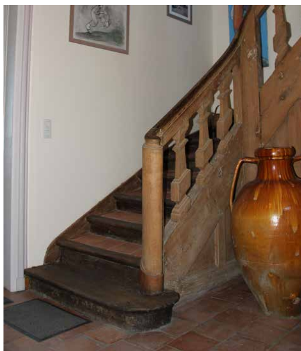
Fig. 29 - Escalier central du XVIII e s. (H. Meunier - 2014)
