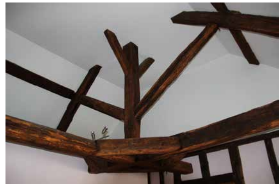
Charpente du corps principal (XVIIIe s. ?)
