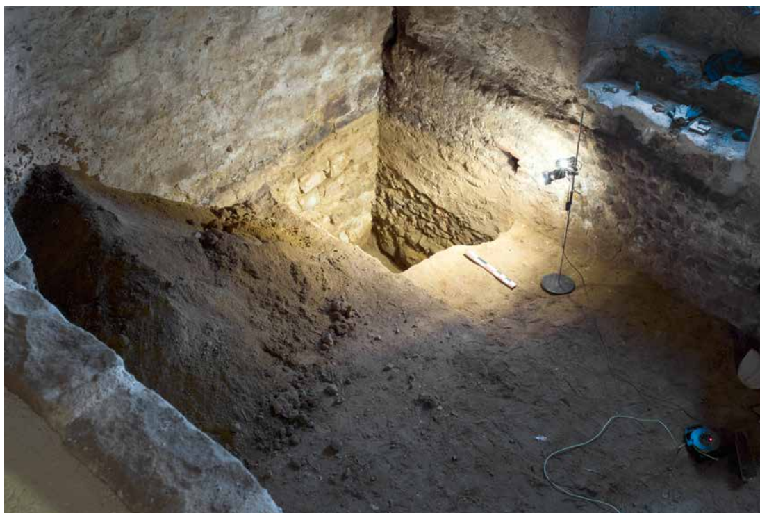
Fig. 33 - Localisation du sondage 1 à l'angle des murs M1 et M2 (H. Meunier - 2014)
