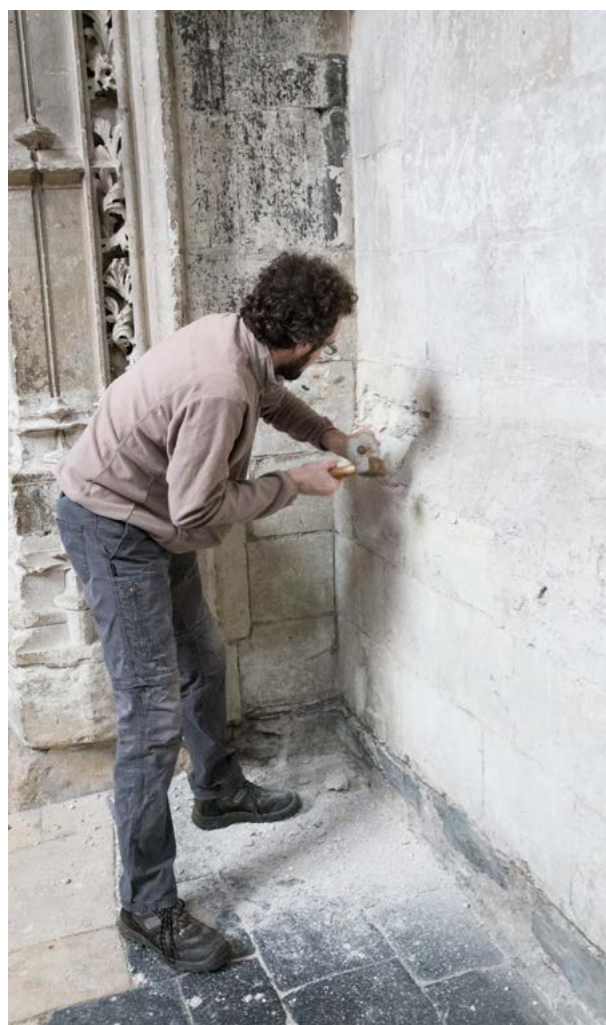
Fig. 12 - Sondage dans le mortier gris (H. Meunier)
