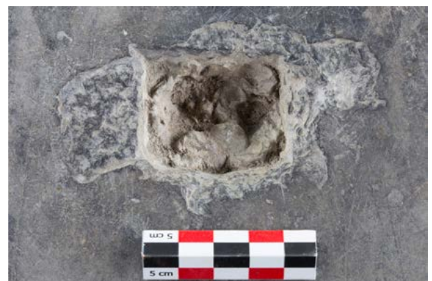
Fig. 60 - Trou de scellement au plomb (H. Meunier)
