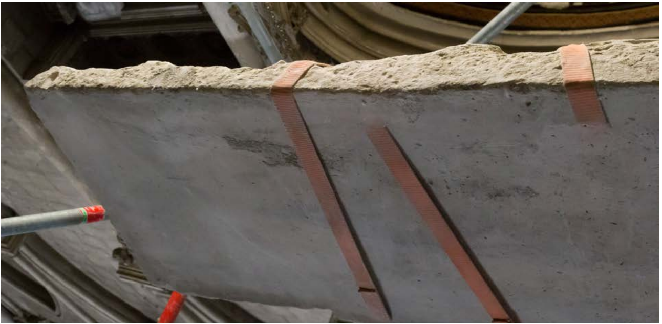
Fig. 42 - Aspect de la face du dessus du soubassement (H. Meunier)
