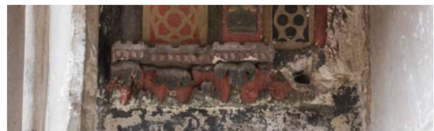
Fig. 66 - Corniche de gauche à la naissance de la voûte (H. Meunier)
