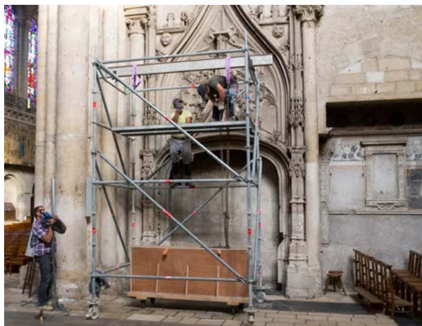
Fig. 10 - Échafaudage pour soulever la dalle de soubassement (H. Meunier)
