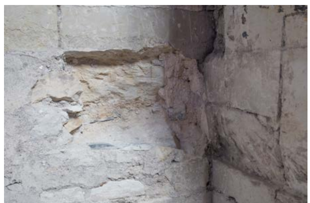
Fig. 56 - Sondage 2 (de droite), mortier récent enlevé (H. Meunier)
