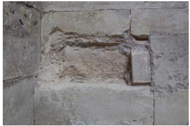
Fig. 54 - Sondage 1 (de gauche), mortier récent enlevé (H. Meunier)
