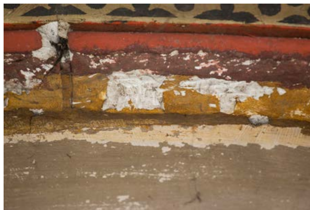
Fig. 69 - Jonction entre la voûte et le mur de fond de l'enfeu. Peinture rouge foncé recouvrant une peinture rouge et une peinture jaune-ocre. Sur le mur de fond, badigeon gris (H. Meunier)
