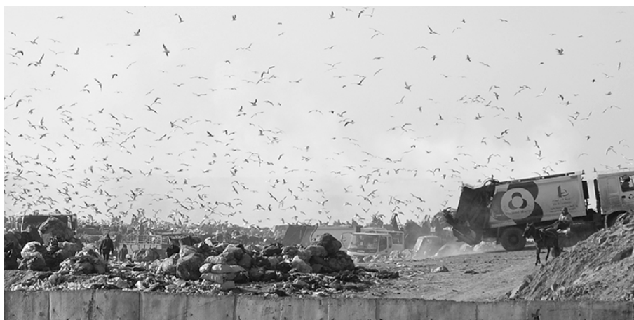
Figure 5 – L'intérieur de la décharge de Médiouna en 2012
