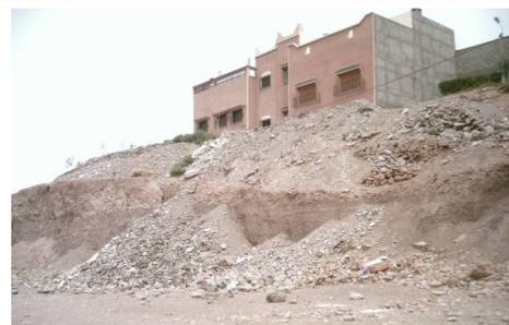
**Photo 2 : Hay Almassira où les constructions érigées nécessitent préalablement un traitement des fondations**
