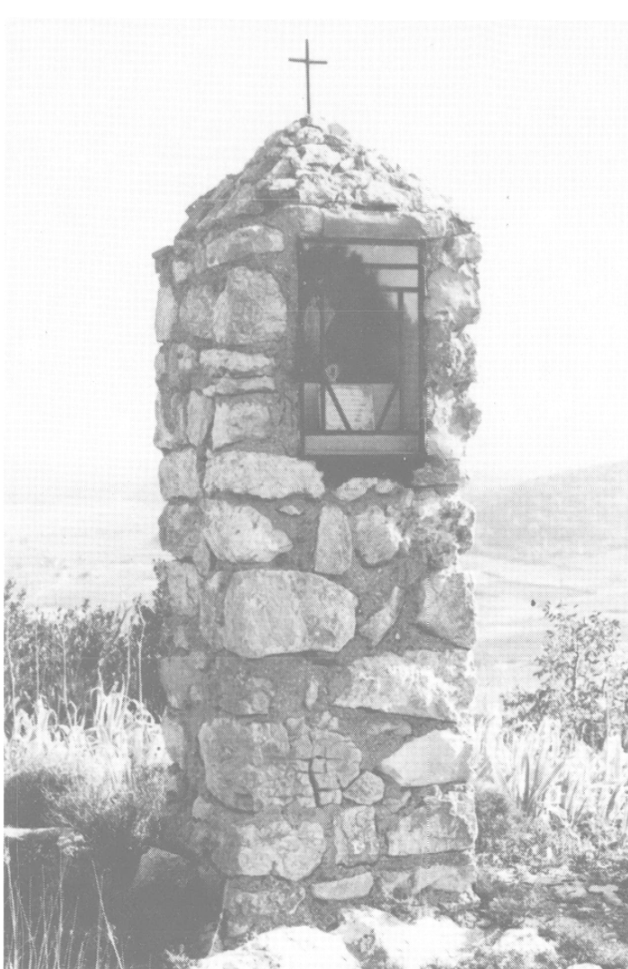
5. Notre-Dame, Saint-Julien-le-Montagnier. Oratoire ancien (1952). Localisation : saltus, bord de route. Orientation : 260°. Pilier en pierres ; niche rectangulaire avec statuette de la Vierge protégée par un portillon vitré ; toit à quatre pentes surmonté d'une croix de fer. Inscription à l'intérieur de la niche : «A toi Sainte Marie avec notre merci pour ton geste clément envers notre Maman, ce modeste oratoire en sa chère mémoire». Dimensions : 240 h × 78 l × 74 p. Niche : 60 h × 40 l × 60 p.
