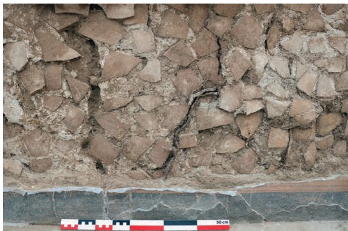
Fig. 4 – Couche préparatoire de l'enduit peint incluant de nombreux tessons d'amphore (cliché : M.-P. Rothé, CD13-MDAA/Inrap).
