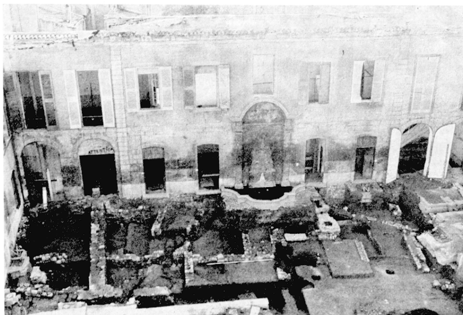
FIG. 34. - LA FAÇADE DES ÉCURIES DE CHARLES DE VINTIMILLE AVANT SON RE- CUL; VUE D'ENSEMBLE DES MURS SUBSISTANTS DE L'AILE MÉRIDIONALE DU PALAIS MÉDIÉVAL
