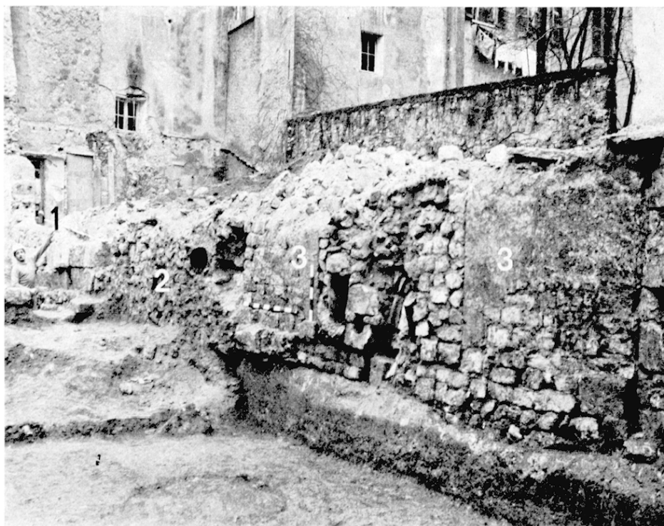
FIG. 72. --- FONDATIONS DU MUR SUD DES ÉCURIES
