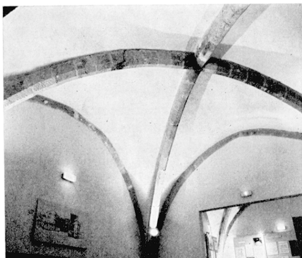
FIG. 53. --- VOÛTEMENT DU REZ-DE-CHAUSSÉE DE L'« AULA »
