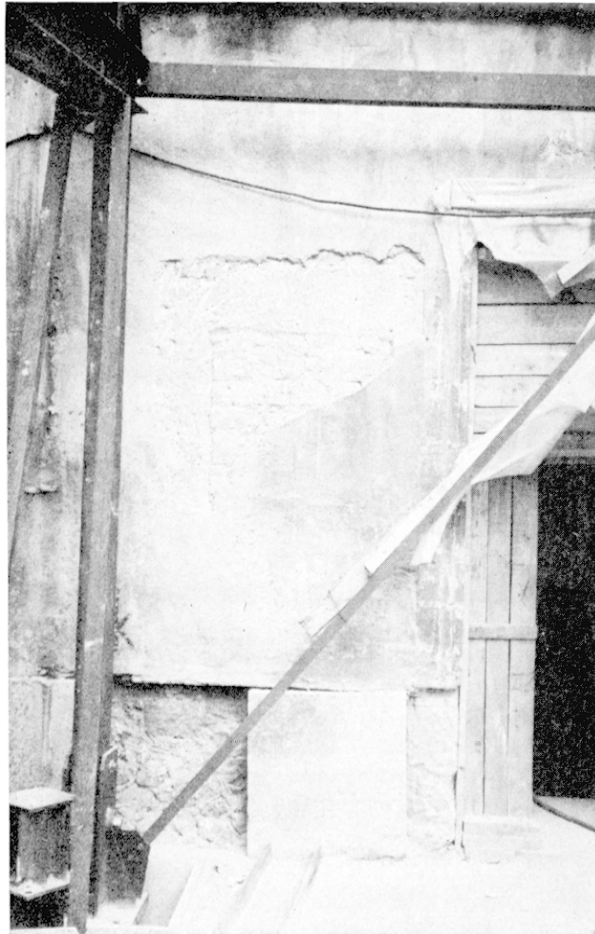
FIG. 56. — TRACE D'OUVERTURE DANS LA TROISIÈME TRAVÉE DE L'« AULA », AU REZ-DE-CHAUSSÉE
