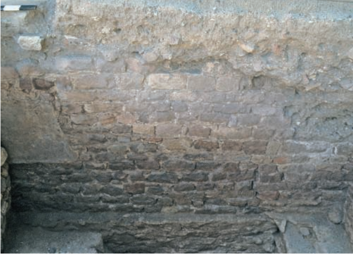
Figure 446 - Place Formigé, secteur oriental. Sondage nord. Face occidentale du mur 52 (phase 3) posé sur l'arase du mur 27 (phase 2) ; il subsiste un pan d'enduit dont la base indique le niveau d'un sol. On devine, à dr., le mur 53 et, en bas, l'arase du mur 25. Vue prise vers l'est (cliché L. Rivet).
