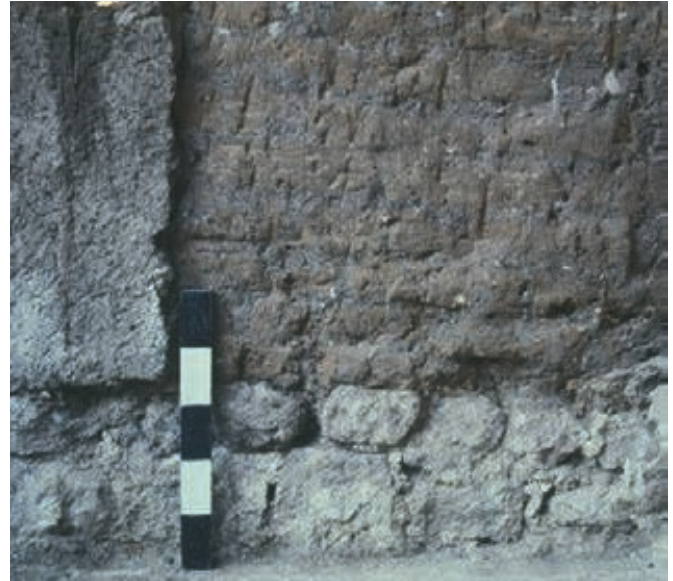
Figure 272 - Place Formigé. Phase 2. Après dépose des peintures, élévation du mur 24 (face est) comprenant, à la base, deux assises maçonnées supportant des lits de briques crues ; à gauche, restes de la couche d'accroche des peintures. Vue prise vers l'ouest (cliché L. Rivet).
