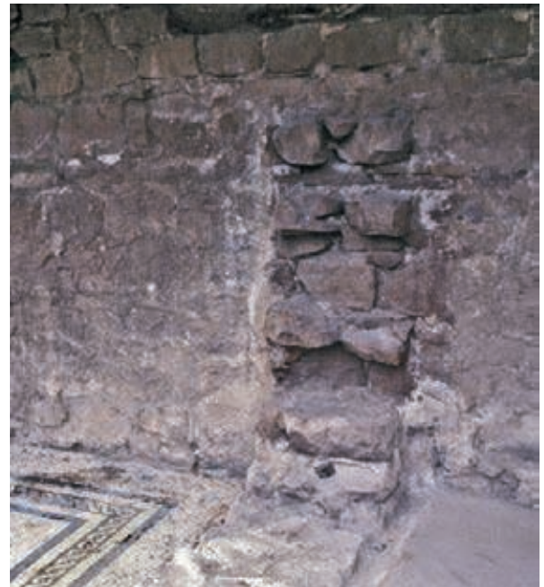
Figure 274 - Place Formigé. Phase 2. Corbeaux du mur 9 contre lesquels venait s'encastrier l'élévation en briques crues du mur 24 (détruit pour permettre la dépose de la mosaïque de la pièce 6). Vue prise vers le nord-ouest (cliché L. Rivet).
