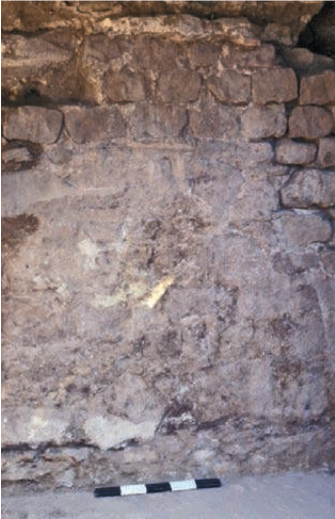
Figure 268 - Place Formigé. Phase 2. Dans l'espace 8, le parement en petit appareil (non jointoyé) du mur nord (9) de la maison après dépose des peintures murales. Vue prise vers le nord (cliché L. Rivet).
