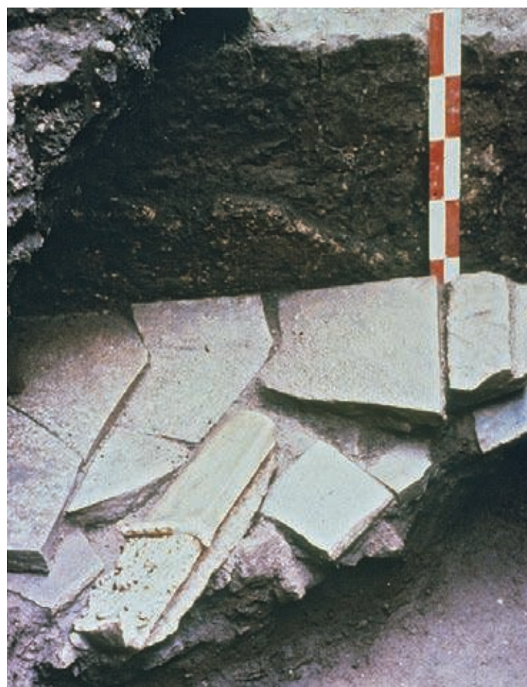
Figure 198 - Jardin du Palais de Justice. Effondrement du placage et d'un pilastre en marbre (cliché P.-A. Février, 1982).
