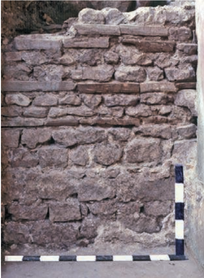
Figure 275 - Place Formigé. Phase 2. Parement oriental du mur 20 en opus mixtum après dépose des peintures murales. Vue prise vers l'ouest (cliché L. Rivet).
