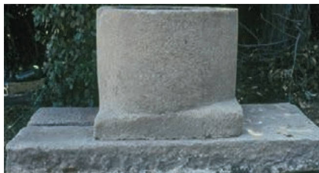
Figure 310 - Place Formigé. Margelle du puits et son socle après dépose (cliché L. Rivet).
