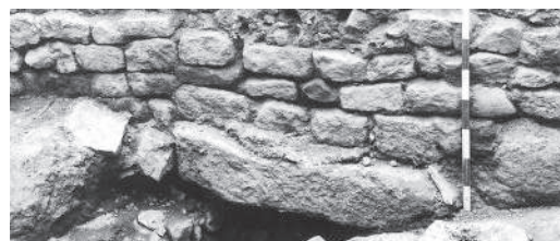
Figure 138 - « Nord-Est cathédrale ». Phase 6, secteur II. Assises inférieures du mur de l'Antiquité tardive, 19, au niveau du franchissement de l'égoût collecteur (b) qui a conservé sa dalle de couverture. Vue prise vers l'est (cliché P.-A. Février, 1979).
