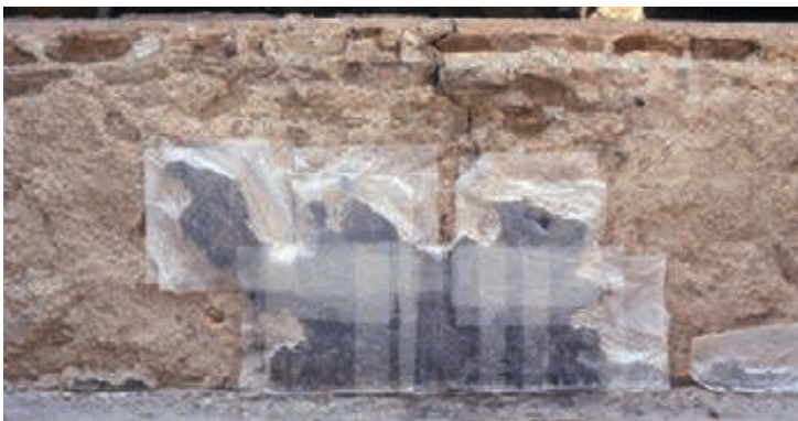
Figure 278 - Place Formigé. Phase 2. Après dépose des peintures, élévation du muret 23 (face nord). Vue prise vers le sud (cliché L. Rivet).
