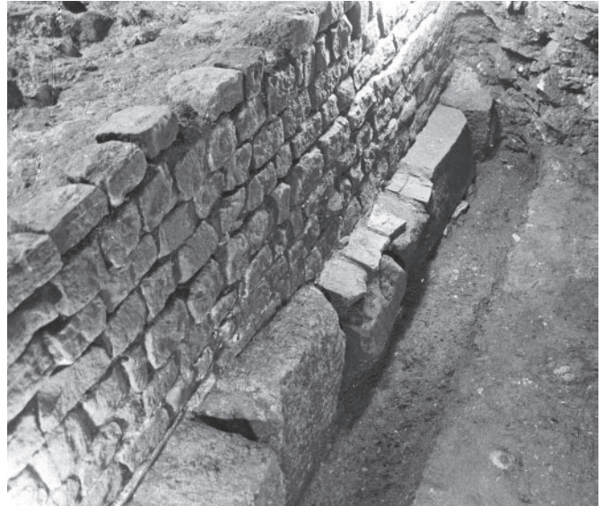
Figure 455 - Chœur de la nef Saint-Étienne. Mur (4) en petit appareil lié à la terre reposant sur une base débordante en blocs de remploi. Vue prise vers le nord (cliché M. Griesheimer).
