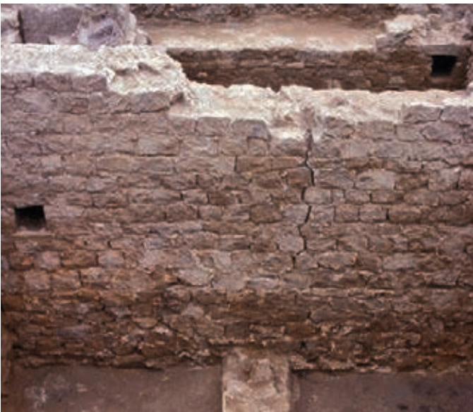
Figure 405 - Place Formigé. Phase 3. Élévation de la fondation du mur 33, face nord ; la lézarde s'est produite à l'aplomb du mur 12 de la phase 2 qui crée une résistance différentielle. Vue prise vers le sud (cliché L. Rivet).
