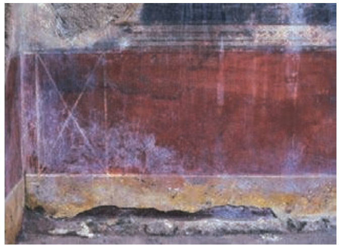
Figure 331 - Place Formigé. Phase 2. Tablinum 6. À la base du panneau couvrant le mur 9, on distingue un état antérieur. Vue prise vers le nord (cliché L. Rivet).
