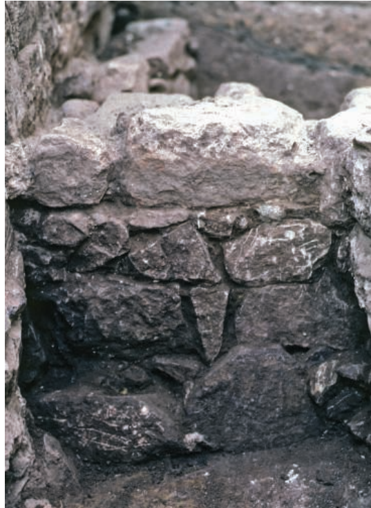
Figure 32 - « Nord-Est cathédrale ». Phase 2A, secteur I. Parement oriental de la fondation du mur 5. Vue prise vers l'ouest (cliché L. Rivet, 1981).
