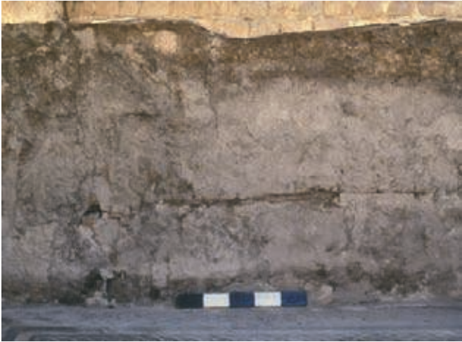
Figure 271 - Place Formigé. Phase 2. Après dépose des peintures, élévation du mur 24 (face ouest) revêtu d'un épais enduit de chaux. Vue prise vers l'est (cliché L. Rivet).
