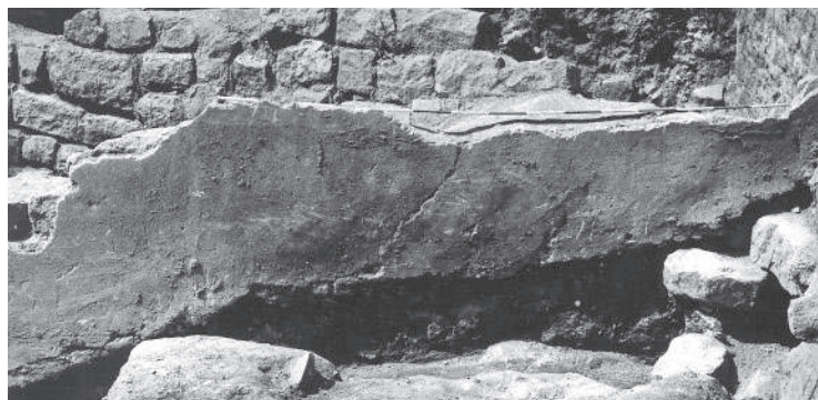
Figure 84 - « Nord-Est cathédrale ». Phase 4, secteurs II/IV. Enduit de chaux sur la face orientale du mur de façade 15 ; à l'arrière, mur 19. Vue prise vers l'ouest (cliché P.-A. Février, 1980).
