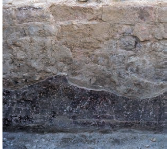
Figure 269 - Place Formigé. Phase 2. Dans l'aile sud du portique 9, parement en petit appareil (jointoyé) du mur 15 derrière la couche d'enduit peint. Vue prise vers le sud (cliché L. Rivet).
