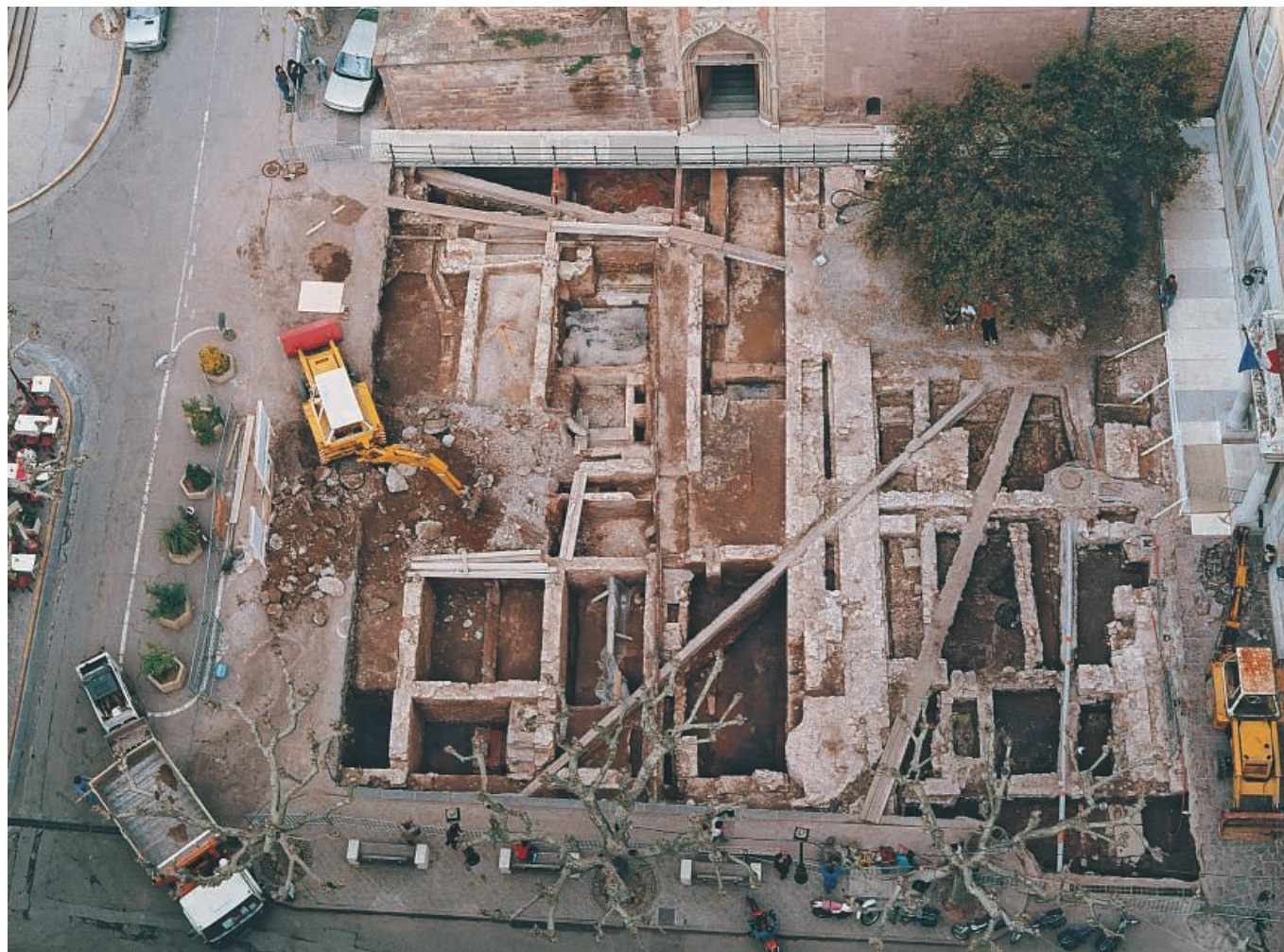
Figure 223 - Les fouilles en cours, place Formigé. Vue prise d'hélicoptère (cliché ST/CEPA).
