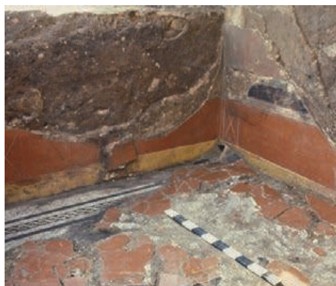
Figure 327 - Place Formigé. Phase 2. Tablinum 6 . Peintures murales effondrées sur la mosaïque dans l'angle des murs 22 et 9. Vue prise vers le nord-ouest (cliché L. Rivet).
