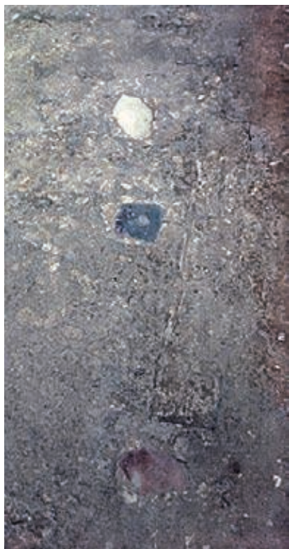
Figure 342 - Place Formigé. Phase 2. Grand œcus 8. Détail du béton de tuileaux à incrustations de plaquettes de marbre coloré (cliché L. Rivet).
