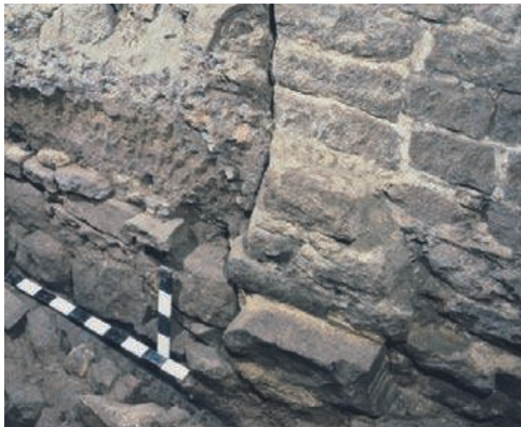
Figure 479 - Nef Notre-Dame. Phase 3. Extrémité du mur 8 (angle avec le mur 9) ayant sectionné le mur 3 de la phase 3 ; à la base, le rempli d'un bloc mouluré. Vue prise vers le sud-est (cliché L. Rivet).
