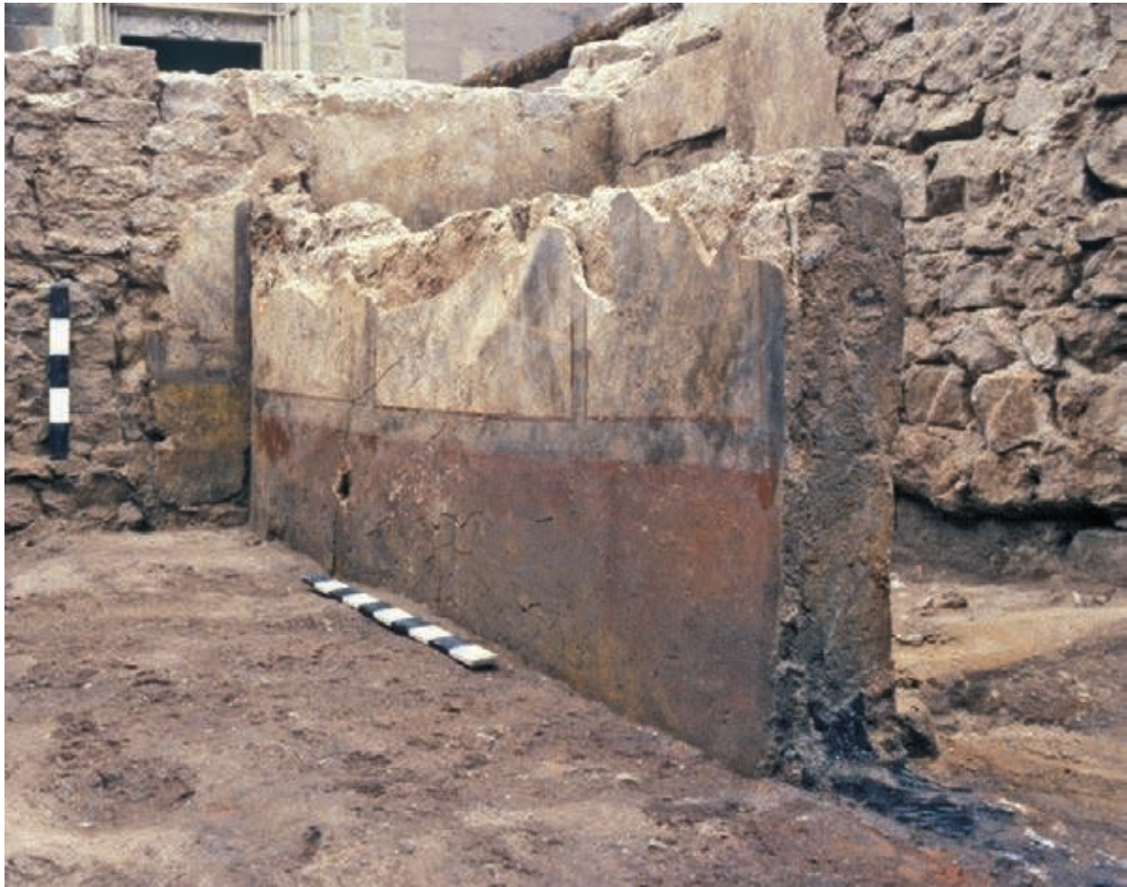
Figure 291 - Place Formigé. Phase 2. Au premier plan, baie aménagée dans la cloison 14 et dotée d'un seuil en bois. Vue prise vers le nord-est (cliché L. Rivet).
