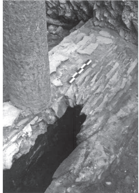
Figure 101 - « Nord-Est cathédrale ». Phase 5, secteur III. L'égout collecteur (g) établi au long de la colonnade et du muret d'entrecolonnement (sous la mire). Vue prise vers le sud-est (cliché L. Rivet, 1982).
