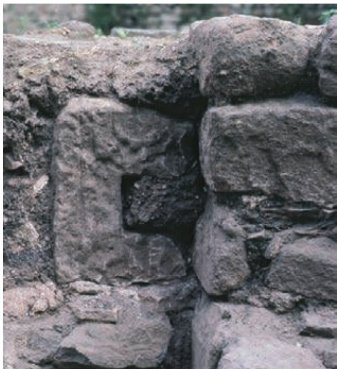
Figure 104 - « Nord-Est cathédrale ». Phase 5, secteur III. Vu en coupe, bloc de rempli plaqué contre la façade. Vue prise vers le sud (cliché L. Rivet, 1981).
