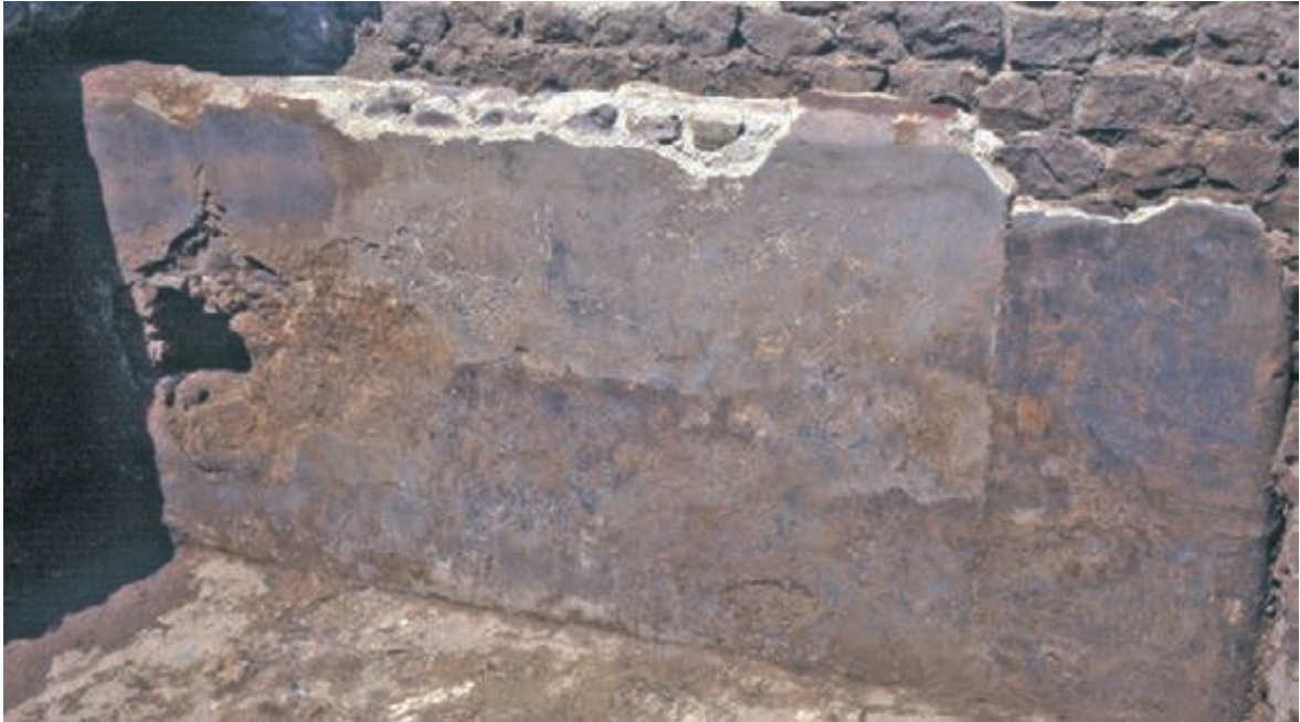
Figure 318 - Place Formigé. Phase 2. Portique 9, galerie méridionale. Parement sud du mur-écran 21 couvert d'un badigeon noir. Vue prise vers le nord (cliché L. Rivet).
