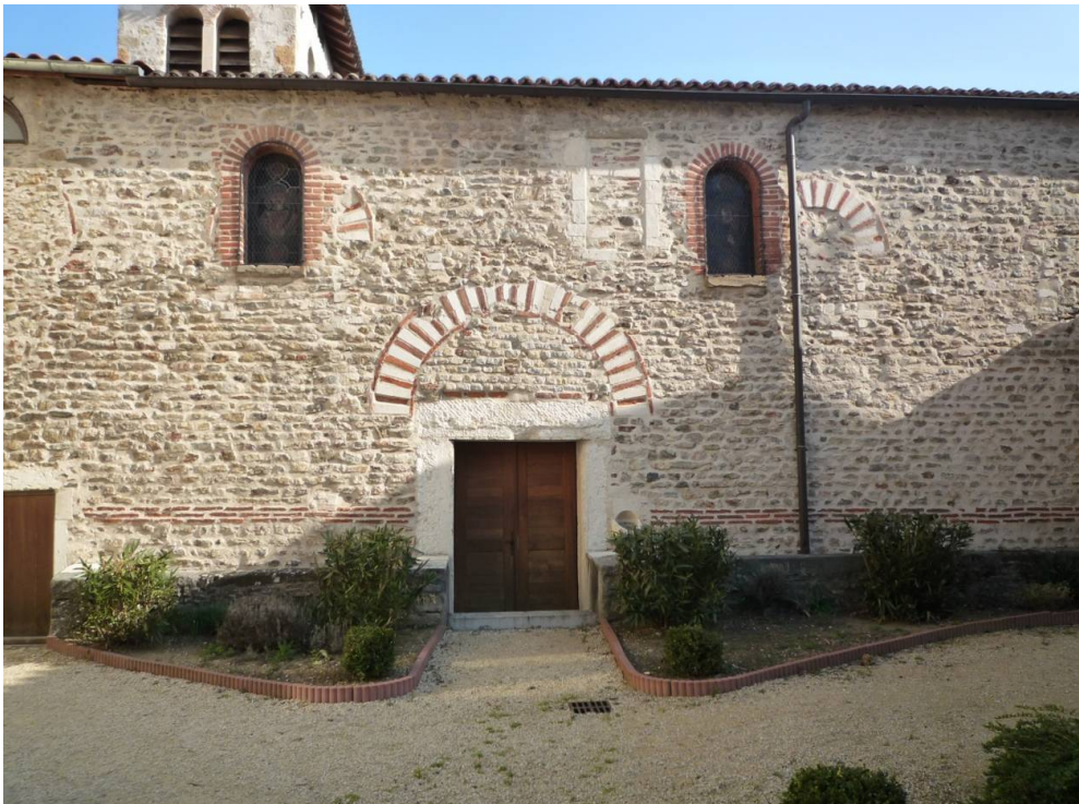
Figure 1 : mur sud de l'église de Saint-Romain-en-Gal (cliché SB)
