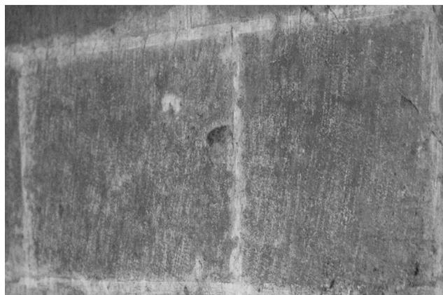
Figure 8 : Exemple de dressage au marteau brettelé. Le badigeon des joints est particulièrement lisible (© L. Gaugain).
