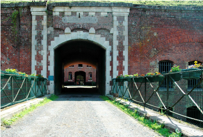
À la porte d'entrée du fort.
