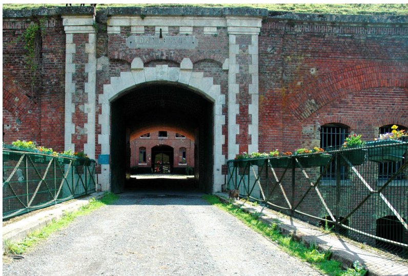
À la porte d'entrée du fort.
