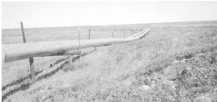
Photo 1b : Butte cryogénique au premier plan à droite soulevant le gazoduc.
