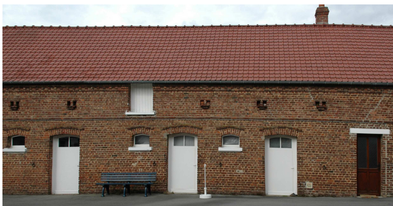
La façade intérieure de la ferme.
