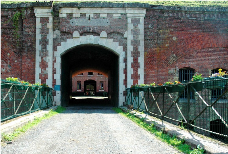
À la porte d'entrée du fort.
