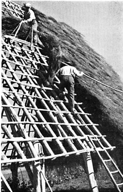
**Fig. 60** Fixation des bottes en rangées verticales (STEMMERMANN 1942).
