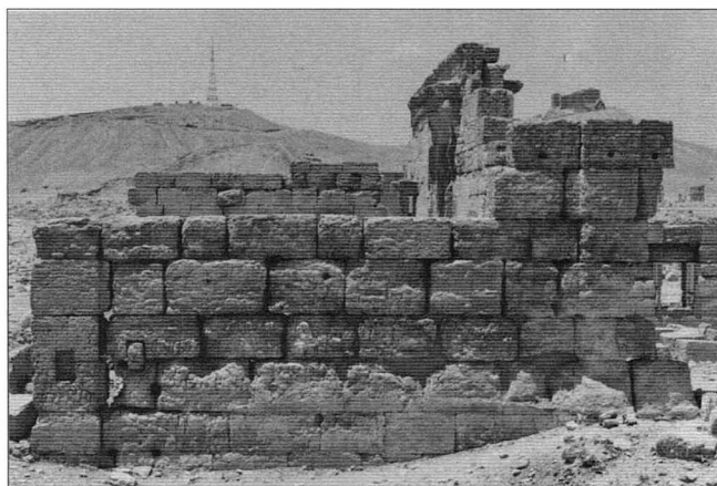
Fig. 222. Mur F, vu de l'extérieur du vestibule (photo Dentzer).
