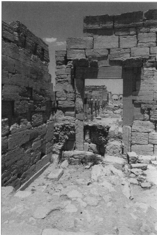
Fig. 217. Angle interne des murs B et G et porte 12 (photo Dentzer).
