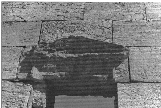
Fig. 234. Fenêtre 4 du mur B (photo Dentzer).
