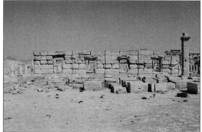
Fig. 209. Mur B : vue vers les portes 11 et 1 et entre elles, les fenêtres 8 à 5 (photo Dentzer).
