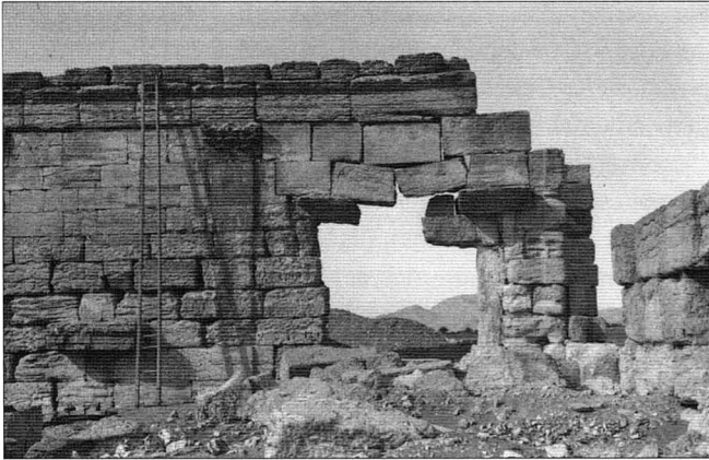
Fig. 203. Mur G avant la fouille (Nég. IFAPO, 3999).
