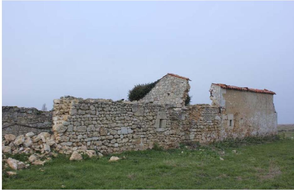
Figure 15 - Île Marteau - Bâtiment allongé pouvant servir d'étable
