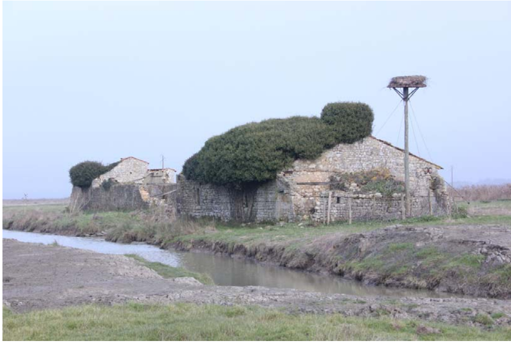
Figure 16 - Cabane de l'Île Marteau (deux bâtiments composent cet ensemble implanté le long du chenal de Brouage)
