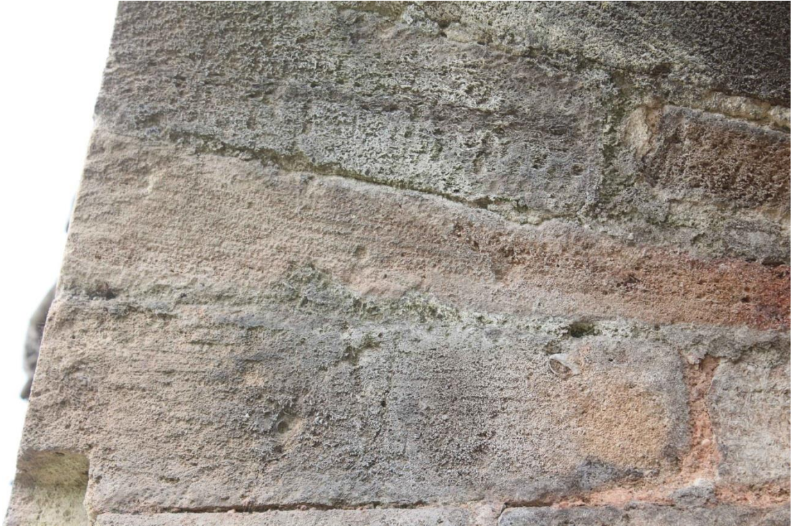
Fig. 12 : Arrière-voûture de la baie : traces de marteau-taillant bretté ou de gradine (cl. F. Mandon, Atemporelle).
