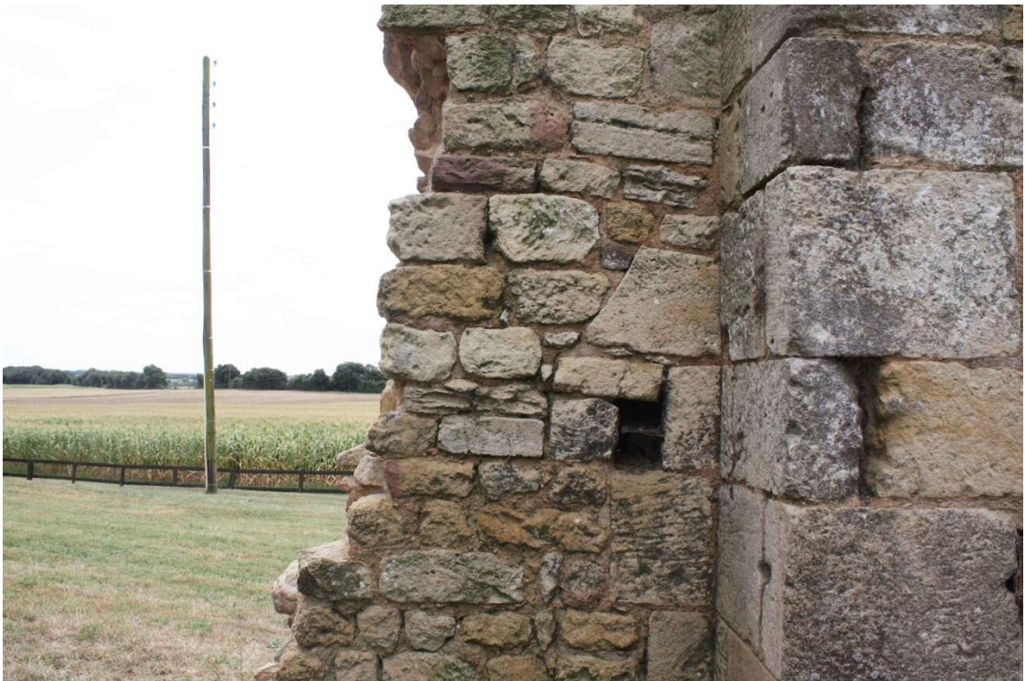
Fig. 14 : Elévation extérieure : réemplois de bloc d'extrados d'arc et de bloc à encoche (cl. F. Mandon, Atemporelle).
