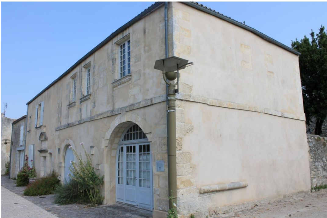
Fig. 8 : maison restaurée rue de la Brèche
