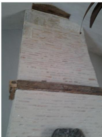
cheminée étage (5).jpg
