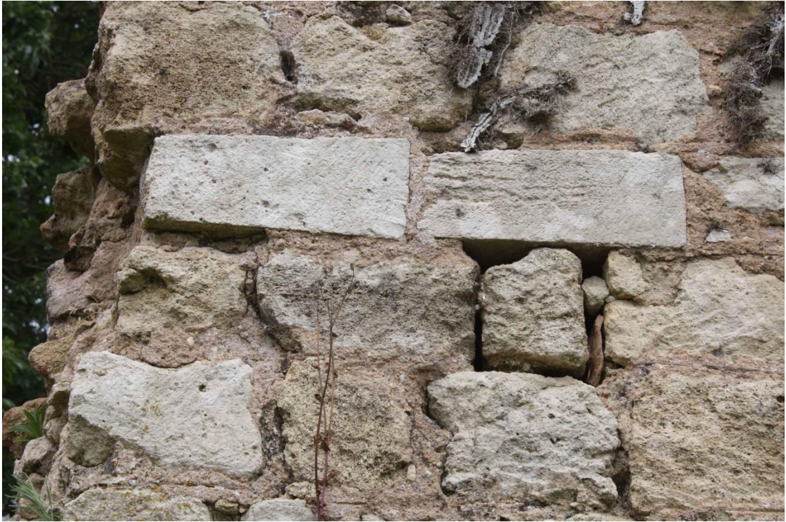
Fig. 13 : Elévation intérieure : réemploi de claveaux (cl. F. Mandon, Atemporelle).
