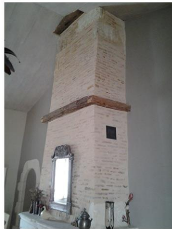
cheminée étage (2).jpg
