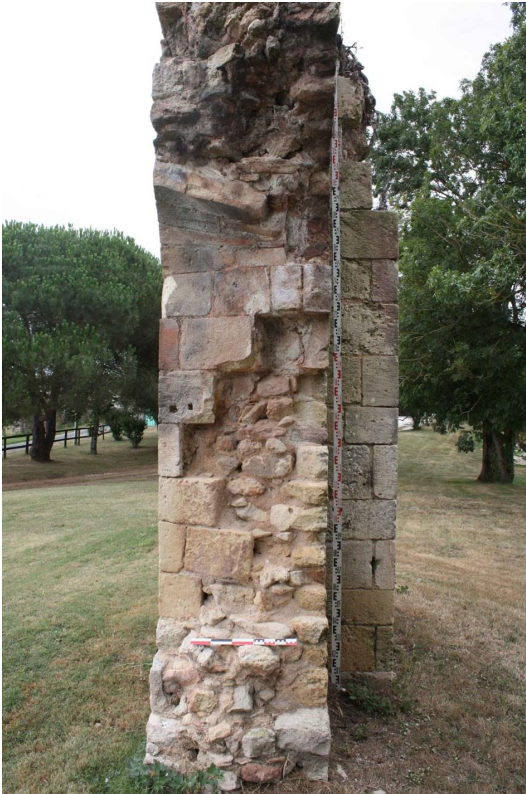
Fig. 11 : Vue du piédroit ouest de la baie, depuis le sud-est (cl. F. Mandon, Atemporelle).
