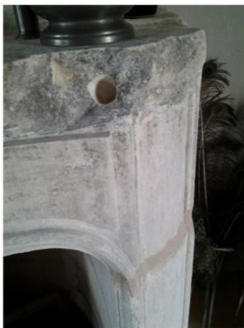
cheminée étage (7).jpg
