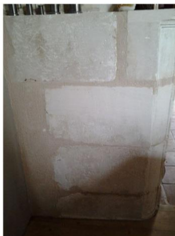
cheminée étage (6).jpg
