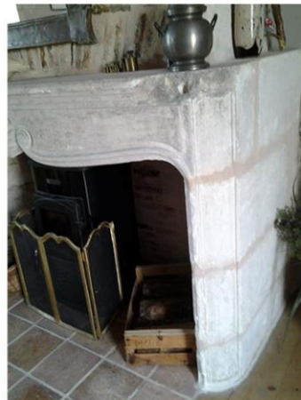
cheminée étage (4).jpg
