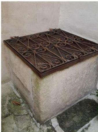
puits cour intérieur cour à gauche en entrant.jpg
