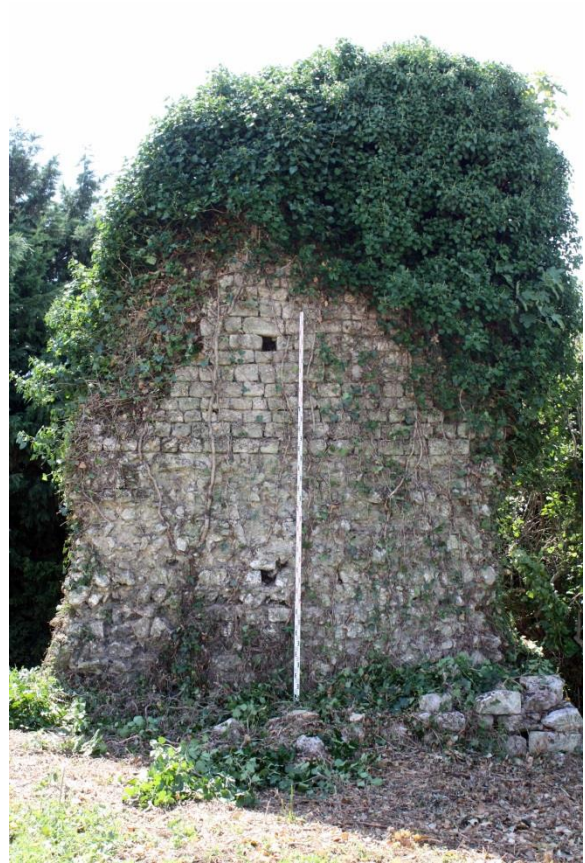
Fig. 17 : Elévation nord (cl. F. Mandon, Atemporelle).
