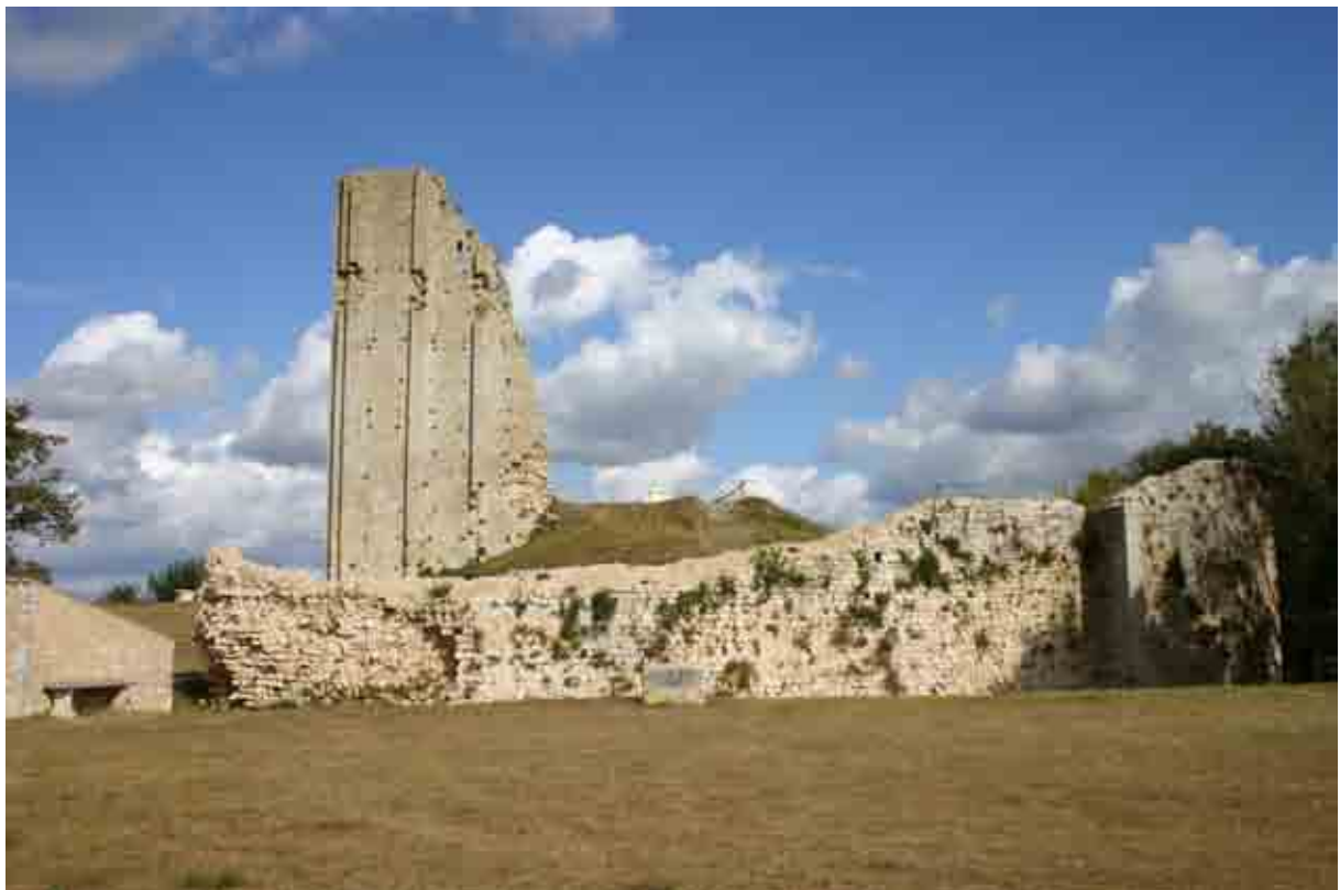
Figure 11 : Vue méridionale de la tour et de sa chemise (Cl. E.Normand)
