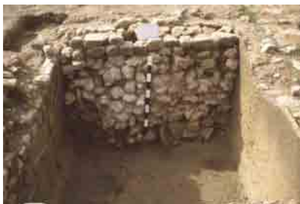
Fig. 19 : Mur HMA (Port-des-Barques, Les Chapelles)
