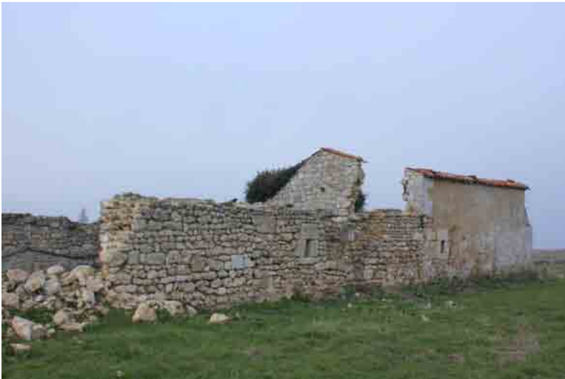
Figure 25 : Bâtiment allongé de la cabane de l'Île Marteau (étable).
