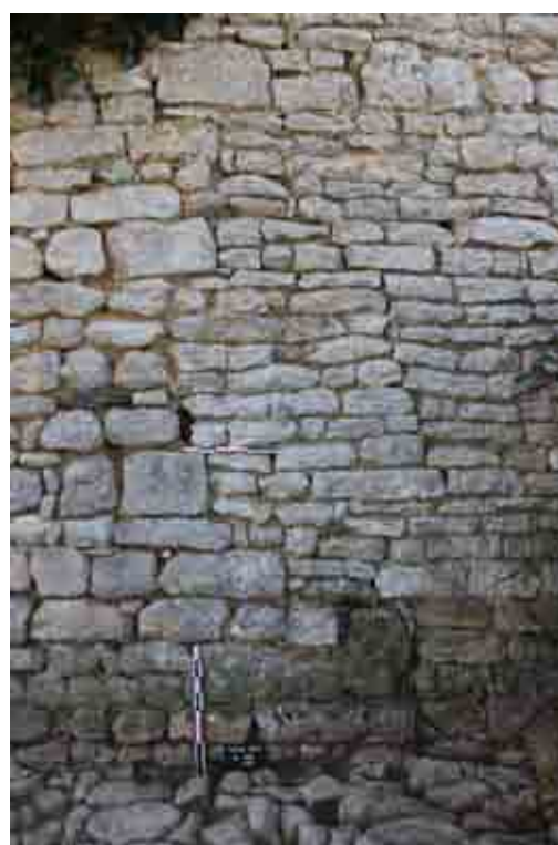
Figure 92 : Reprise (M407) du mur 402 (Cl. E. Normand)
