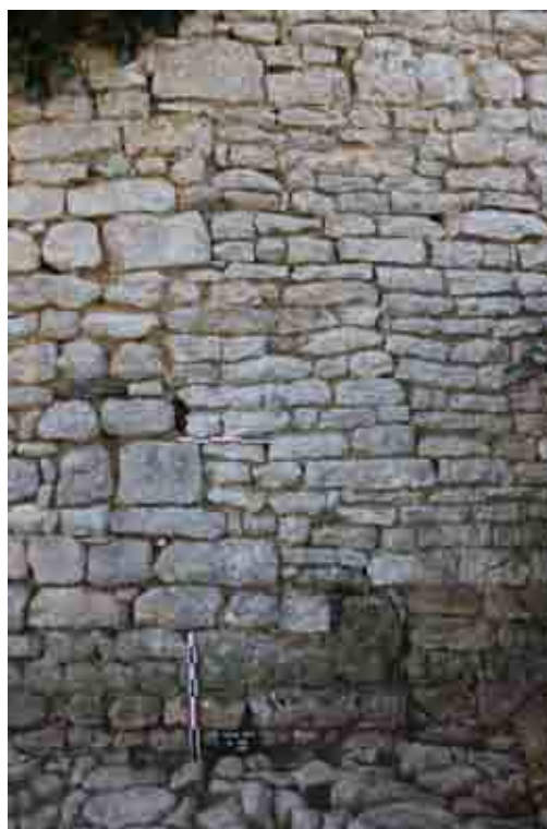
Figure 92 : Reprise (M407) du mur 402 (Cl. E. Normand)
