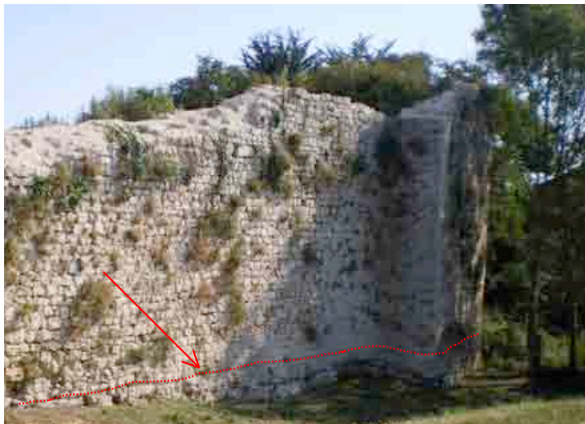
Figure 7 : Broue. Base de la courtine reposant sur les calcarénites à rudistes du Cénomanién inférieur. (Cliché : V. Mathé).
