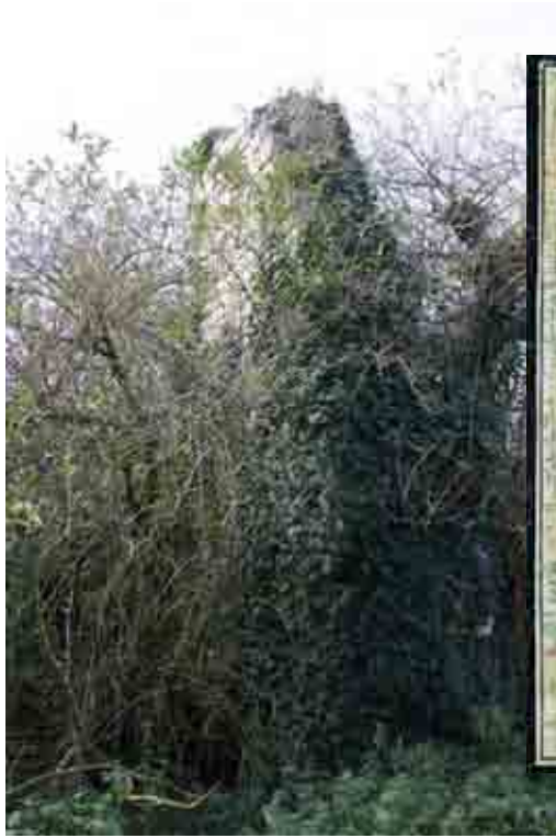
Figure 18 : Mur isolé près de la plate-forme (chapelle ?) (Cl. E. Normand)
