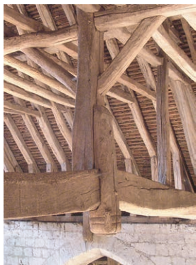
Fig. 14 Calage des pannes sur l'arbalétrier par le poteau latéral et son entretoise, assemblés à mi-bois au chevron (cl. F. E.).
