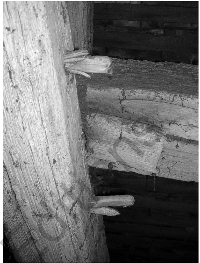
Fig. 20 Coins enfoncés dans la queue des chevilles et, en arrière-plan, cale pour l'ajustement d'une panne (cl. F. E.).
