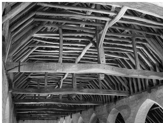
Fig. 7 Charpente du vaisseau principal (cl. F. E.).
