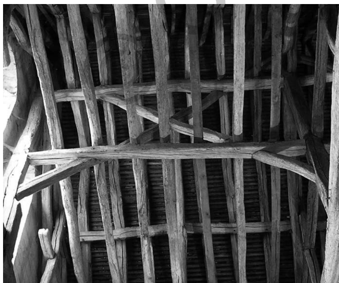
Fig. 18 Dispositif longitudinal de la première travée ouest (cl. F. E.).
