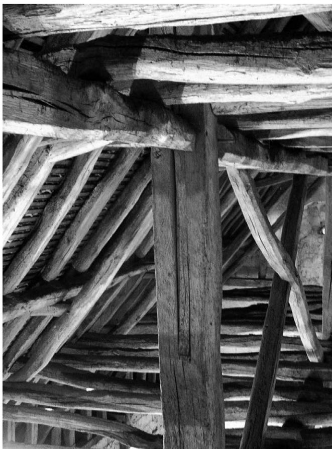
Fig. 19 Mortaise surcreusée en longueur pour l'insertion en bascule de la lierne axiale dans le poinçon de F8 (cl. F. E.).
