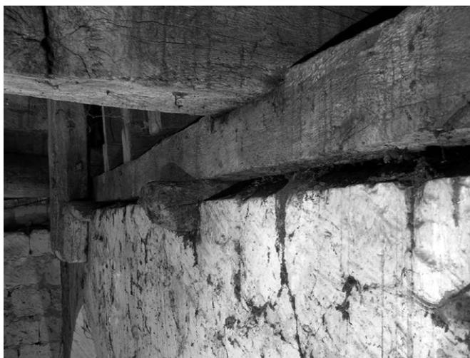
Fig. 12 Cale avec crochet sous les sablières sud (cl. F. E.).
