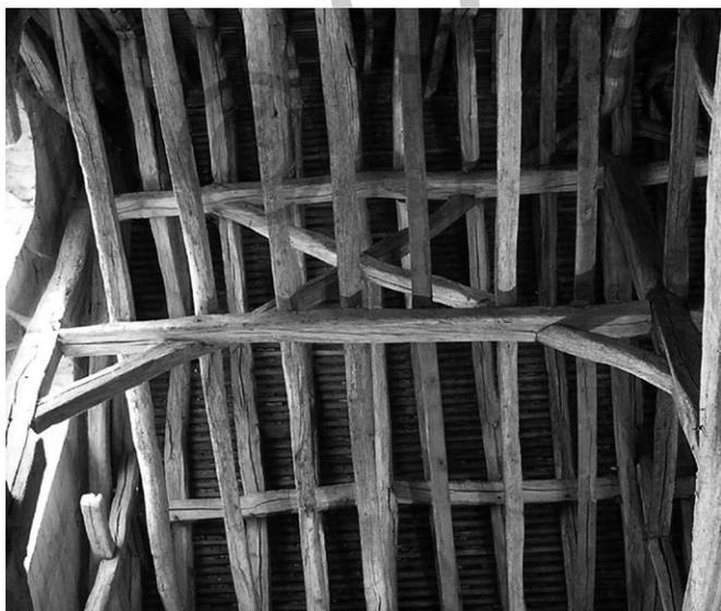
Fig. 18 Dispositif longitudinal de la première travée ouest (cl. F. E.).
