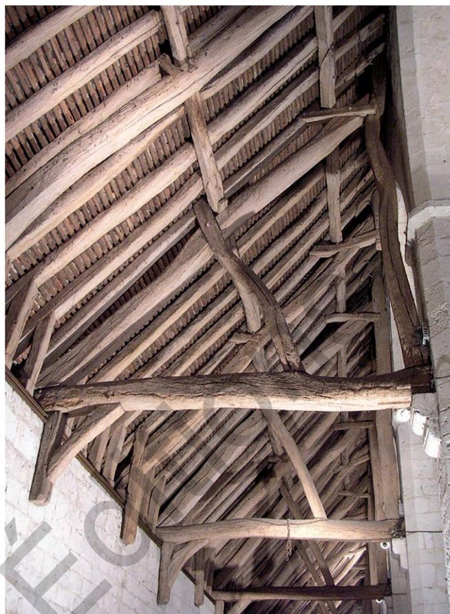
Fig. 16 Demi-ferme principale 8 du bas-côté nord (cl. F. E.).
