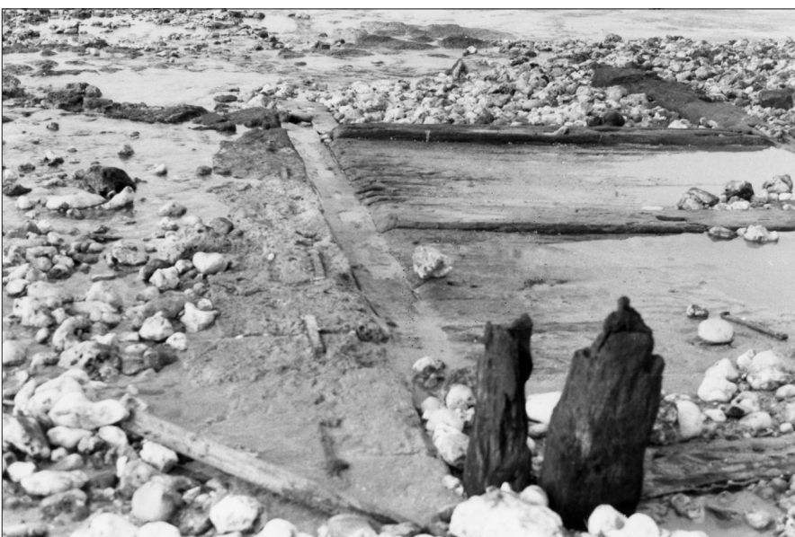
FIG. 8. Pennedepie (14). Vue de la partie ouest de l'édifice détruite en 2002 avec les blocs de tuf liés par des agrafes métalliques
