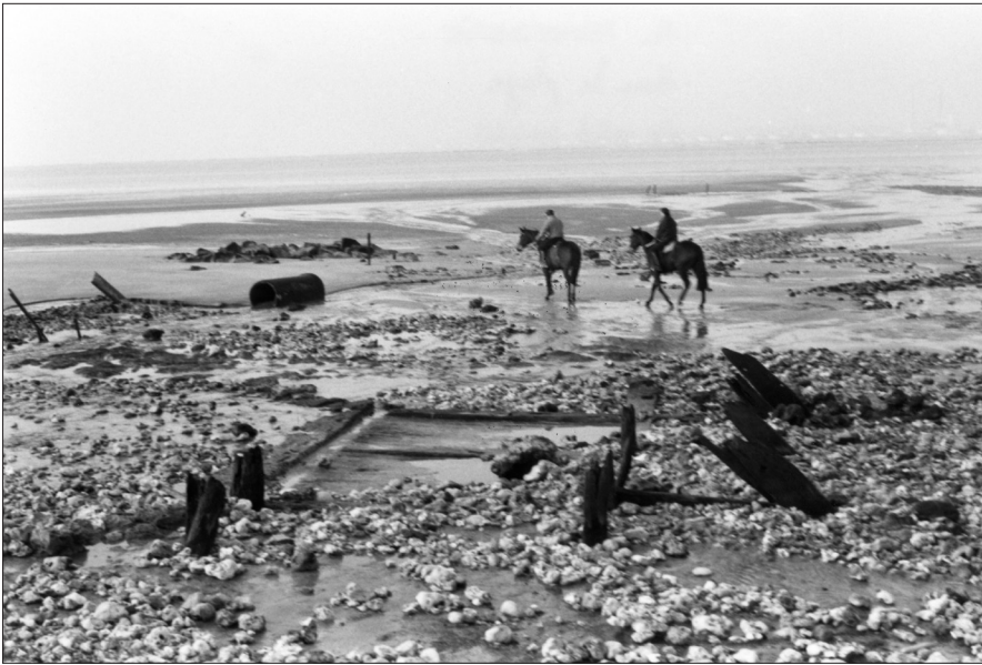
FIG. 6. Pennedepie (14). vue de l'édifice lors de sa mise au jour par l'érosion littorale en 1984 (les éléments apparaissant en arrière-plan sur la gauche sont contemporains). (Cliché M. Rex)
