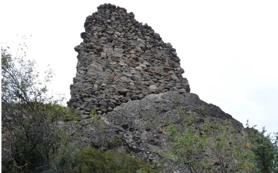
Figure 10: Parement externe du mur MRb1 et sa méthode d'enrochement (cliché B. Oury, 2014).
