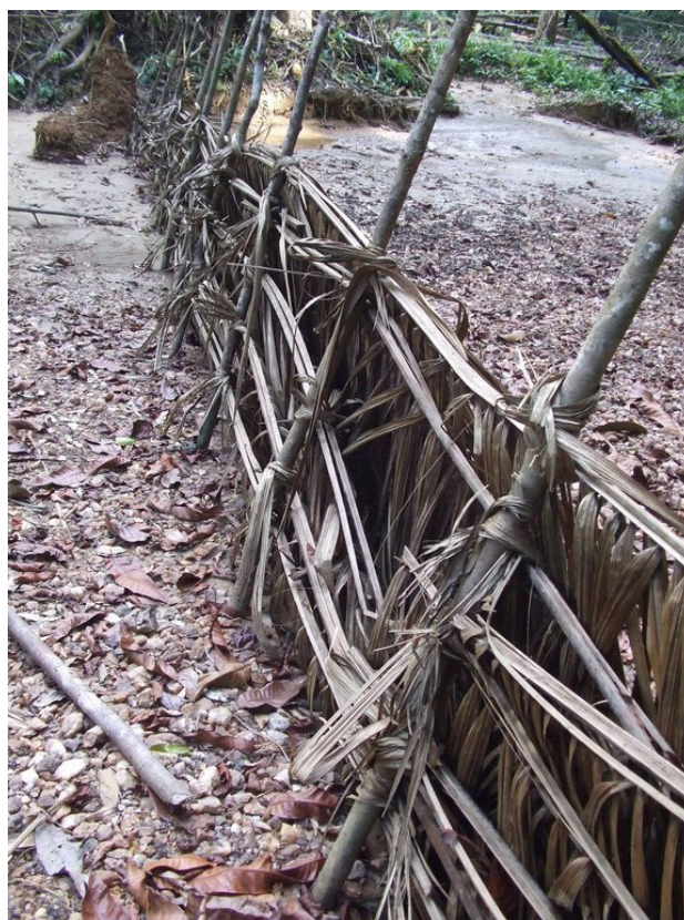
Figure 10 Barrage de palmes sur une crique, travaux clandestins actuels
