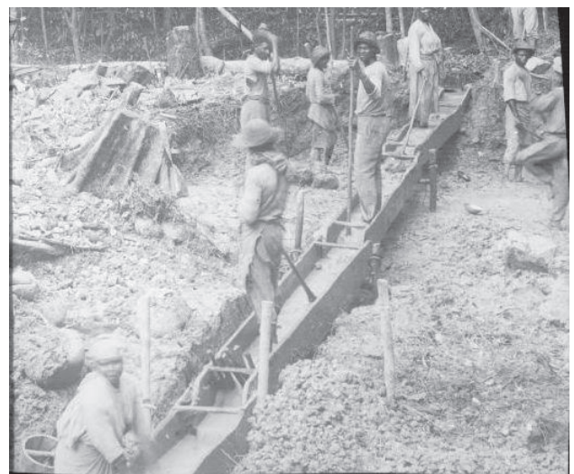
Figure 8 Crible en bois installé dans le sluice (photographie ancienne)
