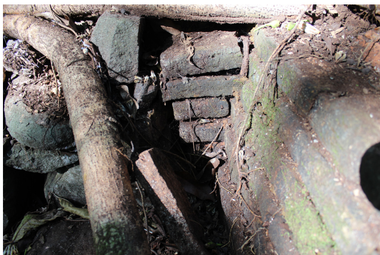
Figure 5 Mur de briques enchâssé dans le glacis
