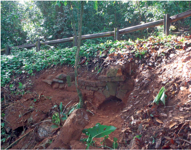
Figure 4 Galerie voûtée traversant la voie d'accès (aqueduc?)
