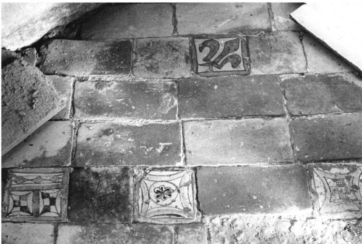
138 - Studium di Benedetto XII, riparazione tardiva con formelle rettangolari e reimpiego di formelle calcaree.
