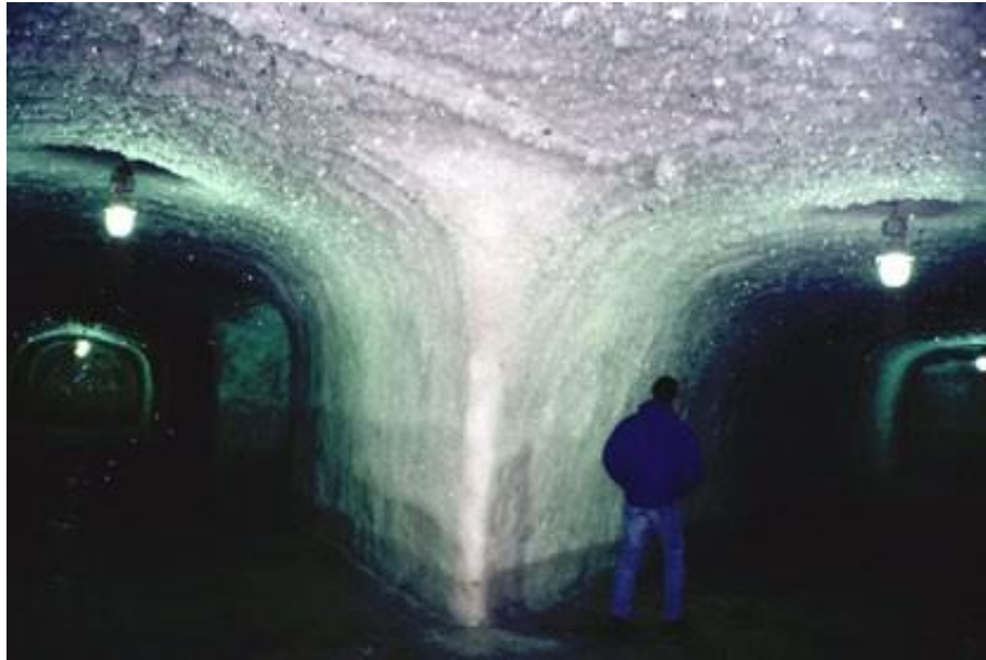
Ancien tunnel creusé dans le pergélisol à haute teneur en glace pour Gazprom, à Iambourg.
