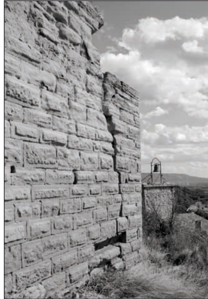
Fig. 7: Appareil à bossage sur une tour de Saumane (Cliché F. Guyonnet, Direction du Patrimoine de L'Isle-sur-la-Sorgue, 2012)
