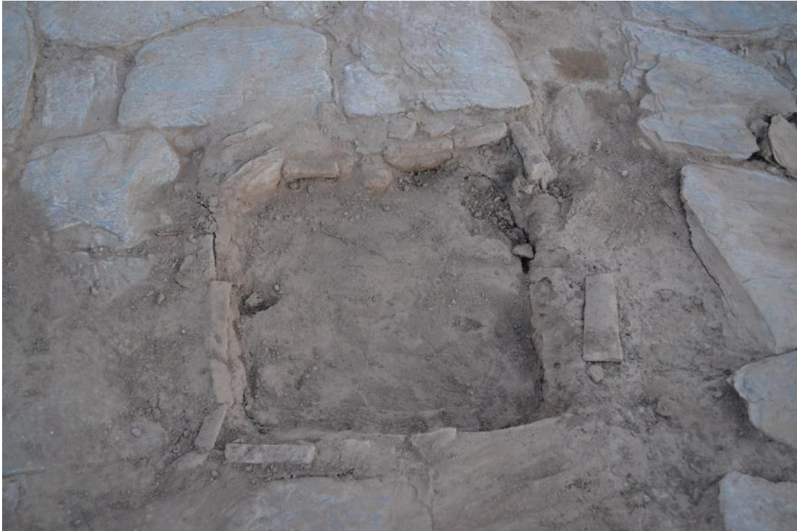
Fig. 50. Estado previo de la boca del aljibe en el patio central (estancia B)
