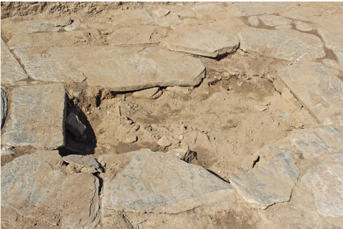
Fig. 47. Estado inicial del empedrado en el patio central (estancia B).
