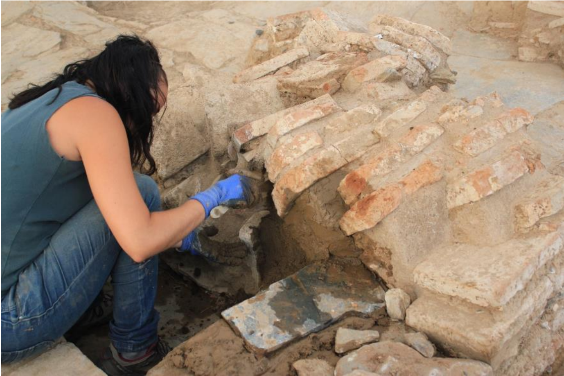
Fig. 30. Refuerzo estructural debajo de algunos ladrillos que corrían el riesgo de desprenderse en la jamba oeste del arco UE2263.
