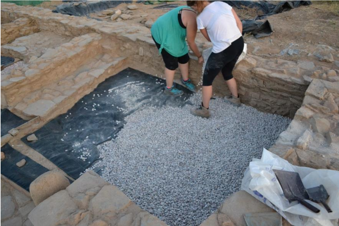
Fig. 34. Vertido de la grava en la estancia A1
