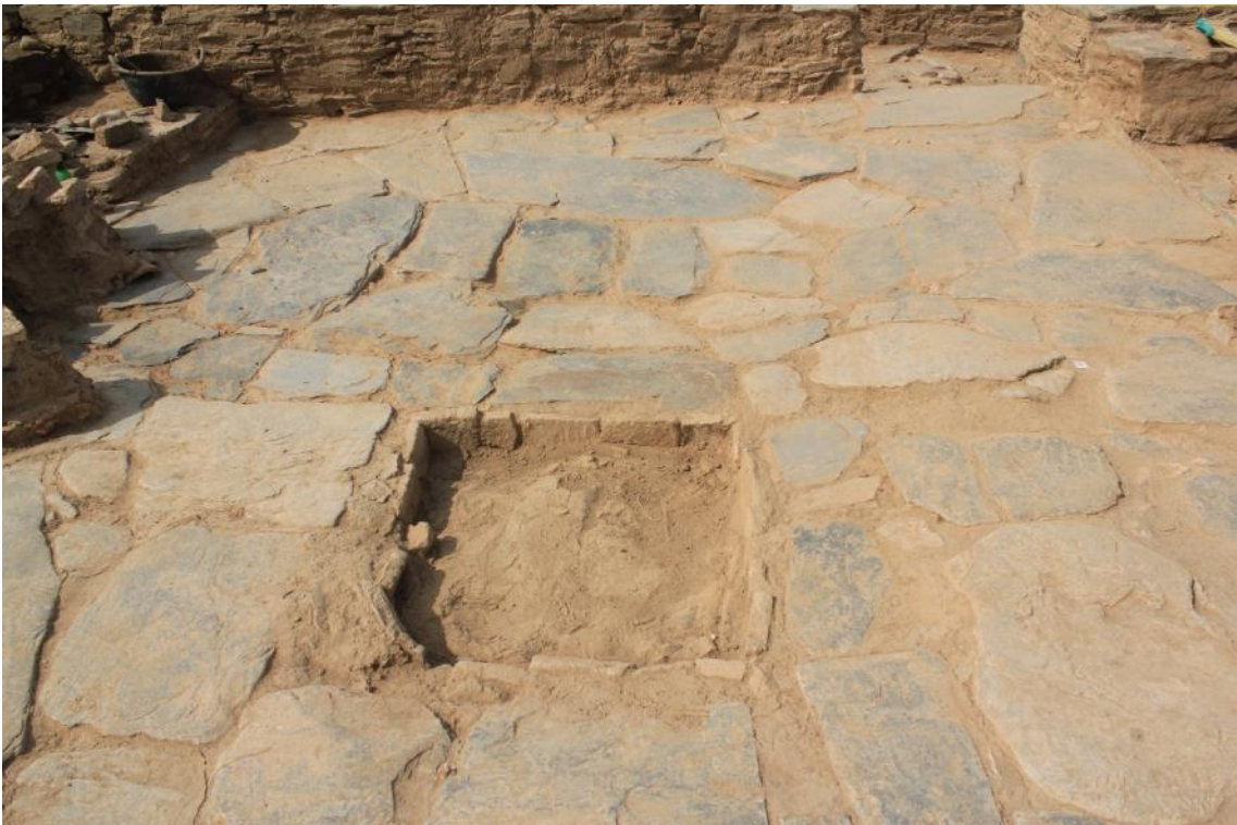
Fig. 27. Colocación de los fragmentos de ladrillo que faltaban en el enmarque de la boca del aljibe.
