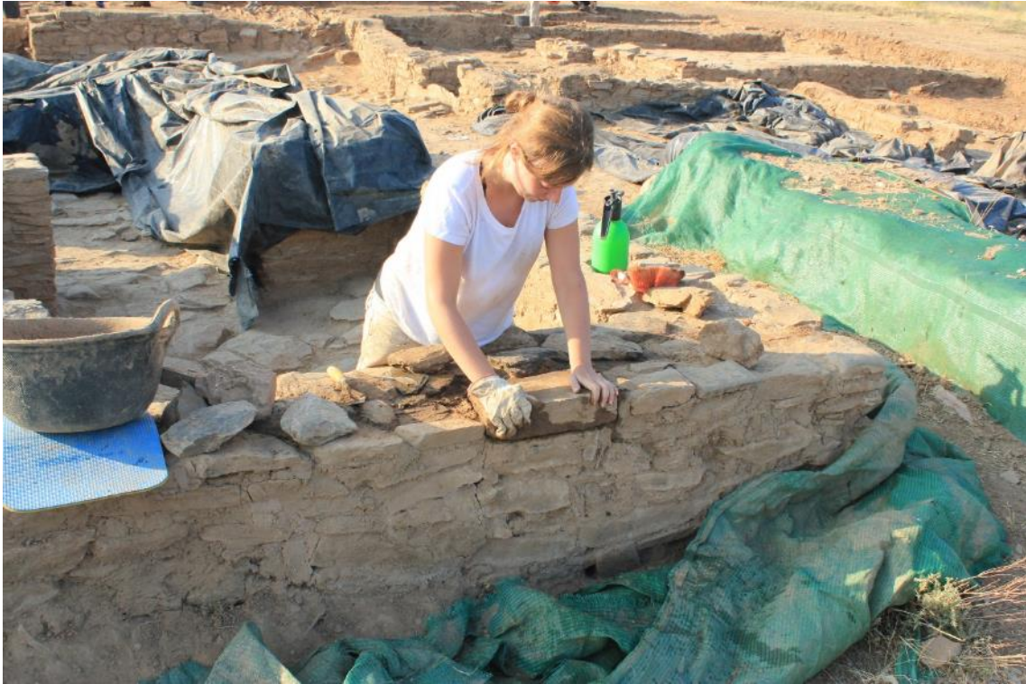
Fig. 20. Adhesión de las piedras de la nueva mampostería con morteros de tierra.
