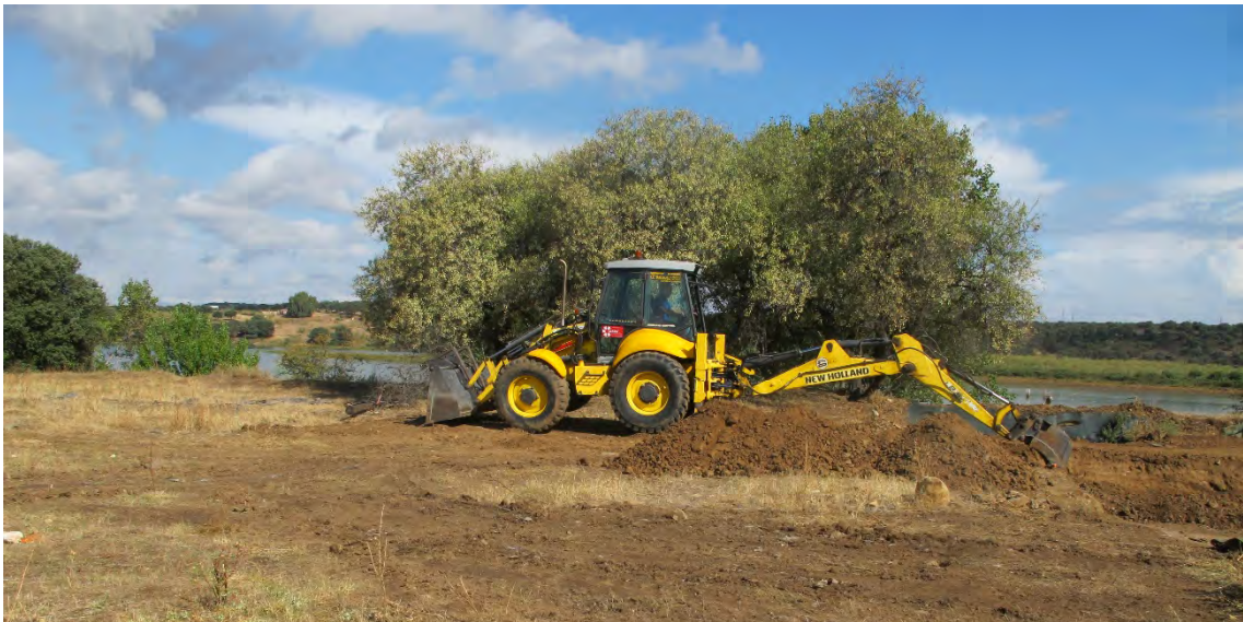
Fig. 2. Primera fase de la ampliación del sondeo 3.
