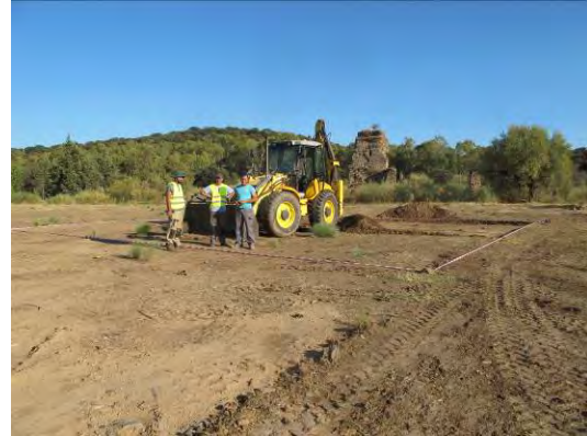
Fig. 1. Retira del nivel superficial con medios mecánicos en el sondeo 4, abierto este año.
