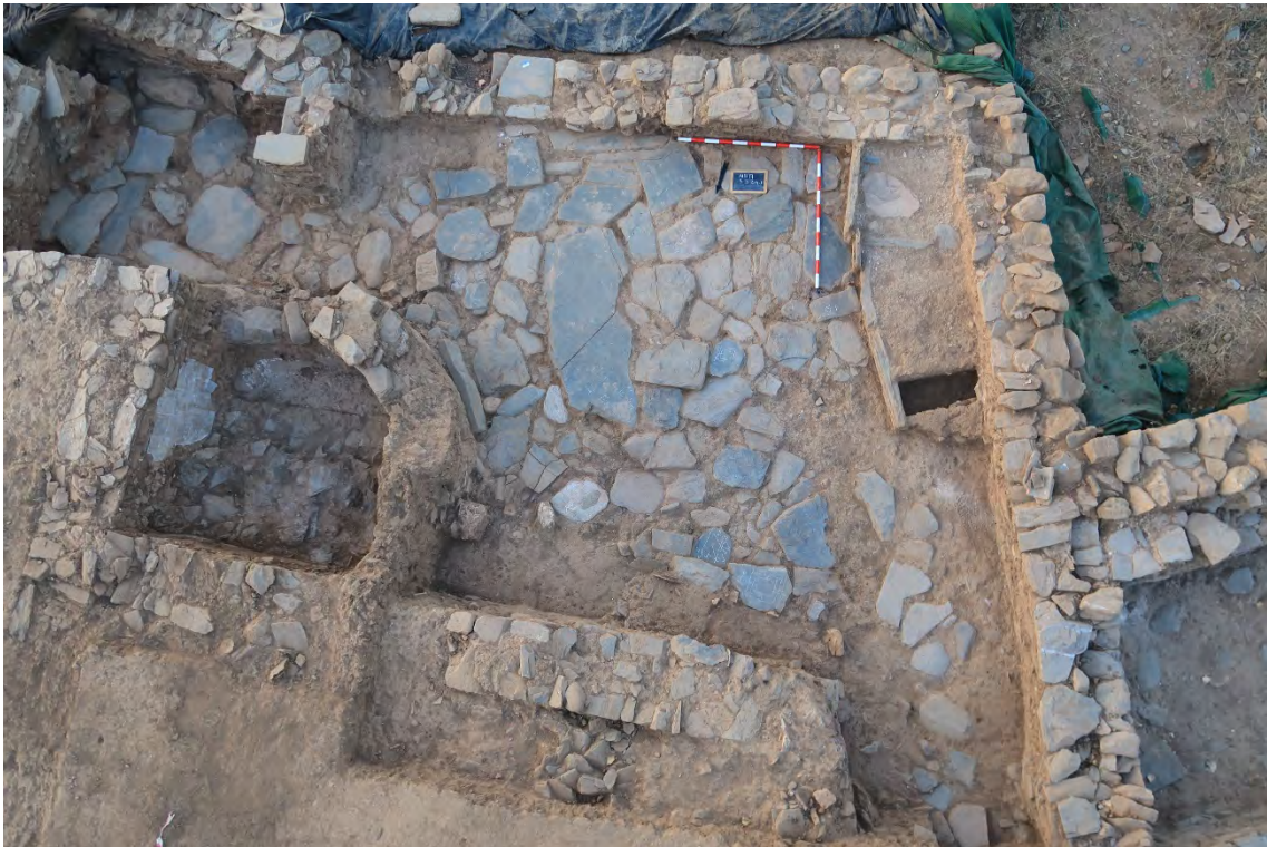
Fig. 90. Vista general del sector L4, con la pila de mampostería edificada en su esquina noreste (abajo a la izquierda en la foto) en curso de excavación.
