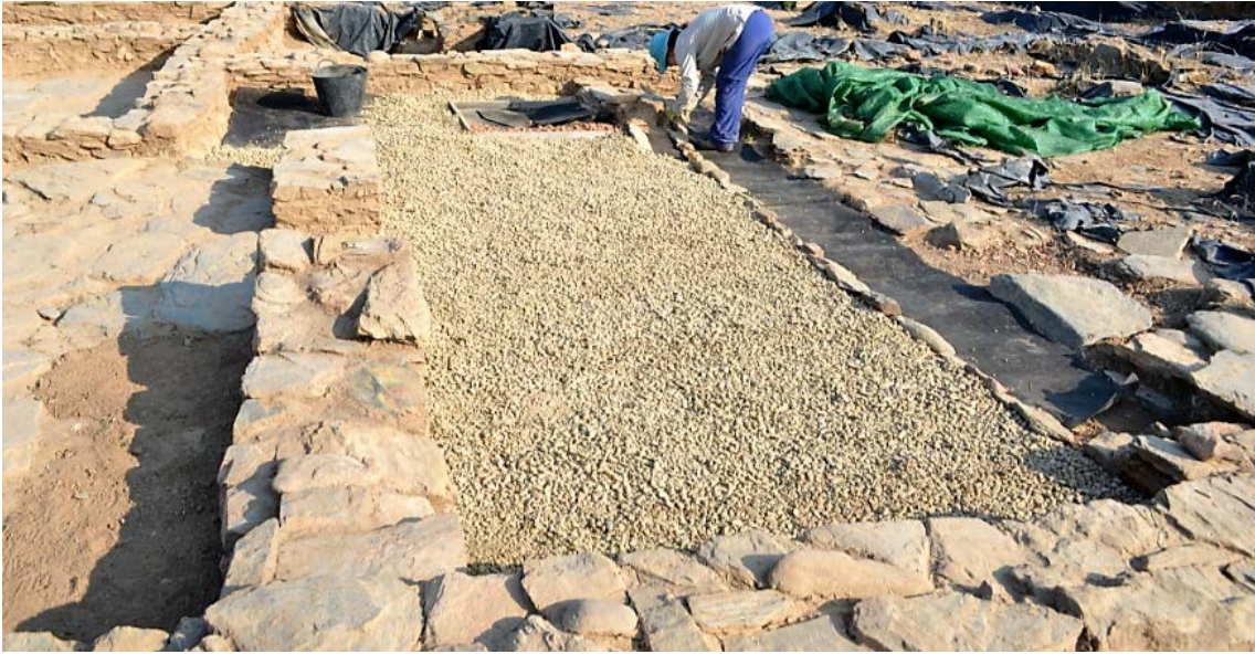
Relleno de las zonas de muro con picado de pizarra de la estancia B.
