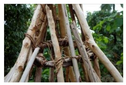
Figure 5: Interior ring *bunkar* on a damaged roof (Orodara region, June 25, 2016) Anneau intéreur *bunkar* visible sur un toit détérioré (Région d'Orodara, 25 juin 2016)
