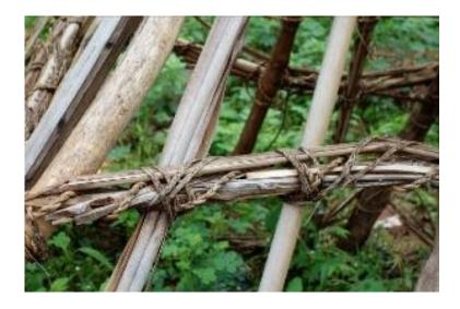
Figure 6: Interlacing *kaar-ja mon* on a damaged roof, Orodara region (June 25, 2016) Entrelacement *kaar-ja mon* visible sur un toit détérioré, région d'Orodara (25 juin 2016)
