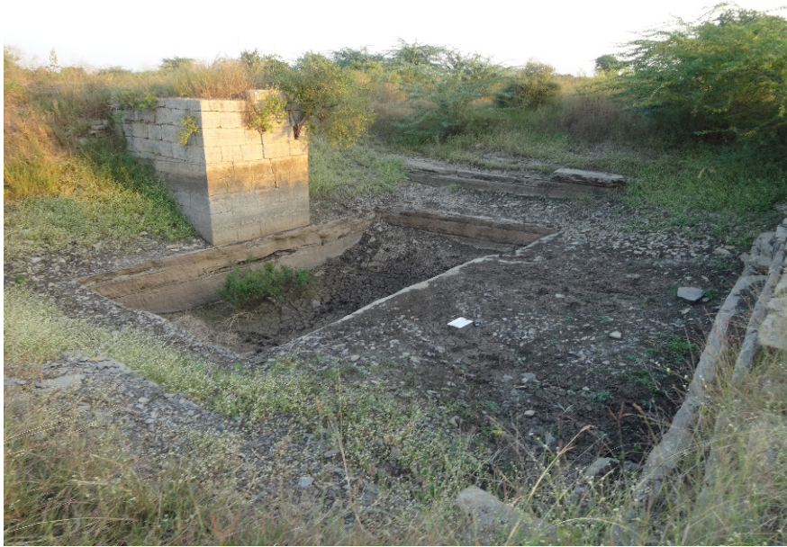
Figure 12 : bâoli surmonté d'un système d'élévation d'eau au nord de Firozâbâd
