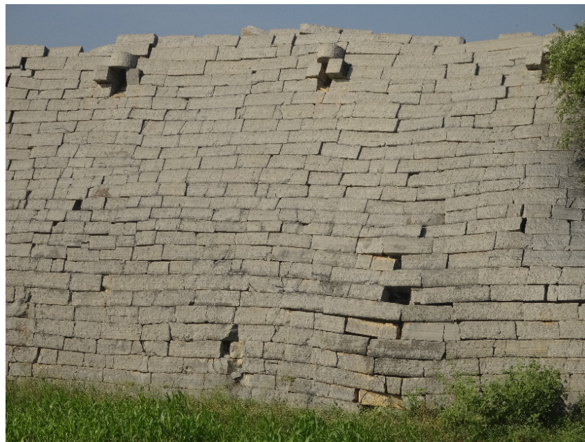
Figure 27 : bretèche capuchon sur la muraille est de Firozâbâd
