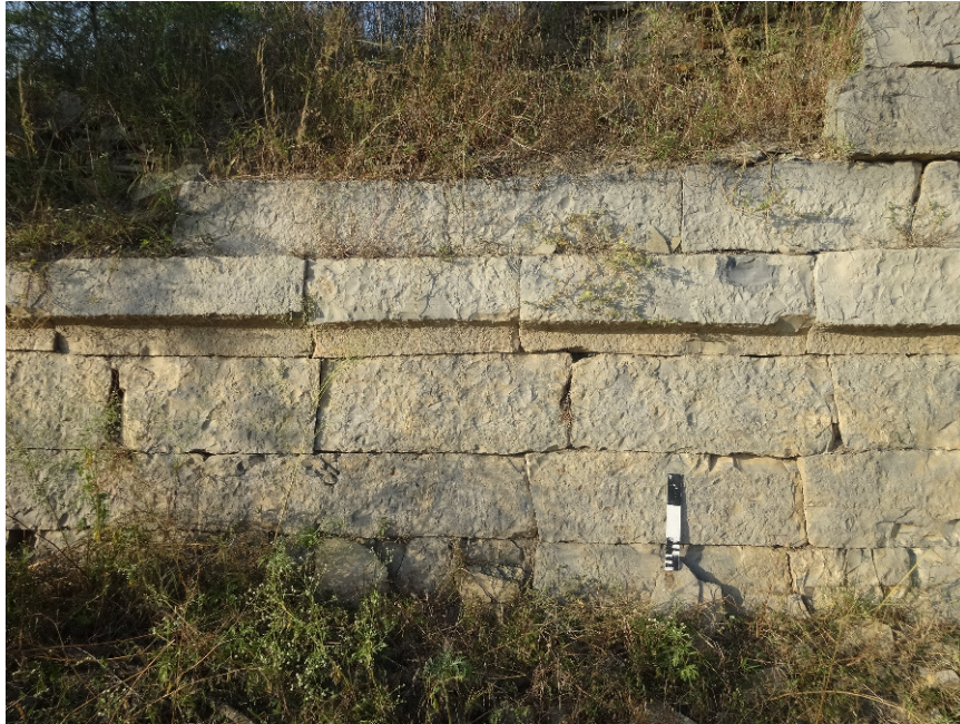
Figure 24 : bandeau de pierre horizontal sur la muraille accolée aux portes de la cité, Firozâbâd
