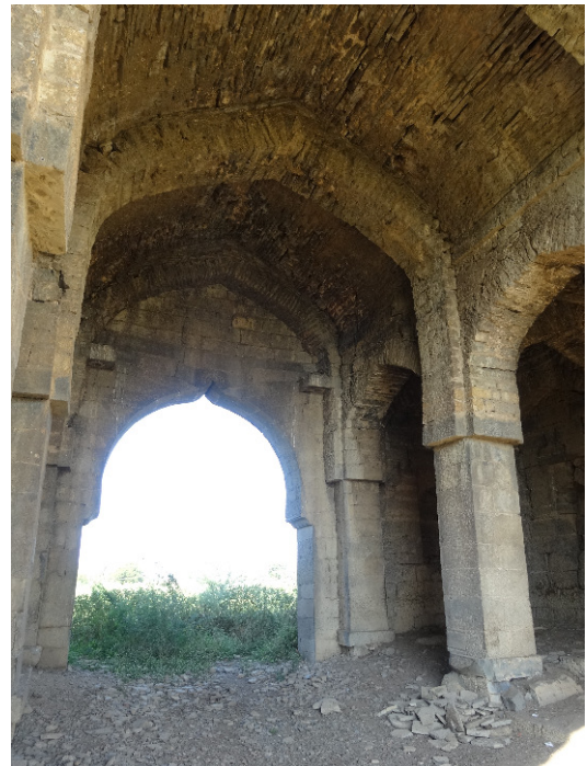
Figure 46 : intérieur de la porte nord
