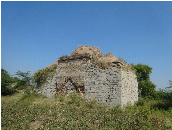
Figure 86 : ce bâtiment de Firozâbâd est un des premiers ḥammām construit dans le Deccan vers 1400 et illustre clairement un emprunt à l'architecture ottomane, probablement en raison du développement des relations, notamment commerciales, entre l'Inde et le Moyen-Orient 188
