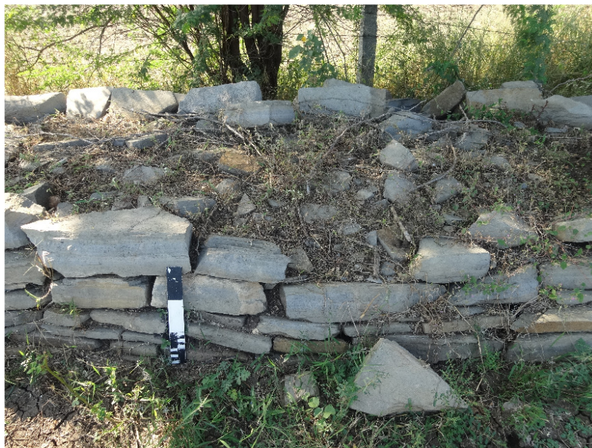
Figure 21 : base de mur conservé entre pt. 20 et 21, muraille sud-ouest
