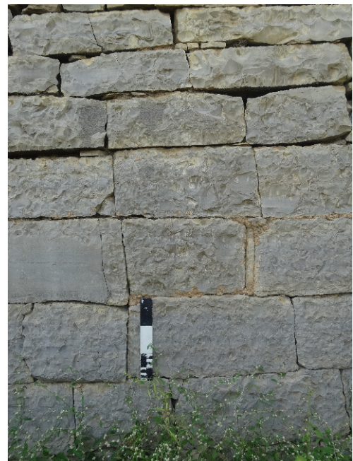
Figure 49 : détail de la mise en œuvre et des assises du parement extérieur, muraille nord
