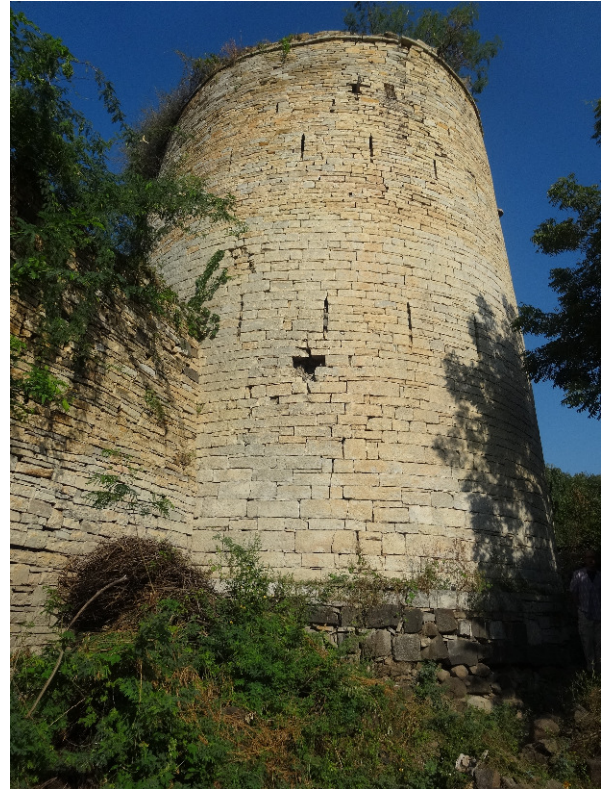
Figure 114 : tour sud-est du fort
