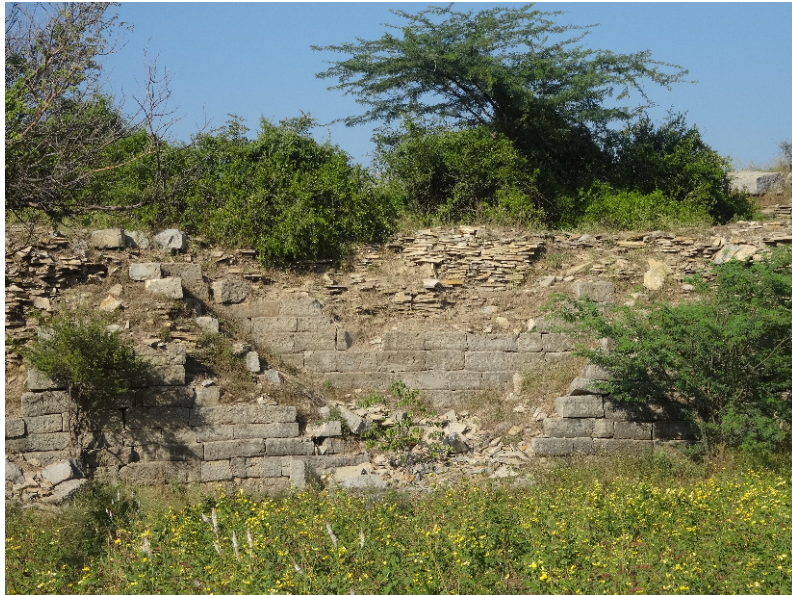
Figure 19 : escalier conservé sur l'intérieur de la muraille nord
