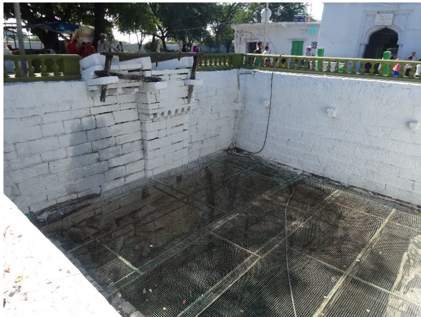
Figure 13 : puits réservoir devant la dargâh . Le système d'élévation et de répartition de l'eau est bien conservé
