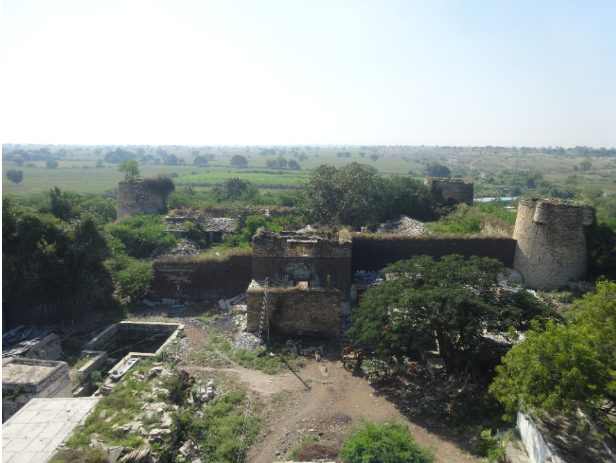
Figure 110 : vue d'ensemble du fort de Marthur depuis le nord
