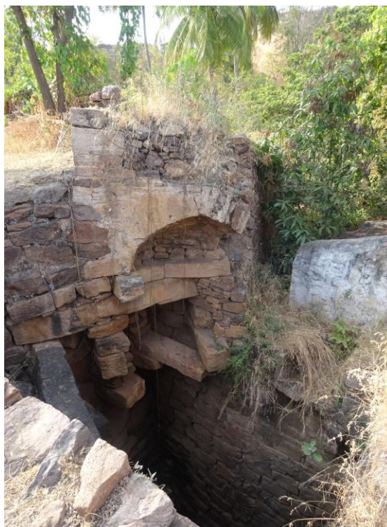
Figure 29 : la tour 35 abrite un puits avec un système d'élévation d'eau à l'est
