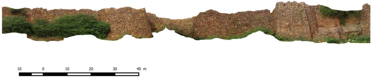
Figure 112 : enceinte sud avec les tours 33 et 34
