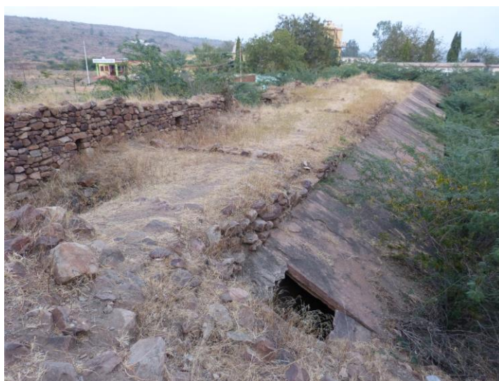
Figure 152 : vue du premier niveau
