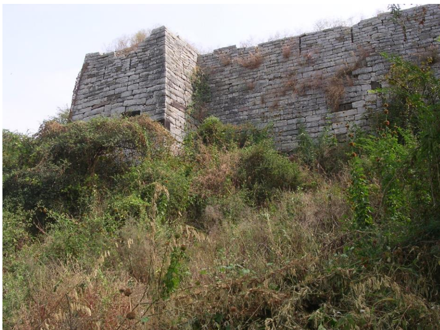
Figure 40 : mise en oeuvre similaire sur les tours quadrangulaires de Malkhed (crédit ROTZER, 2007)
