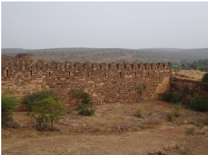
Figure 96 : réparation Bahmani ou Adil Shahi de la muraille entre la tour 56 et la porte 25 (à droite de l'image). Un haut crénelage est ajouté lors de cette reconstruction
