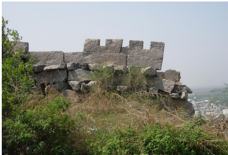
Figure 54 : crénelage monolithique sur un des parapets du fort de Bhongir (Telangana)
