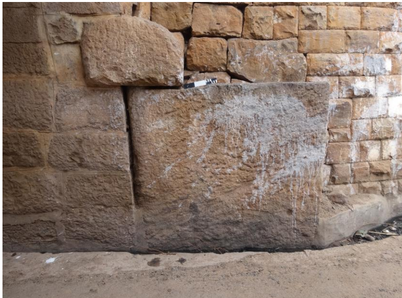
Figure 71 : porte monolithe en pierre et sa crapaudine à la base de la porte 5c
