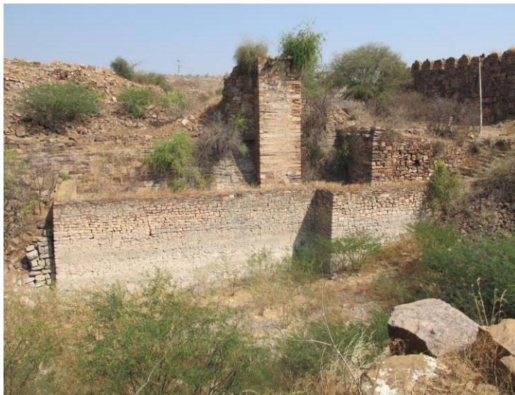
Figure 24 : tour de puisage de Torgal aménagé au-dessus du puit Adil shahi recreusé dans une bâoli plus ancienne
