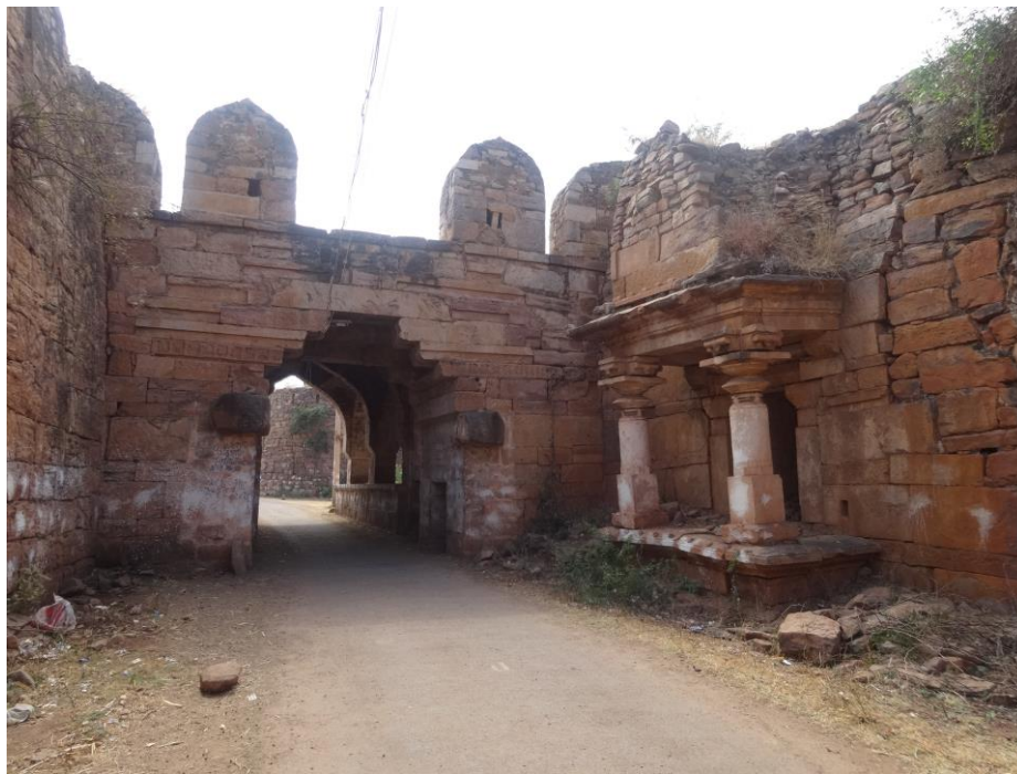
Figure 92 : façade de la porte Katla Agshi (5B) et du petit temple associé (les merlons ont été ajoutés tardivement)
