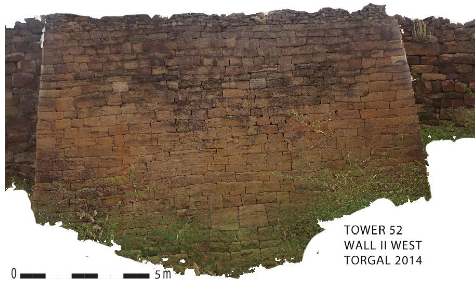
Figure 80 : tour 52, réfection et allongement de la tour Hoysala au cours du 14 ème siècle pour améliorer le flanquement de l'enceinte fortifiée et protéger le revers de la porte 6
