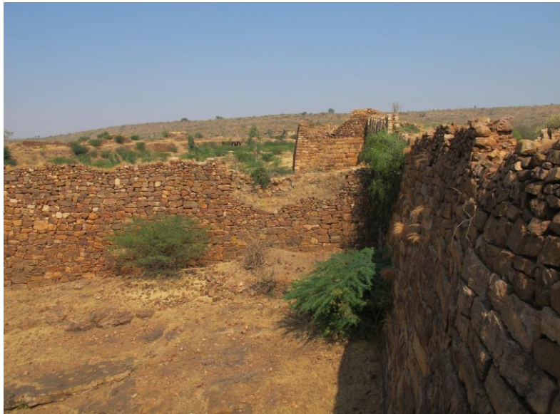
Figure 75 : coup de sabre sur le front de la tour carrée englobée de wall II dans wall I (au centre ouest) entre les tours 55 et 28. Le sommet de la tour est bûché afin de créer un escalier pour circuler de la courtine de l'enceinte Hoysala vers la nouvelle courtine à l'ouest.
