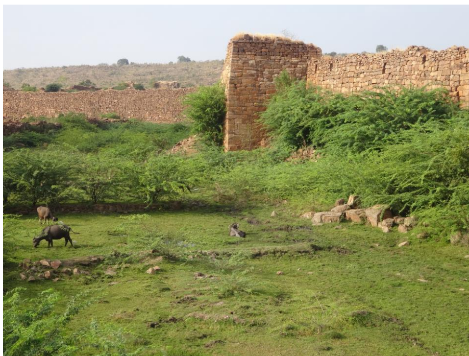
Figure 62 : vue du fossé sud
