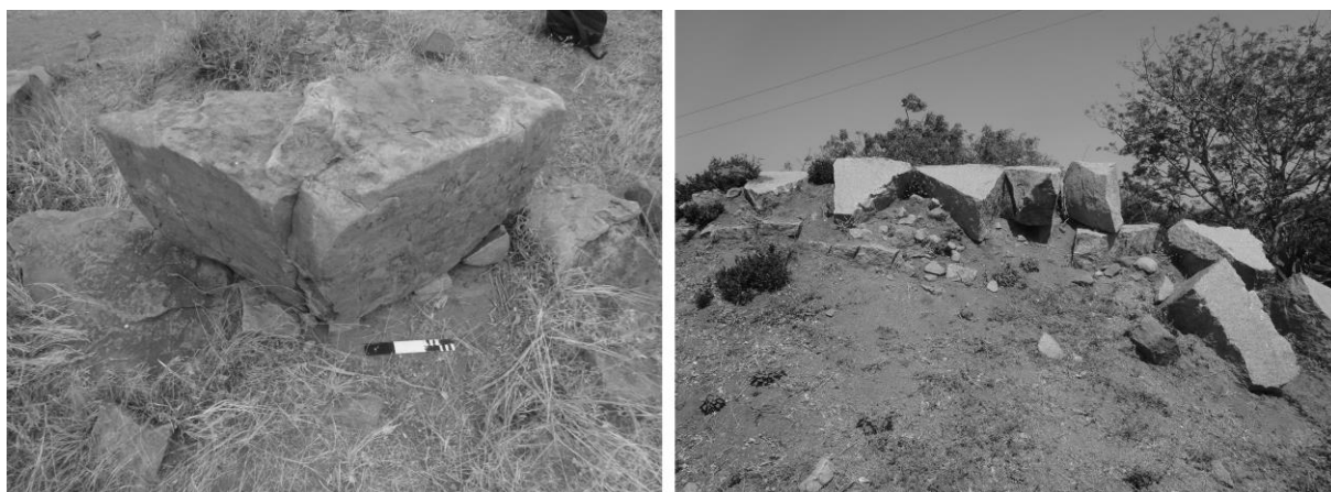
Figure 106 : comparaison de la reprise du modèle de l'enceinte urbaine de Vijayanagara (à droite) pour la mise en oeuvre et le calibrage des pierres de la fortification avancée de Torgal (module encore en place sur la porte 86 à gauche)
