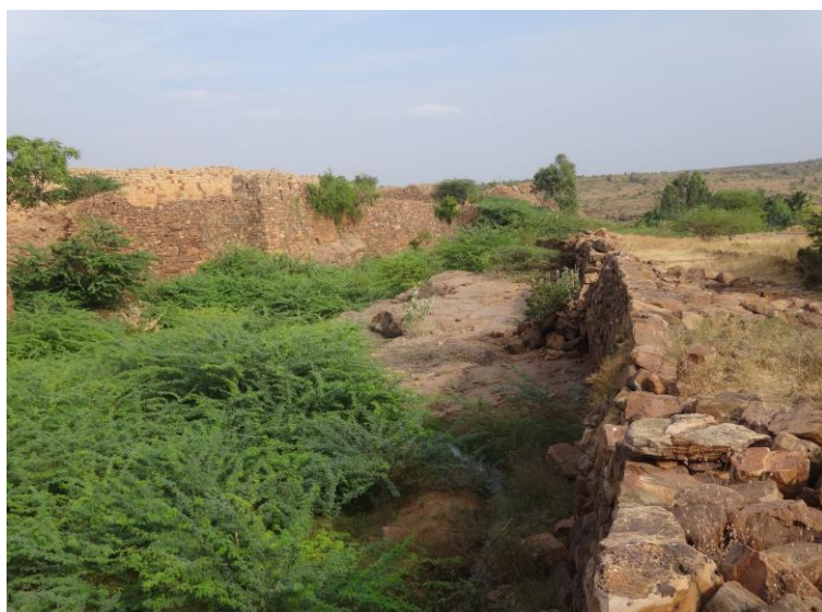
Figure 64 : vue de la contrescarpe sud
