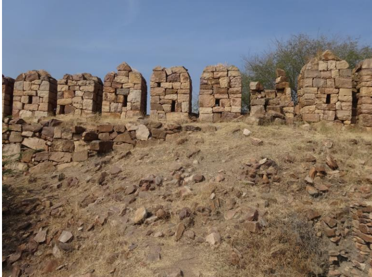
Figure 95 : parapet Bahmani avec de simples ouvertures de tirs droit aménagées dans les merlons
