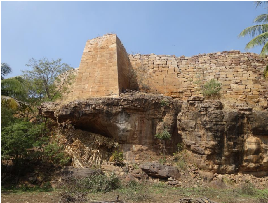
Figure 38 : la tour 61 est construite en même temps que la muraille
