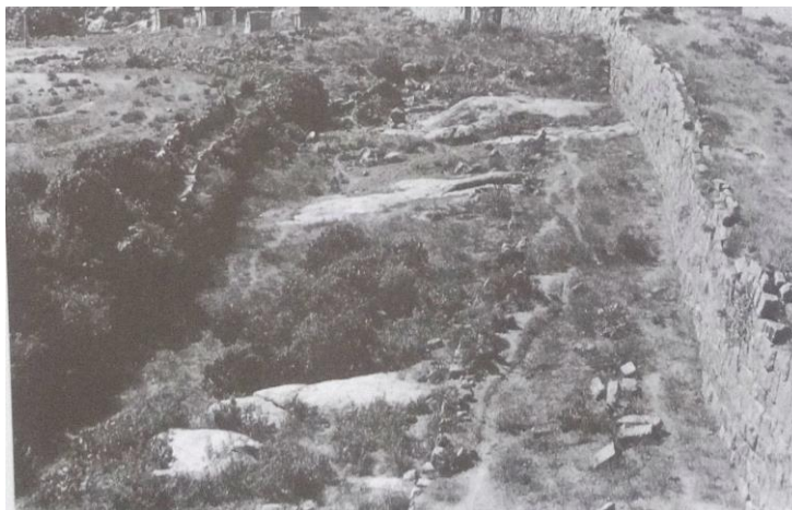
Figure 111 : renforcement de la seconde enceinte avec épaissement de la courtine, Senji 359
