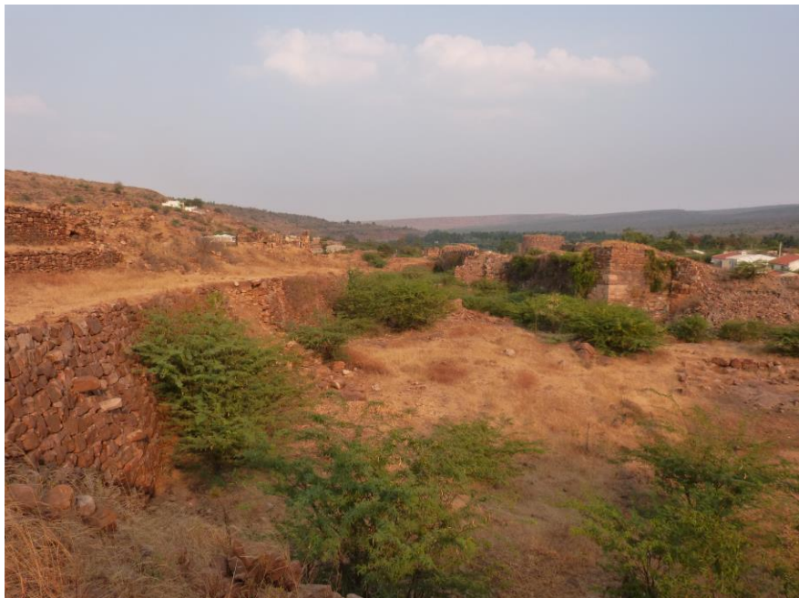
Figure 74 : fausse braye entre les deux lignes de fortifications au nord
