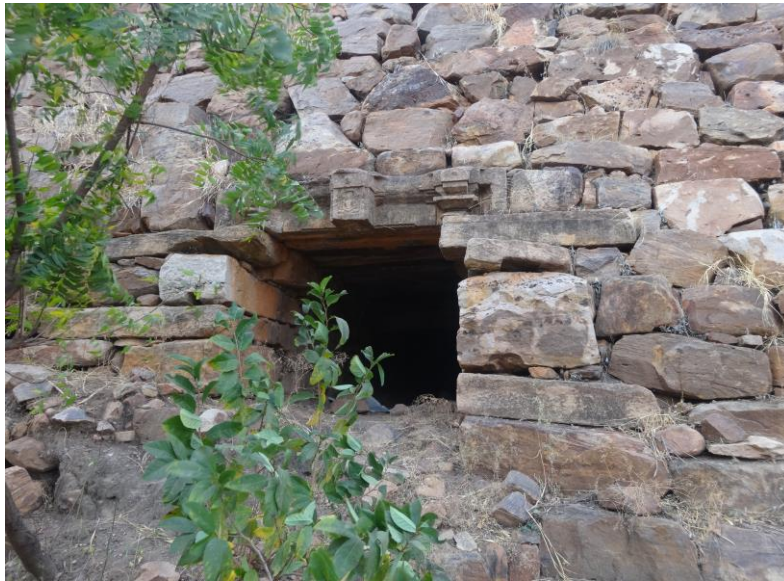
Figure 73 : le linteau de la poterne 25 est une réutilisation provenant d'un temple
