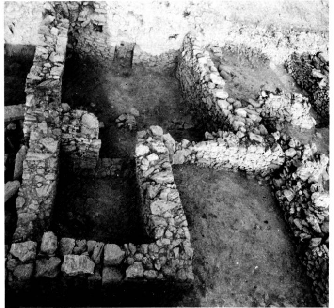
FIG. 6: Maison à l'ouest de la ruelle 1208 et de la cour 1051 (au premier plan) : pièces 1201 (avec porte bouchée 1203 sur la rue), 1050 (au fond la porte 1235), et entrée 1209, en direction de l'ouest. État 1981.
