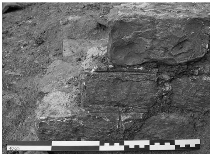
Fig. 7 – Porterie : détail de joints tirés au fer sur la façade extérieure, à l'angle des murs 788 et 789 (cliché : S. Jeandemange, Inrap).
