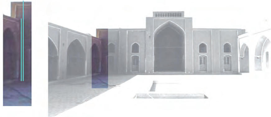
Fig. 5. Parties est et nord après restaurations et avant tremblement de terre. Comparaison des hauteurs ©ICHHTO.
