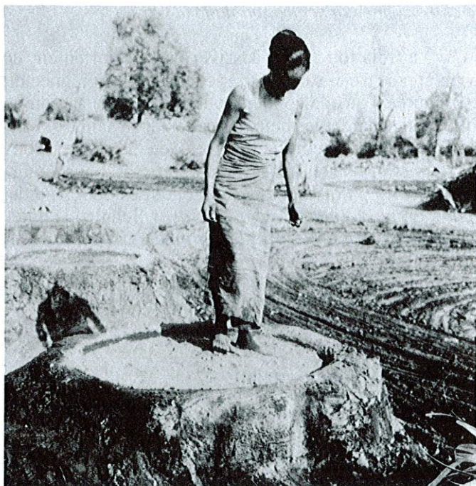
Fig. 15. Tassage de la terre dans le filtre
