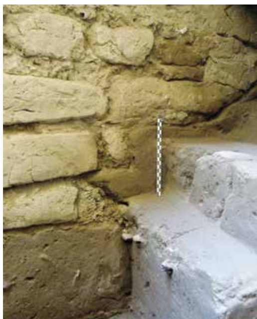
FIG. 22. Installation du mur L sur le mur E, lors d'une étape de réfection du bâtiment primitif.
