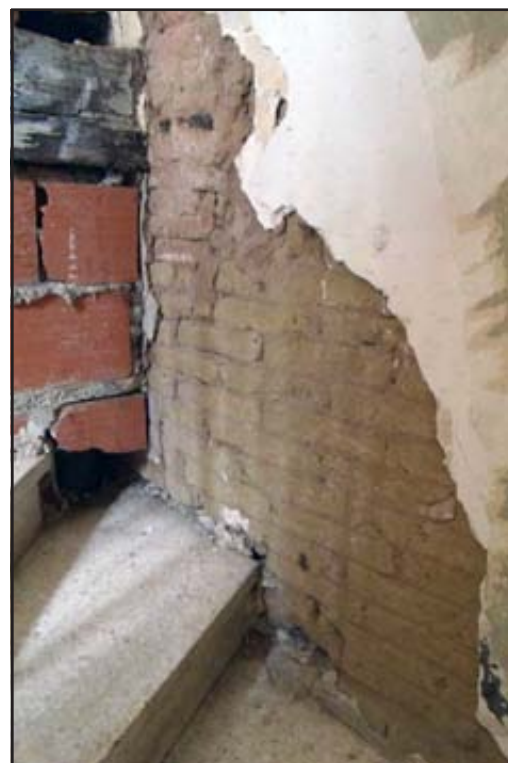
Figure 100 : la cloison en briques crues, depuis l'escalier actuel
