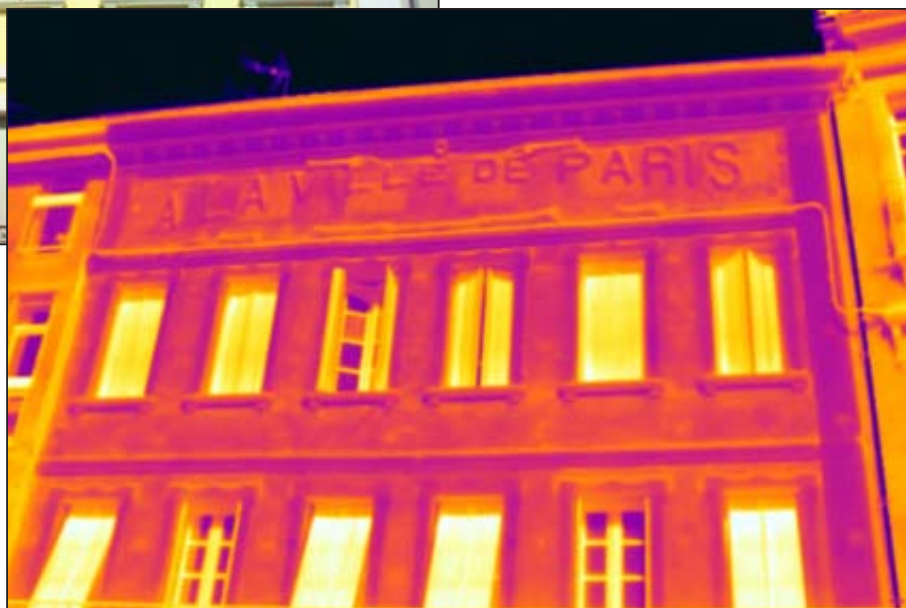
Figure 107b: cliché thermique de la façade méridionale (détail)
