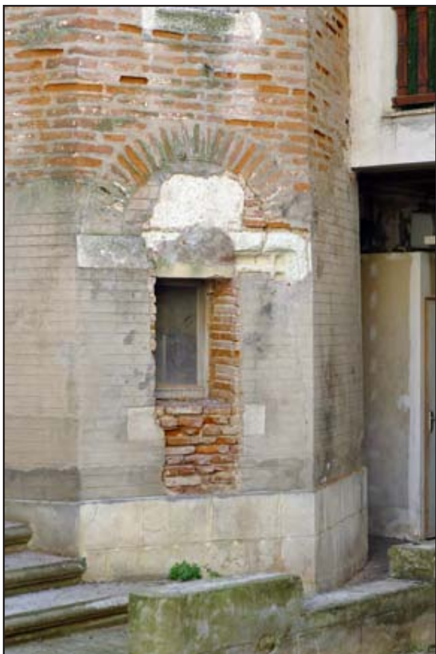
Figure 60 : bâtiment B, l'ancienne porte d'accès à la tour transformée en fenêtre
