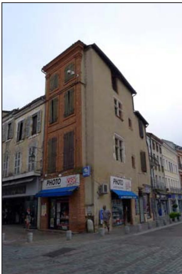
Figure 93 : vue générale du bâtiment à l'angle des rues de la République et Malaveille
