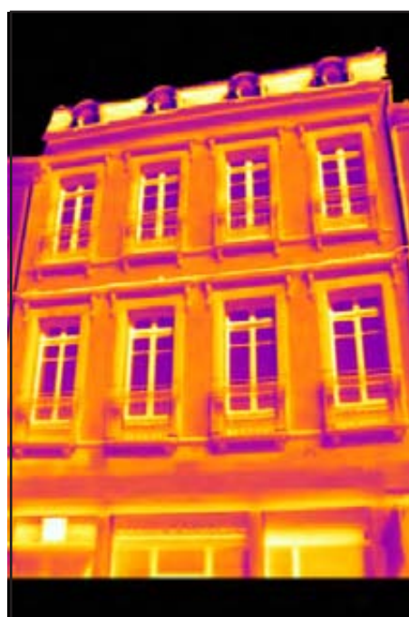
Figure 110b : cliché thermique de la façade méridionale (détail)
