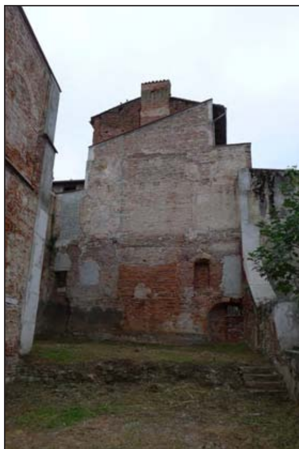
Figure 128 : vue générale du MUR04
