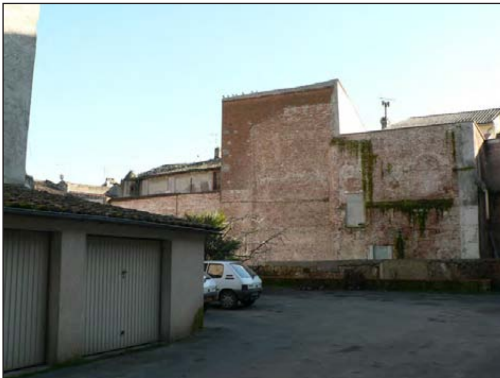
Figure 41 : le parking avec, à droite, les boxes pour voiture
