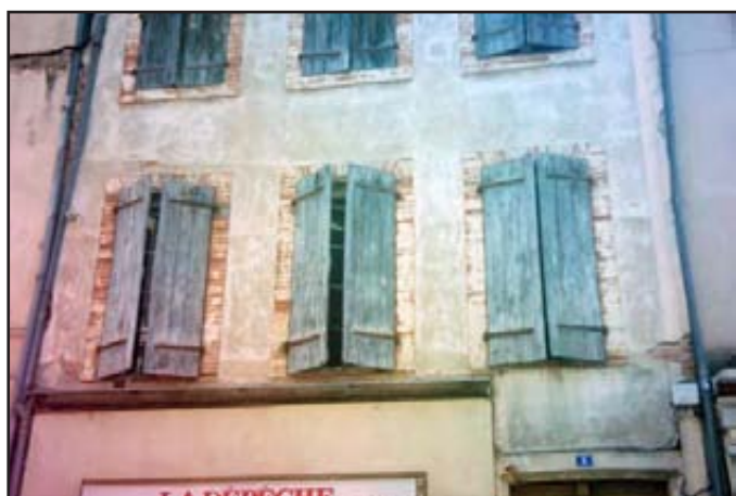
Figure 37 : a/ détail de la façade occidentale
