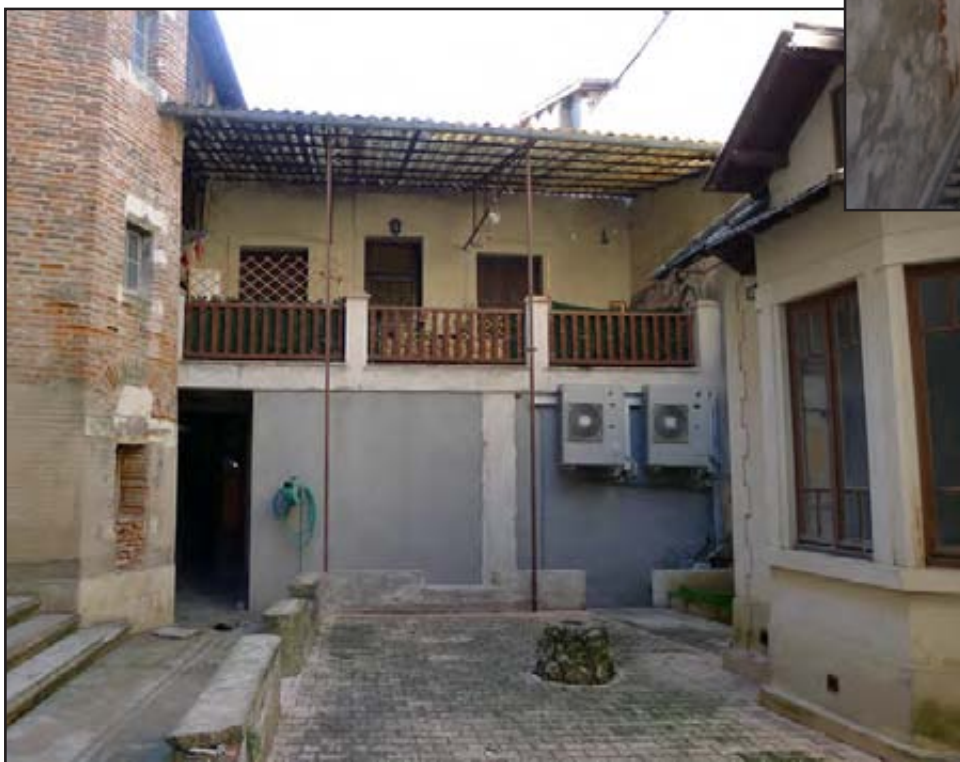
Figure 52 : bâtiment A, façade donnant sur la cour
