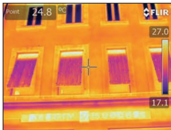
Figure 40: b/ cliché thermique u détail de la façade occidentale
