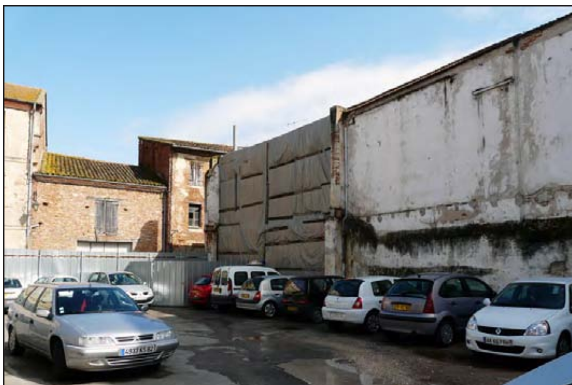
Figure 154 : l'état de l'élévation en 2010, Cl. E. Fayolle-Bouillon
