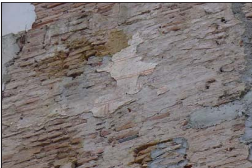
Figure 131 : l'enduit à décor de faux-appareil sur le MUR04
