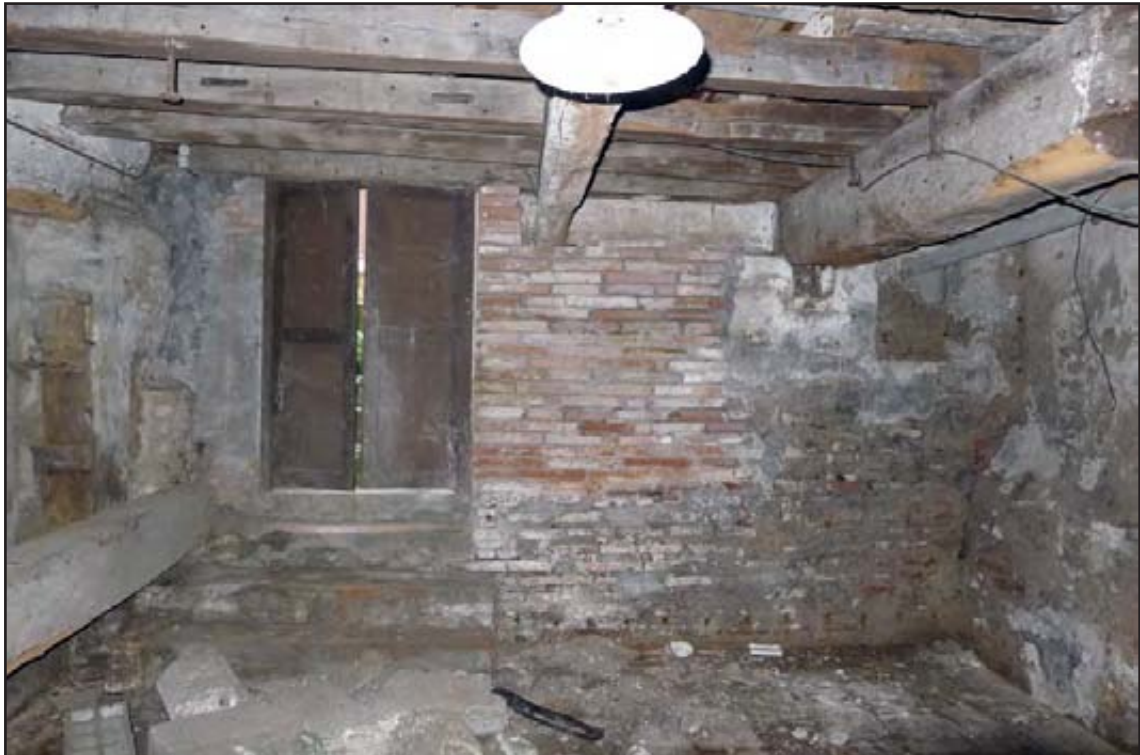
Figure 53 : bâtiment B, le sous-sol oriental vu depuis le sud
