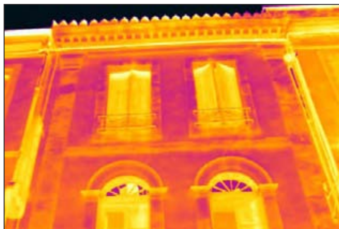
Figure 74b : cliché thermique de la façade occidentale (détail)
