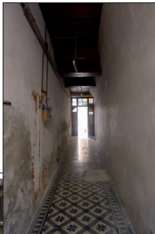
Figure 51 : bâtiment A, le couloir traversant
