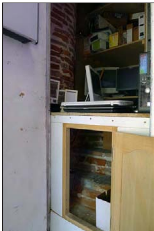
Figure 99 : l'embranchement de l'ancien escalier
