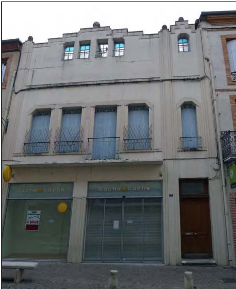
Figure 50 : bâtiment A, façade donnant sur la rue de la République
