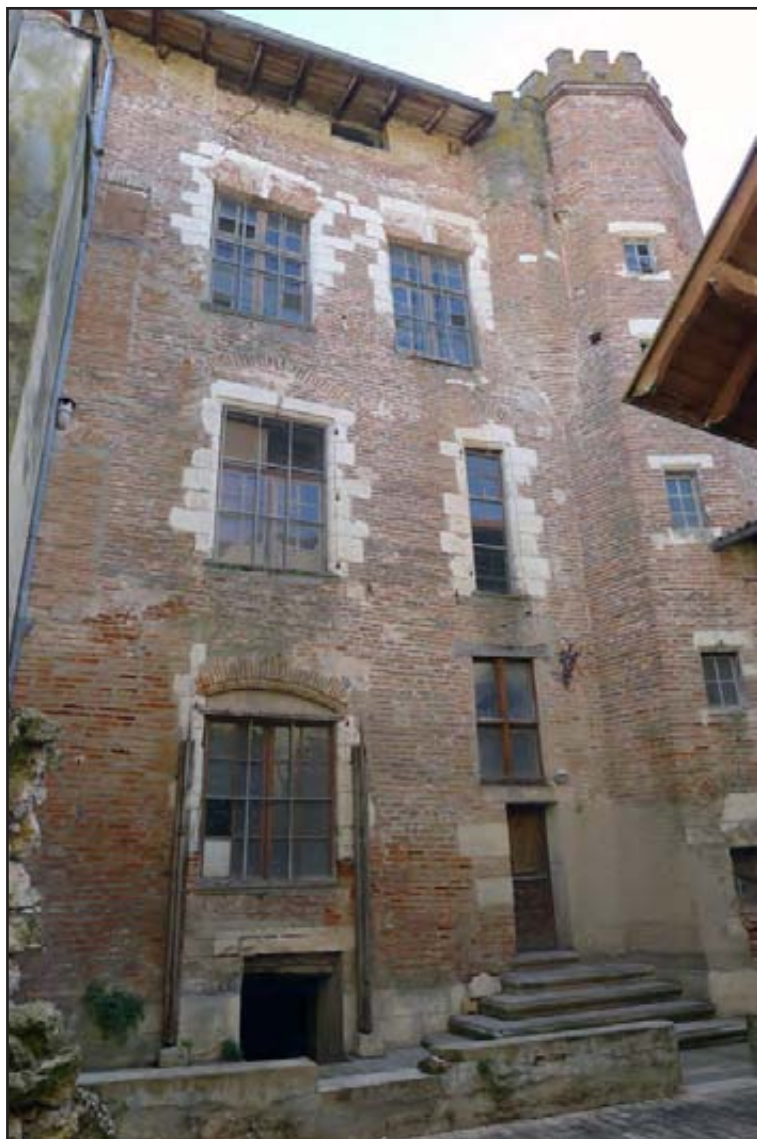
Figure 58 : bâtiment B, façade donnant sur la cour, fenêtre du premier niveau. On note les deux pièces de bois dont les extrémités sont sculptées de pinacles
