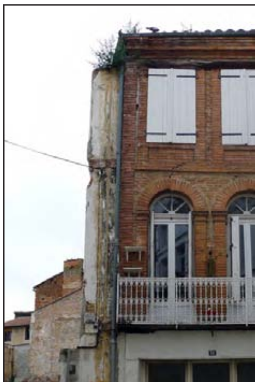
Figure 160 : détail de l'arrachement du MUR01
