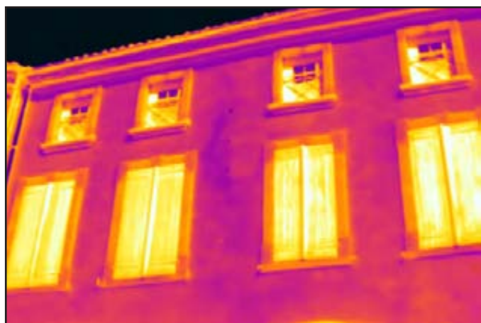
Figure 149b : cliché thermique de la façade méridionale (détail)
