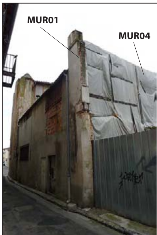
Figure 155 : le MUR01 depuis la rue des Mazels
