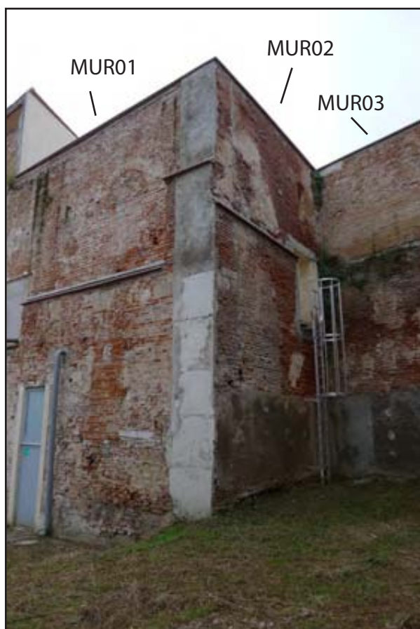
Figure 124 : vue générale des murs 01 et 02
