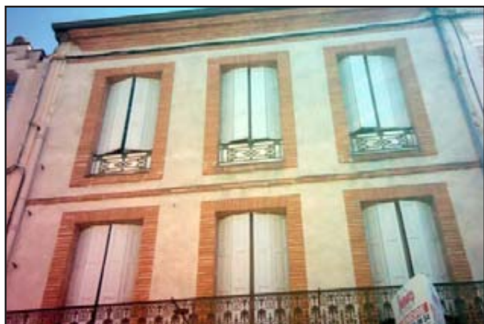
Figure 70a : cliché de la façade occidentale (détail)
