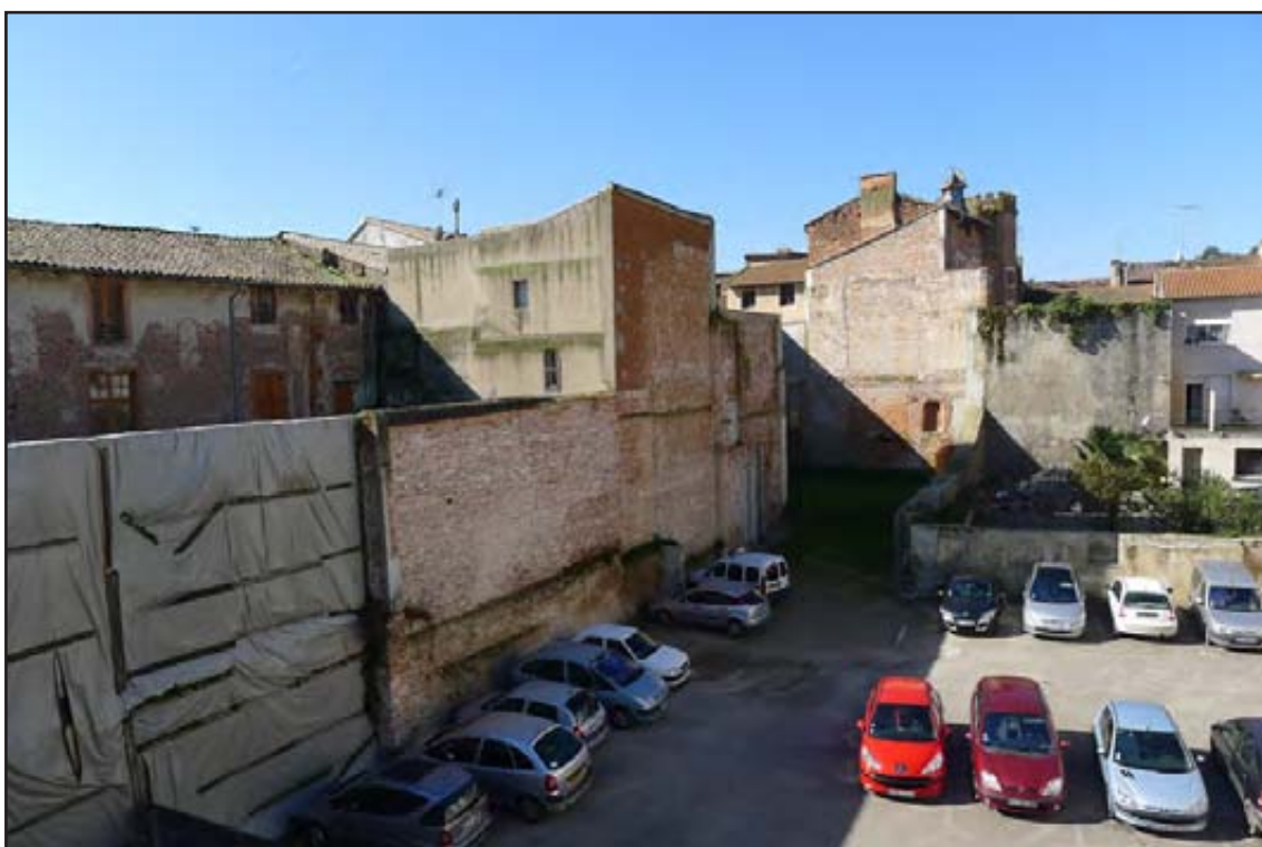
Figure 123 : vue générale des parcelles DK0551, 0552 et 1192
