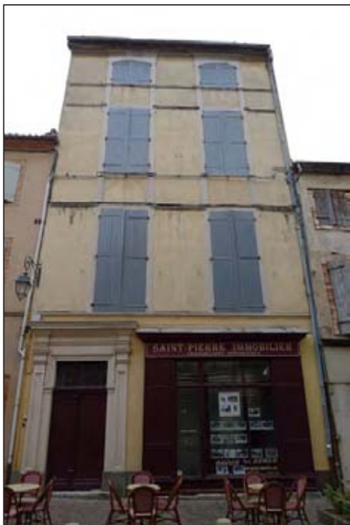
Figure 23 : bâtiment A, façade donnant sur la rue de la République
