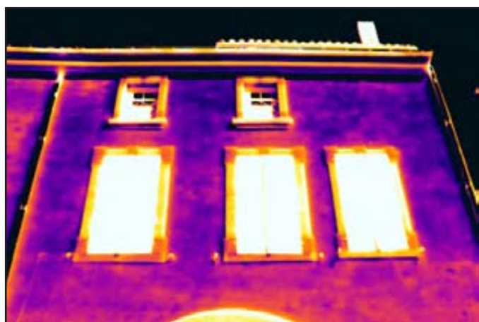
Figure 151b : cliché thermique de la façade méridionale (détail)
