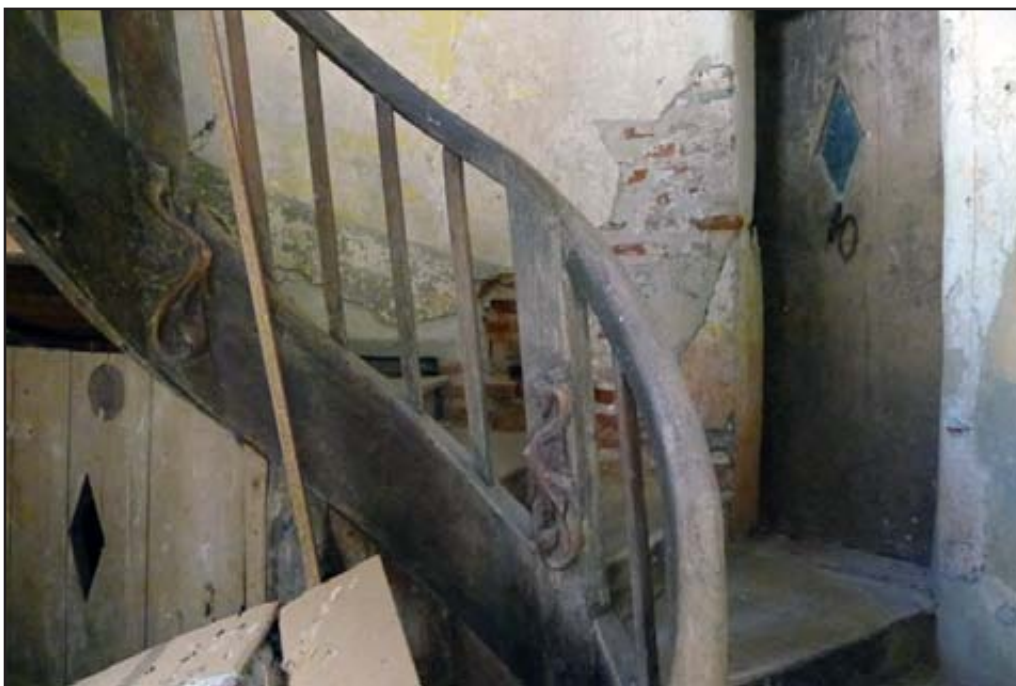
Figure 62 : bâtiment B, intérieur de la tour d'escalier. La structure actuelle recoupe le linteau de la porte donnant accès au sous-sol
