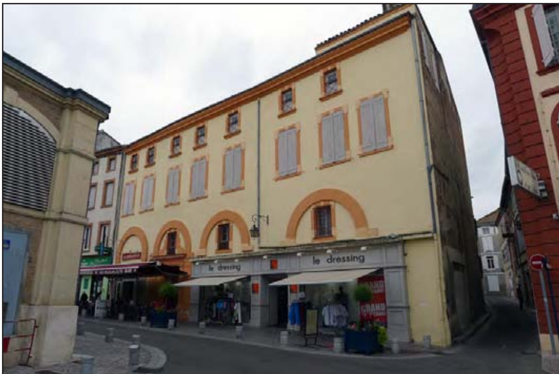
Figure 140 : vue générale de la façade méridionale, donnant sur la rue Malaveille
