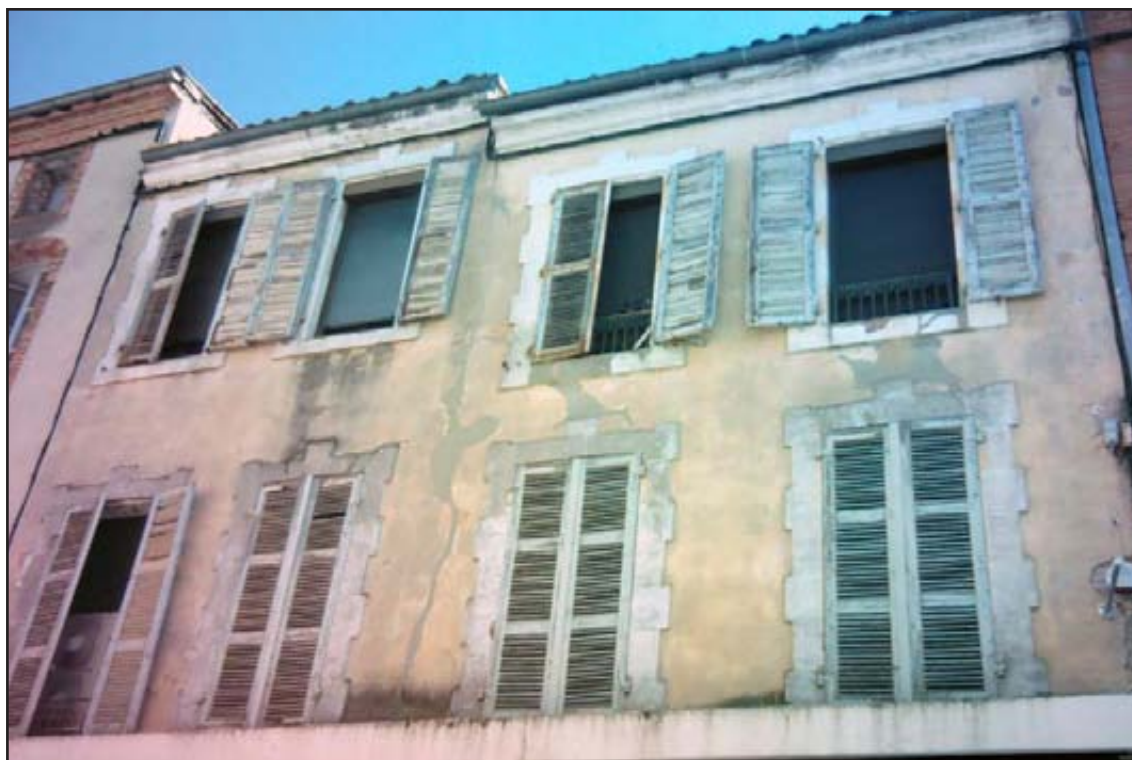
Figure 88a : cliché de la façade occidentale (détail)
