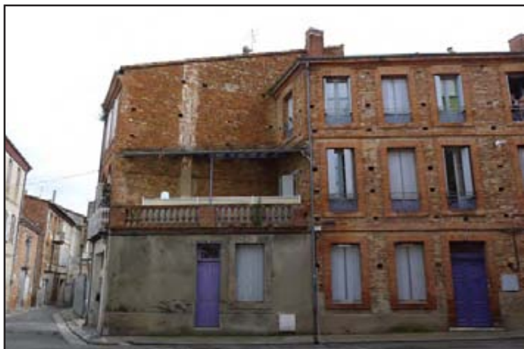
Figure 166 : cliché de la partie orientale de la façade septentrionale, donnant sur la rue Caillavet
