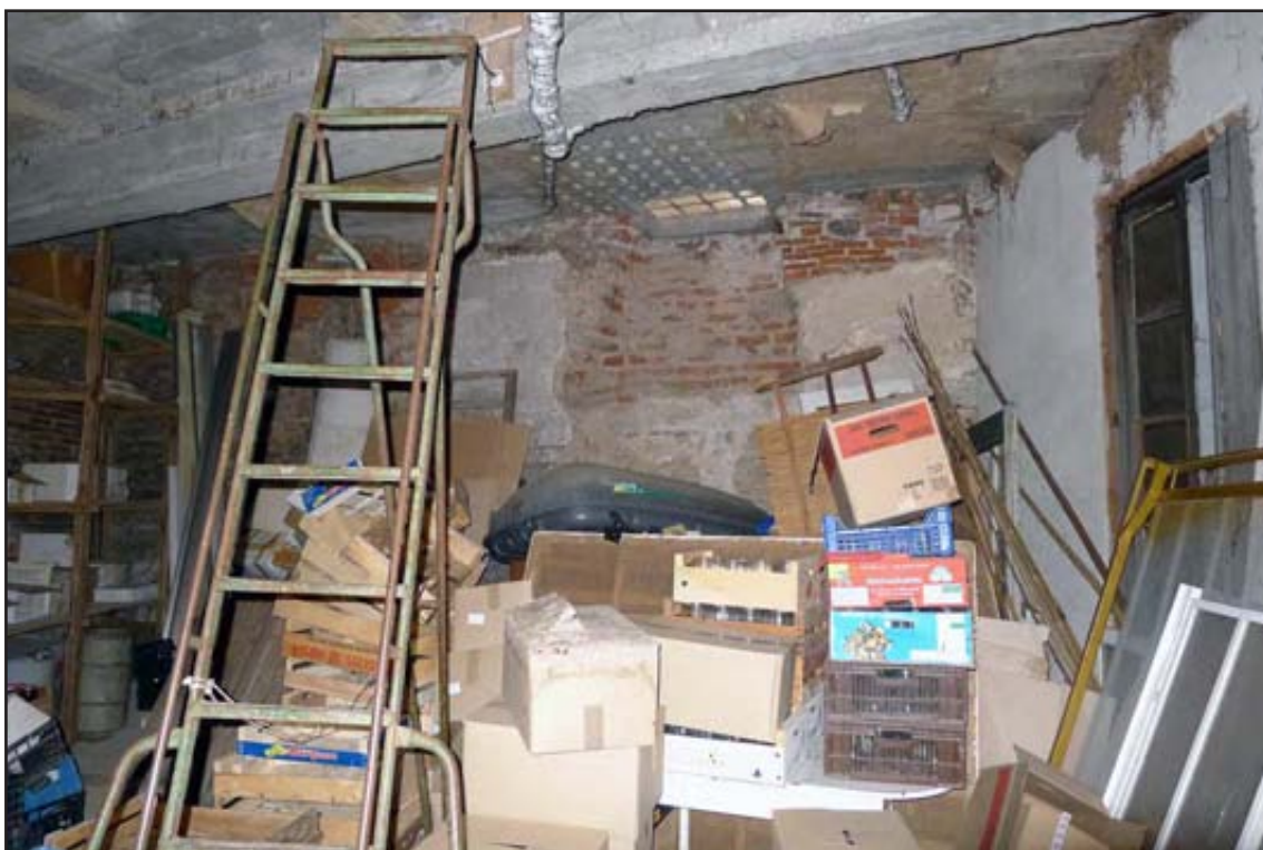
Figure 172 : cliché du mur méridional, depuis l'intérieur du premier niveau
