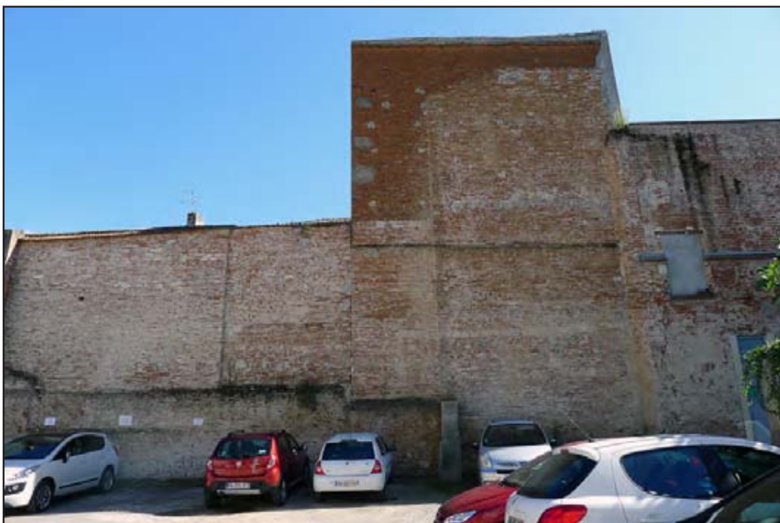
Figure 137 : vue générale de la façade septentrionale
