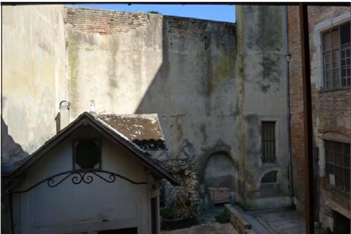
Figure 56 : la cour entre les bâtiments A et B
