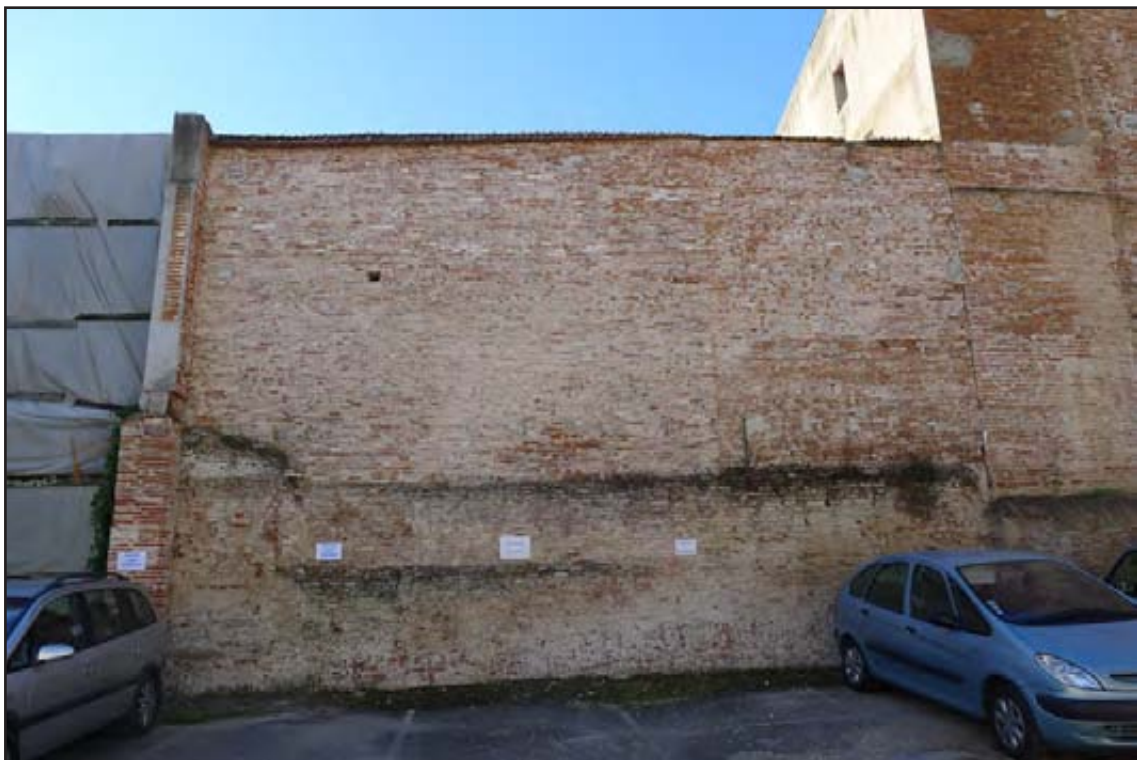
Figure 143 : cliché de la partie occidentale de l'arrière de la parcelle DK0538
