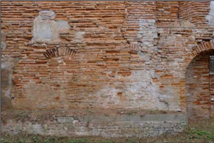
Figure 130 : la partie basse du MUR04
