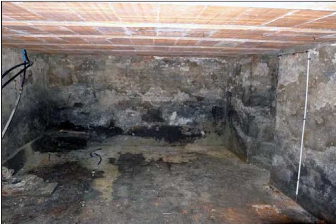
Figure 82 : cliché du niveau de sous-sol, vue vers l'est
