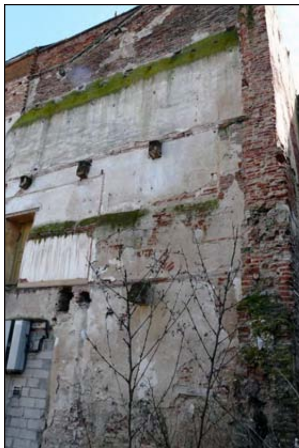
Figure 125: l'état du MUR01 en 2010, Cl. E. Fayolle-Bouillon
