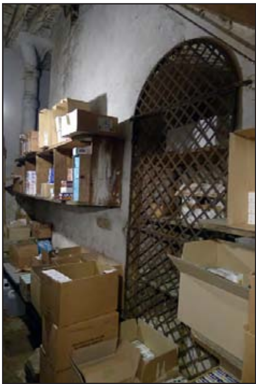
Figure 135 : une ancienne porte (?) en lien avec le bâtiment voisin à l'est
