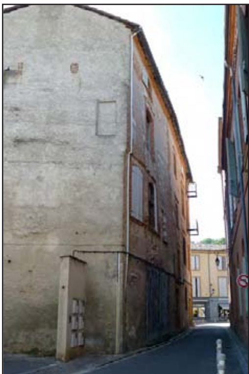
Figure 27 : l'angle nord-est du bâtiment B
