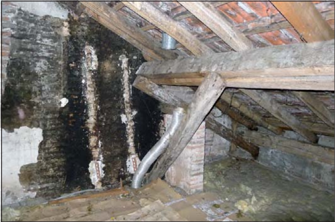
Figure 55 : bâtiment A, la charpente de comble
