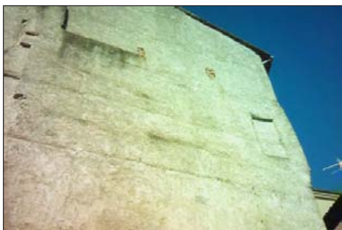
Figure 33 : a/ bâtiment B, détail de la façade orientale (partie haute)
