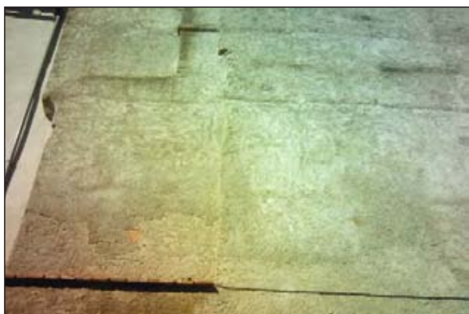
Figure 34 : a/ bâtiment B, détail de la façade orientale (partie médiane)
