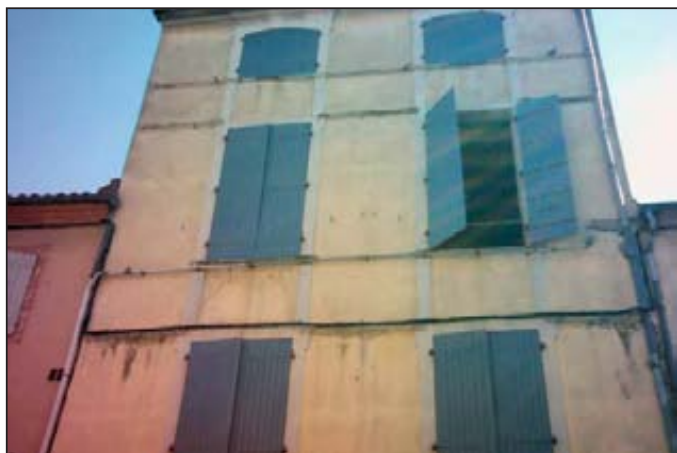
Figure 32 : a/ bâtiment A, détail de la façade occidentale
