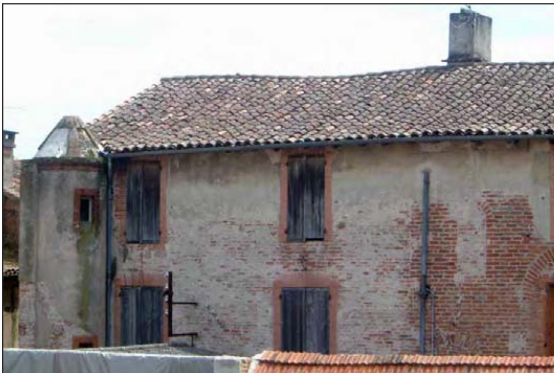
Figure 144 : détail de la partie orientale de la façade méridionale du bâtiment principal.
