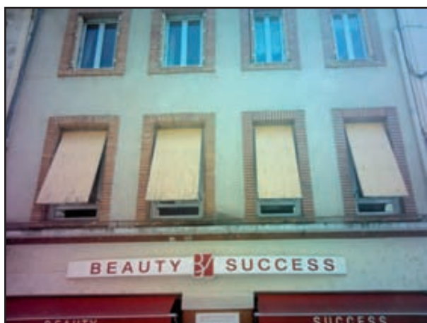
Figure 40 : a/ détail de la façade occidentale
