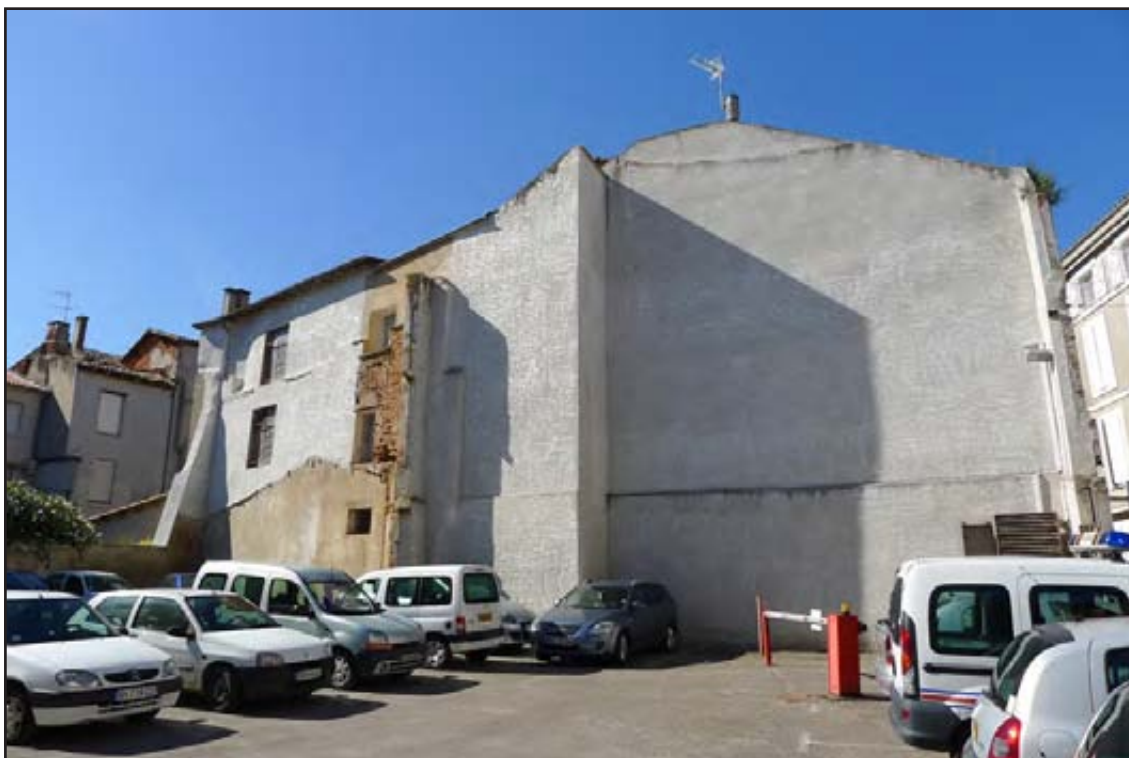
Figure 159 : vue générale de l'élévation septentrionale
