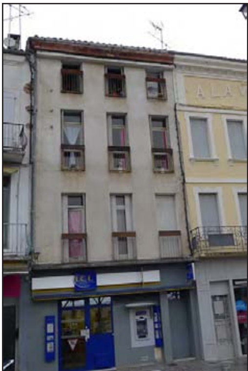
Figure 103 : vue générale de la façade méridionale, donnant sur la rue Malaveille
