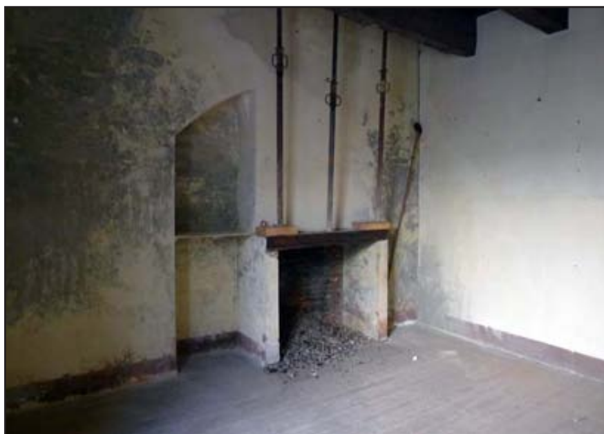
Figure 59 : bâtiment B, la cheminée du premier niveau
