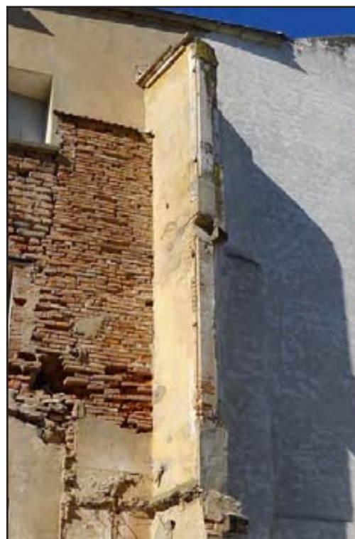
Figure 161 : détail de l'arrachement du MUR02
