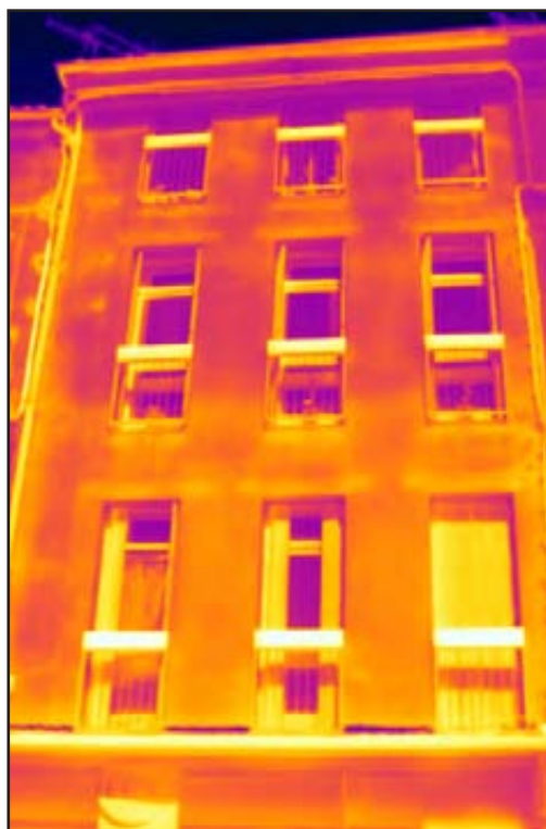
Figure 104b: cliché thermique de la façade méridionale (détail)
