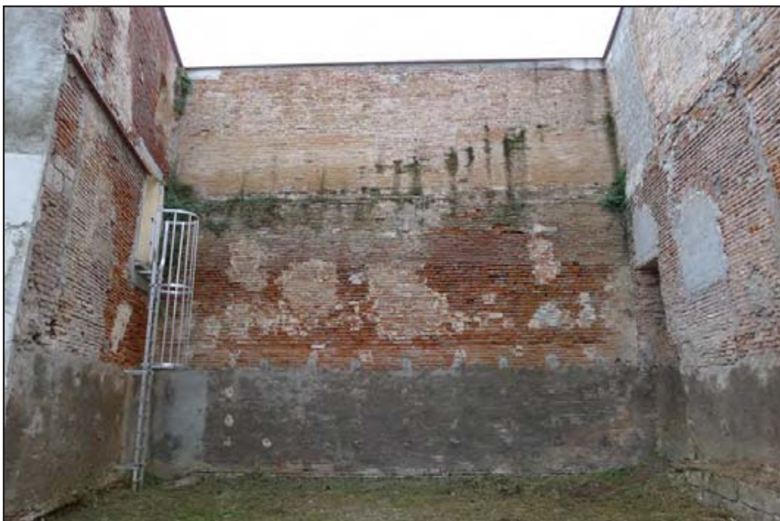
Figure 126 : vue générale du MUR03
