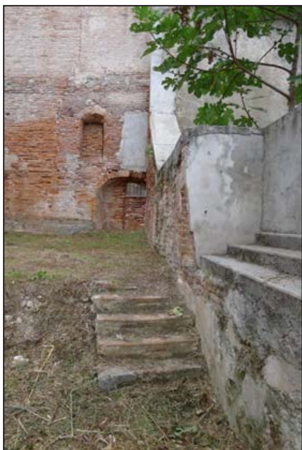
Figure 127 : l'escalier du MUR05 et, à droite, celui du MUR06
