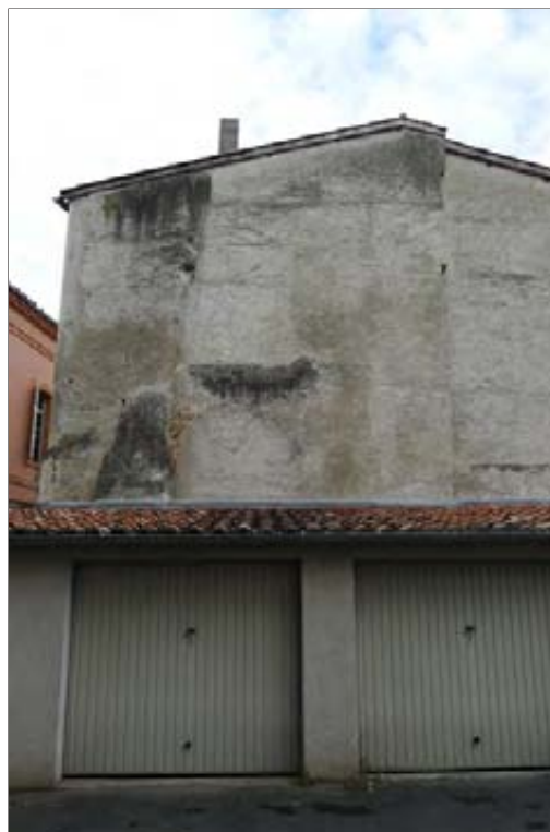
Figure 171 : vue générale de l'élévation occidentale, depuis la parcelle DK0705
