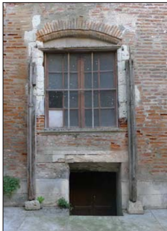
Figure 58 : bâtiment B, façade donnant sur la cour, fenêtre du premier niveau. On note les deux pièces de bois dont les extrémités sont sculptées de pinacles
