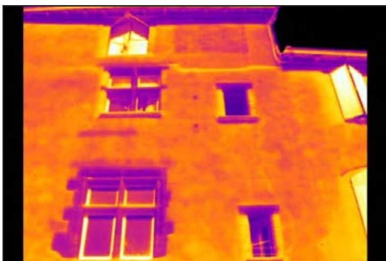
Figure 96 : clichés thermiques de la façade méridionale
