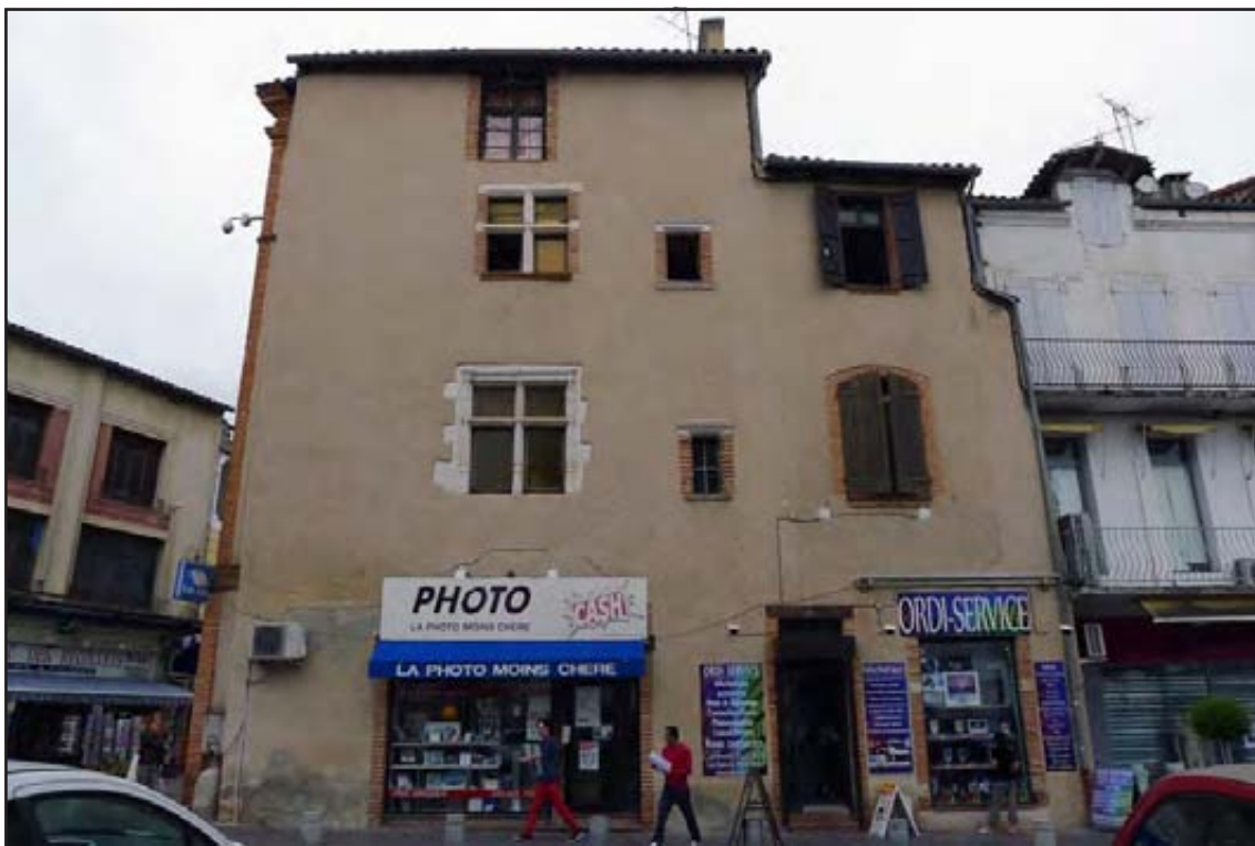
Figure 95 : vue générale de la façade méridionale, donnant sur la rue Malaveille
