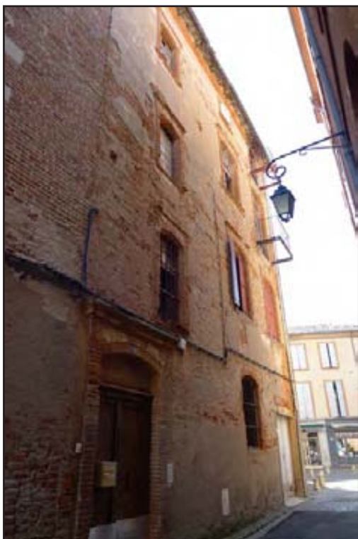
Figure 24 : bâtiment B, façade donnant sur la rue Caillavet vue depuis l'est
