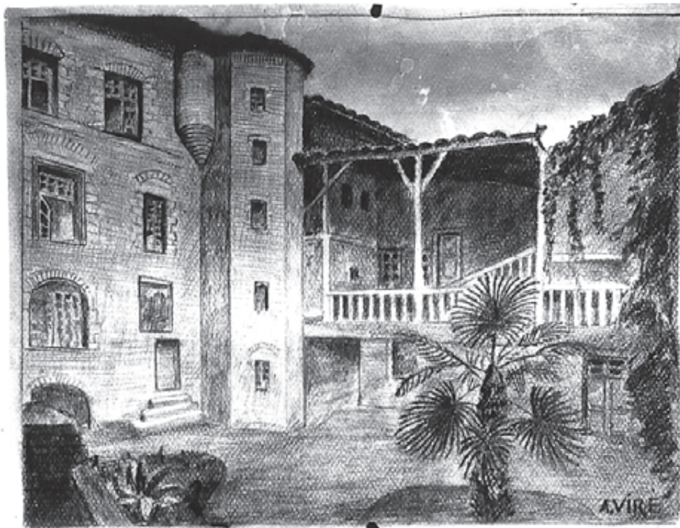
Maison Salers à droite partie démolie en 1935
