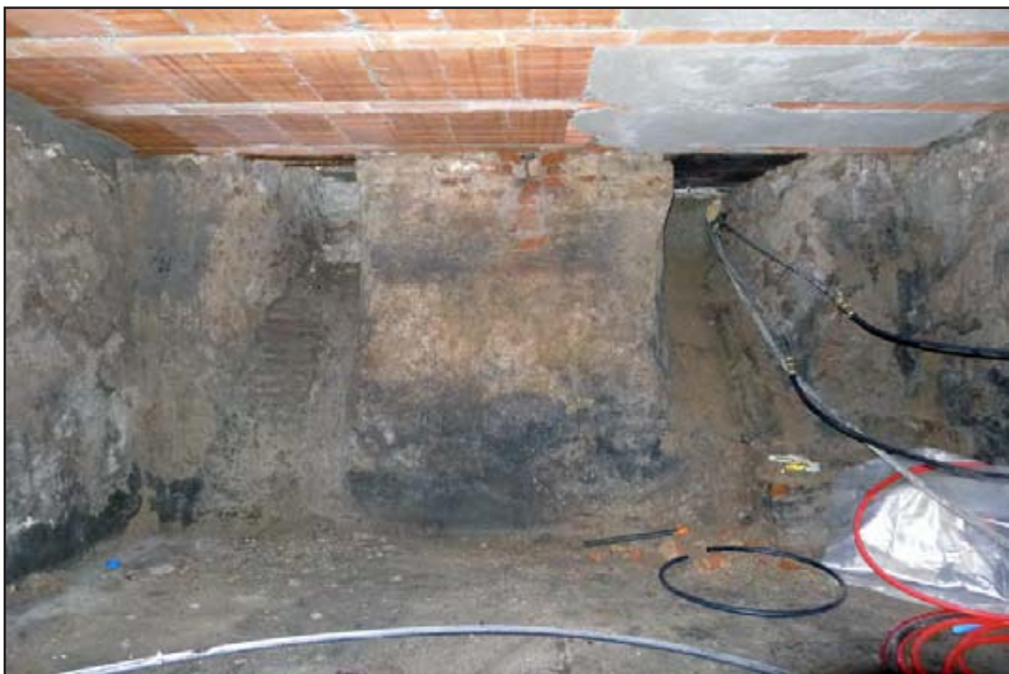
Figure 83 : cliché du niveau de sous-sol, vue vers l'ouest
