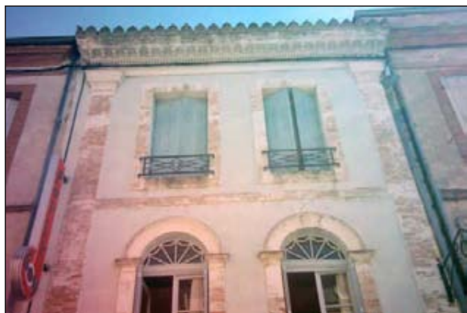
Figure 74a : cliché de la façade occidentale (détail)
