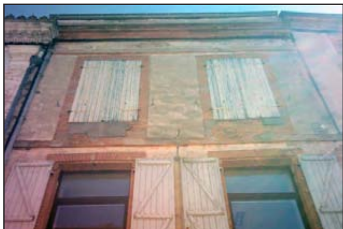
Figure 77a : cliché de la façade occidentale (détail)
