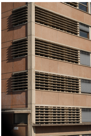
Brise soleil à l'angle d'un bâtiment de laboratoires et travaux pratiques de chimie. Phot. Michel Dubau. © Service régional du patrimoine et de l'inventaire d'Aquitaine, 2008.
