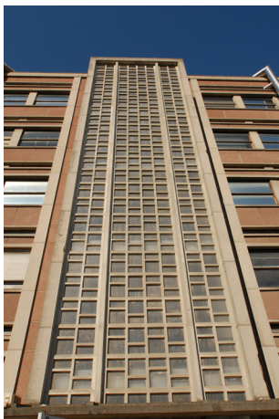
Clastra sur la façade d'un bâtiment de laboratoires et travaux pratiques de chimie. Phot. Michel Dubau © Région Aquitaine, Inventaire général, 2008.
