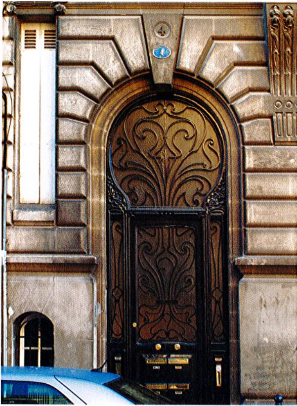
Fig. 11. - Porte d'entrée de l'immeuble construit pour Monsieur Jacmart, rue Le Chapelier à Bordeaux. Cl. Franck Delorme.
