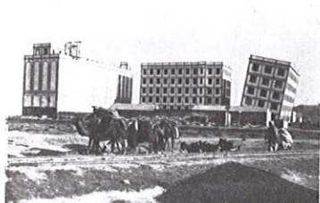
Vue d'ensemble prise de côté de la photo 1. Le bâtiment n. 1, à gauche, est celui qui a été édifié par Hennebique. Sur la terrasse on voit les constructions qui ont été ébauchées après l'édification de celui-ci. Le bâtiment de droite n. 2, qui a été construit après Hennebique, est construit en béton armé par le fabricant n. 2.
