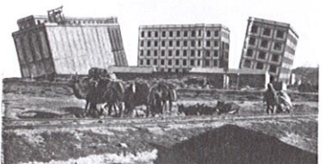
Vue générale des bâtiments n. 1 et 2 ébauchés pendant le même temps, au nord et au sud de la terrasse.
