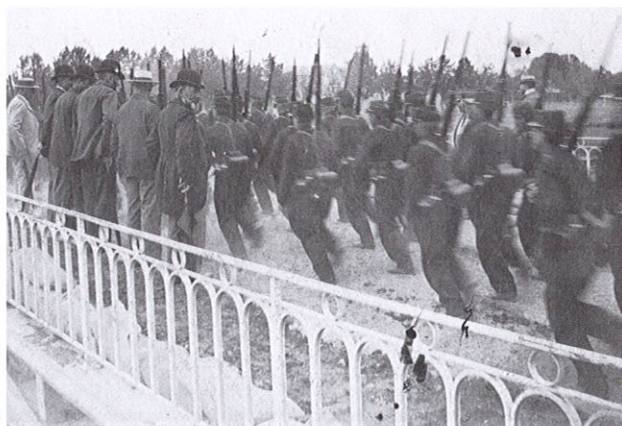
Fig. 11 : Passage de la troupe au pas de charge sur le pont de Châtellerault vers 1900. CAPA/Archives de France/fonds Bétons armés Hennebique, 76 IFA, 35 IFA 37/5. © Cl. anonyme.
