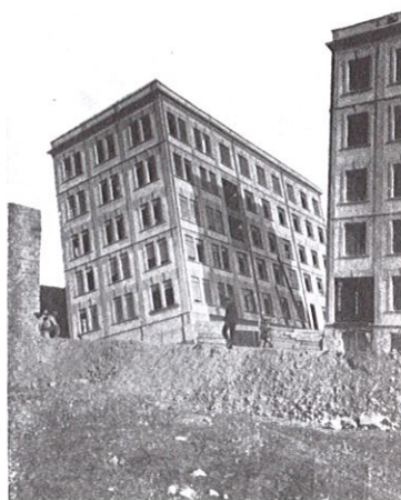
Vue générale de l'édifice n. 2 avec son système d'escaliers (voir photo 5 du plan, fig. 2).
