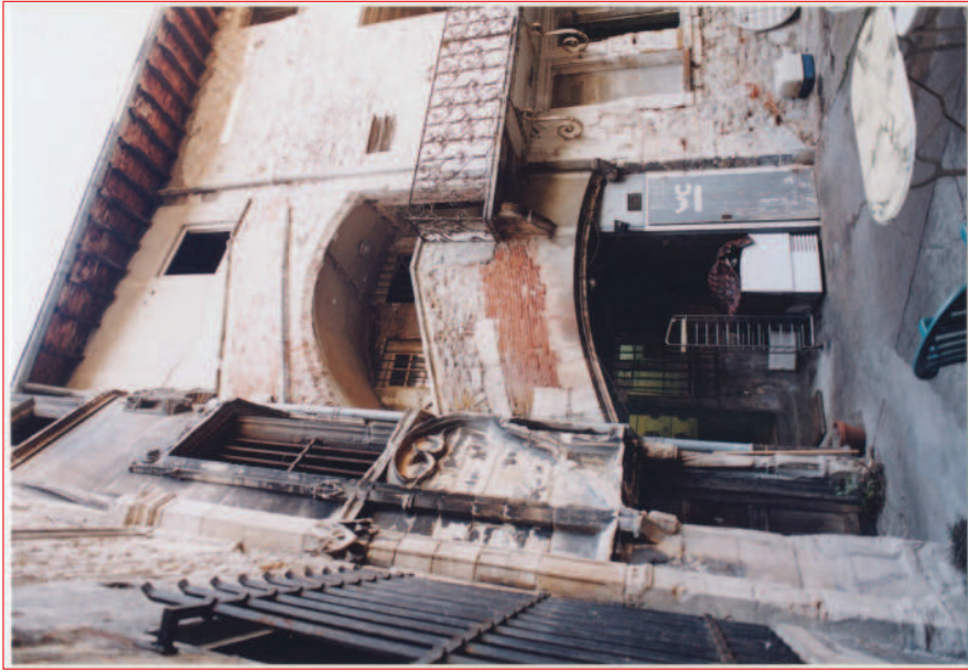
Bâtiments 2 et 4 : vue générale (AML, 1946 WP 4)
