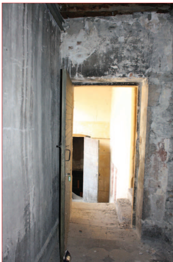
Mur ouest M 12 : porte P 49 (IMG_0876)
