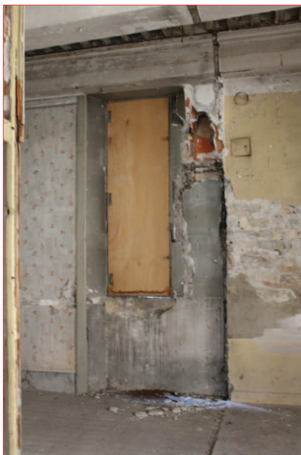
Mur sud M 15 : fenêtre F 13 et cheminée CH 17 (IMG_0692)
