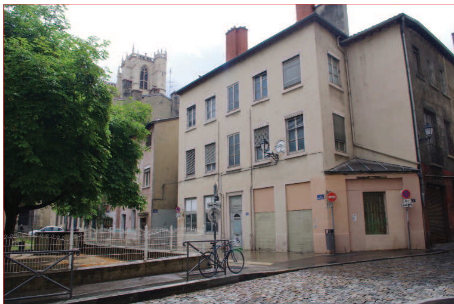
Bâtiment arrière : vue générale (IMGP2627)
