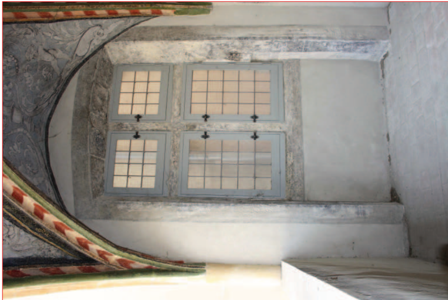
Mur sud M 9 : fenêtre F 35
