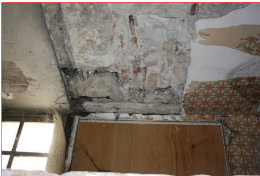
Mur nord M 3 : paroi est du cabinet est (IMG_0788)
