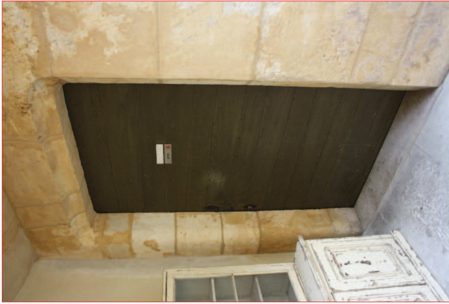
Bâtiment 2, mur M 12 : porte P.15 (IMG_0979)
