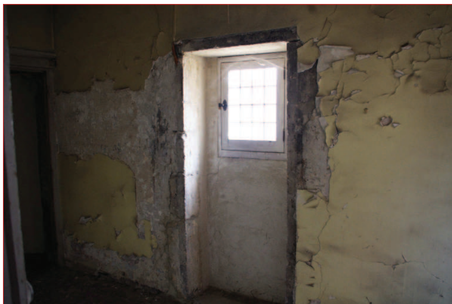
Mur est M 4 : vue générale (IMGP2796)
