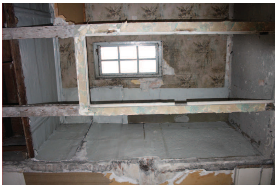
Mur nord M 3 : cabinet est (IMG_0817)
