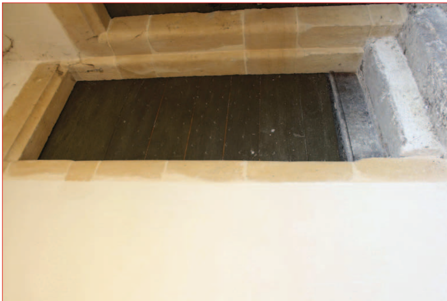
Mur nord M 6 : porte P 48 (IMG_0992)
