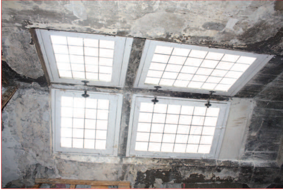
Mur sud-est M 7 : fenêtre F 81 (IMG_0968)
