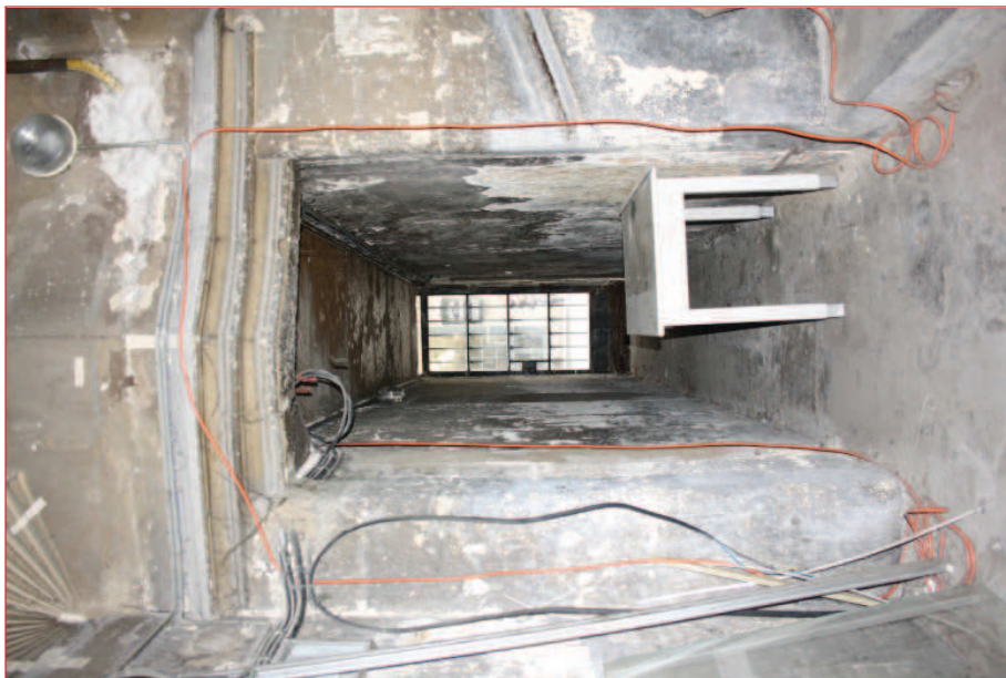
Mur ouest M 23 : porte P 8 et ancien couloir d'accès (IMG_0949)
