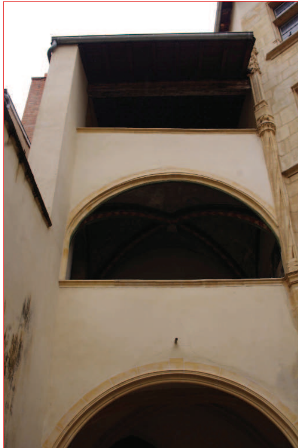
Bâtiment 1 : moitié sud, partie haute (IMGP2617)
