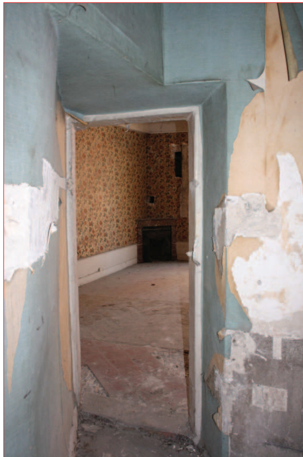
Mur ouest M 5 : porte P 42 (IMG_0894)
