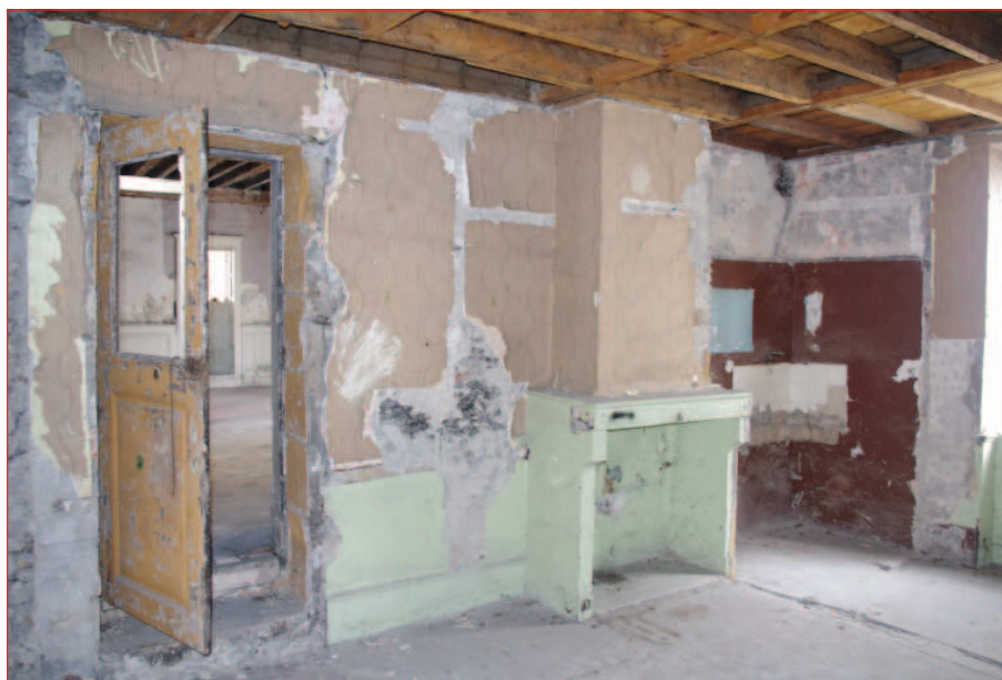
Mur ouest M 12 : vue générale (IMG_2754)
