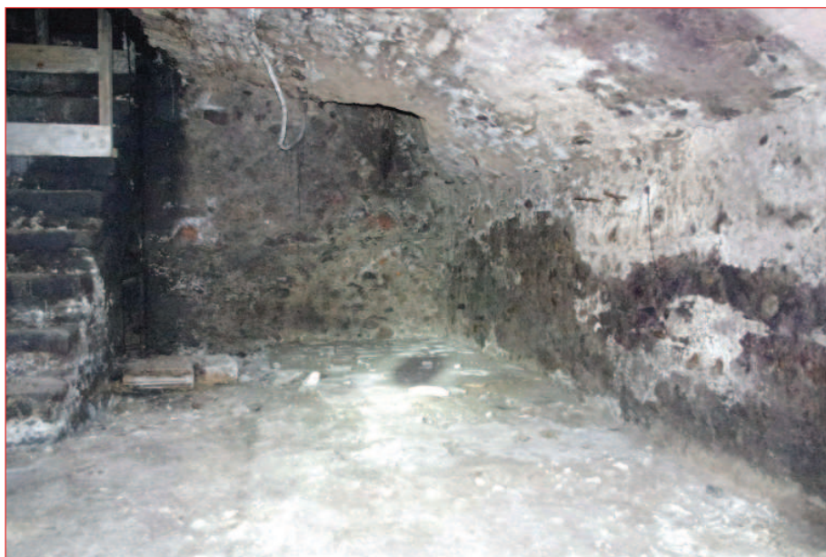
Angle du mur ouest M 13 et du mur sud M 15 (IMGP2804)
