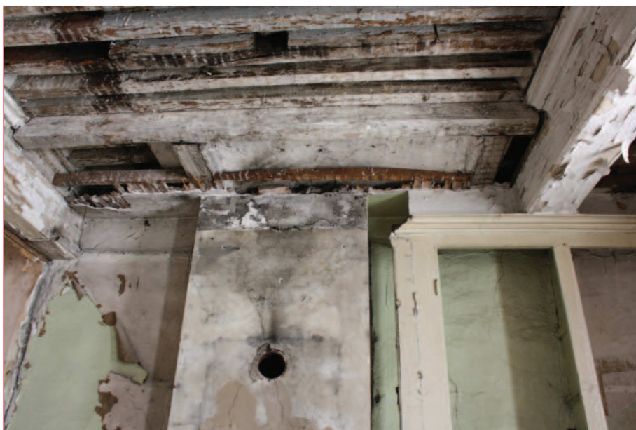
Mur ouest M 13 : cheminées CH 3 et CH 19 (IMG_0712)
