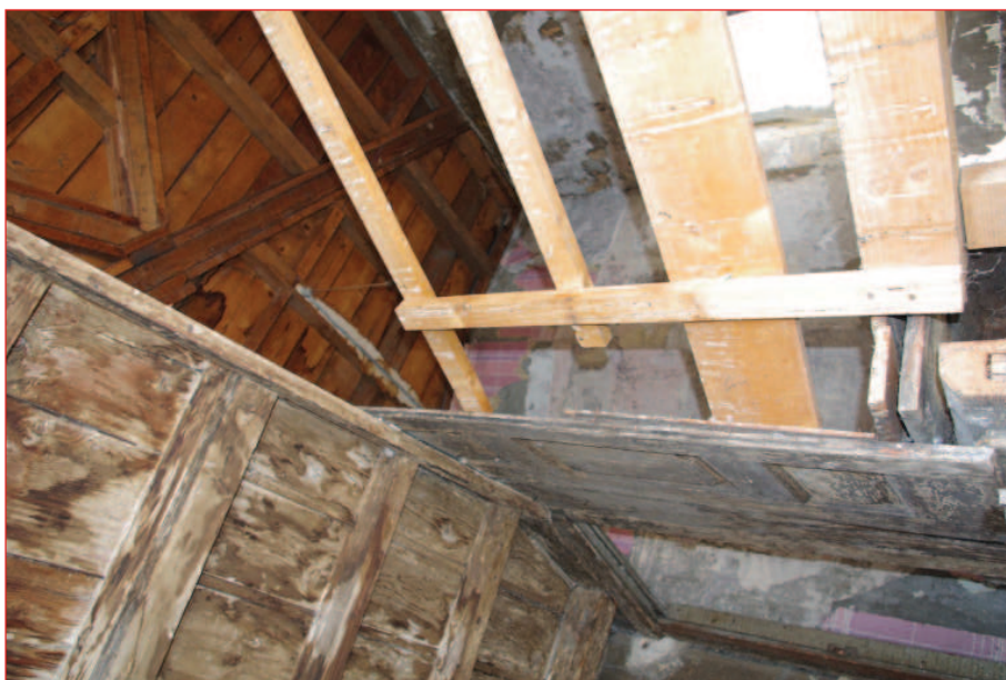
Mur ouest M 23 : local en bois (IMG2793)
