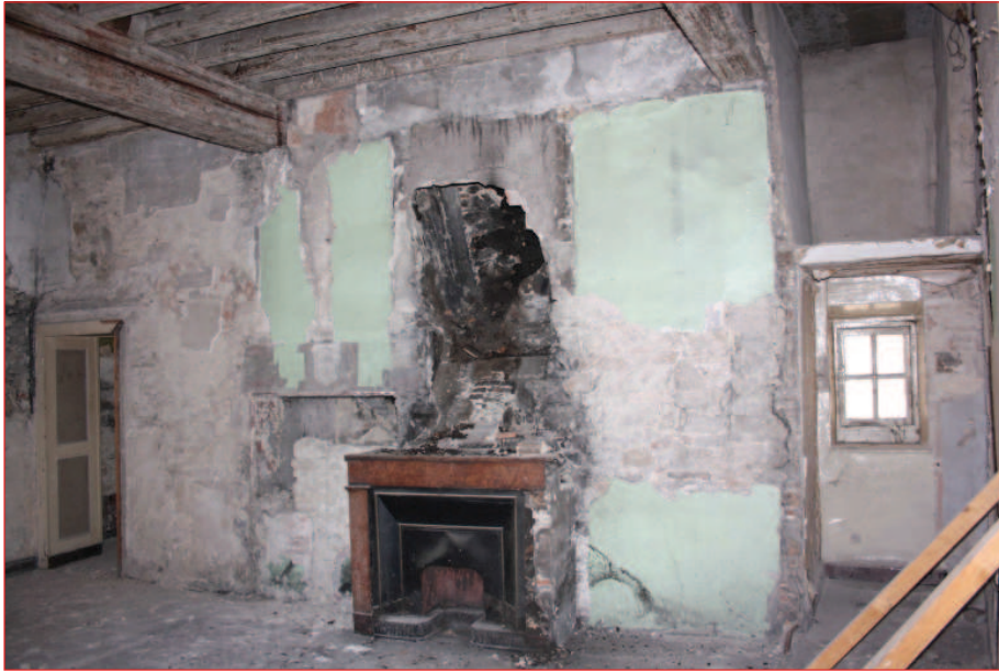
Mur nord M 3 : vue générale (IMG_0733)
