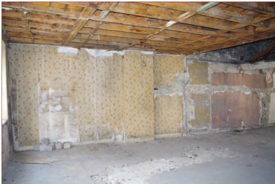
Mur est M 16 : moitié nord (IMGP2768)
