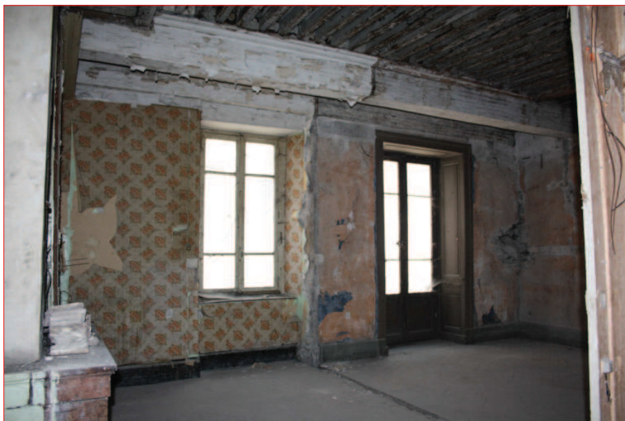
Mur nord M 14 : vue générale (IMG_0677)
