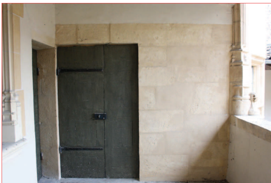
Mur nord M 7 : vue générale (IMG_0809)
