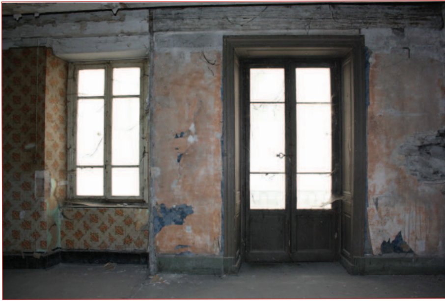
Mur ouest M 13 : moitié sud (IMG_0503)
