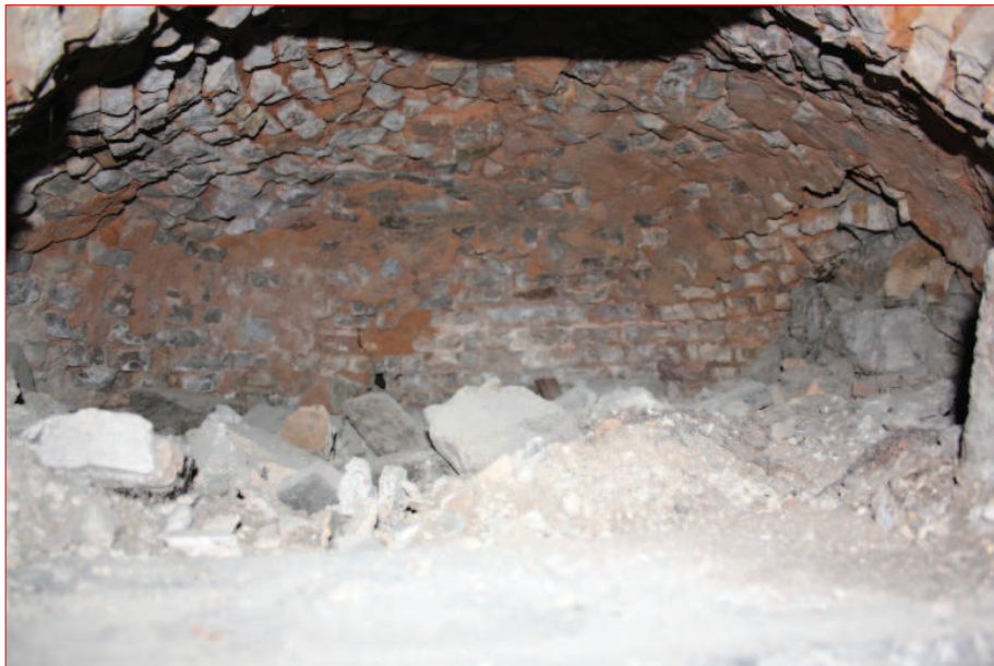
Mur nord M 3 : intérieur du four aménagé dans la cheminée CH 1 (IMG_0467)
