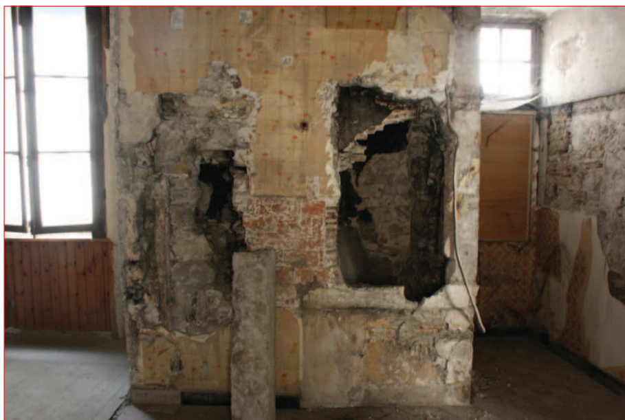
Mur nord M 3 : cheminée CH 5 (IMG_0797)
