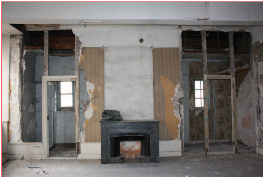
Mur nord M 3 : vue générale (IMG_0814)
