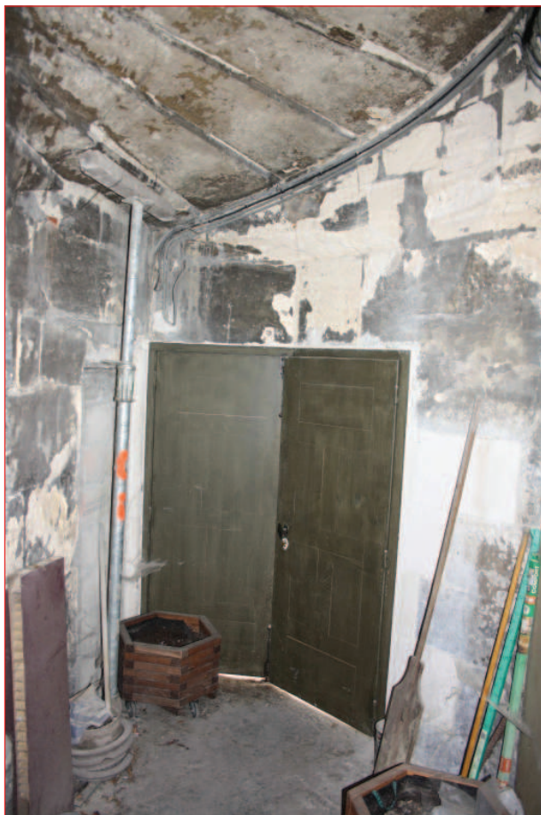
Mur sud-est M 7 : porte P 10 (IMG_0946)
