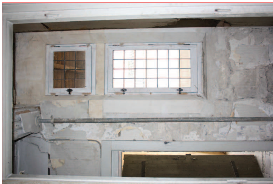
Mur est M 4 : porte P 45 et fenêtre F 50 (IMG_0917)
