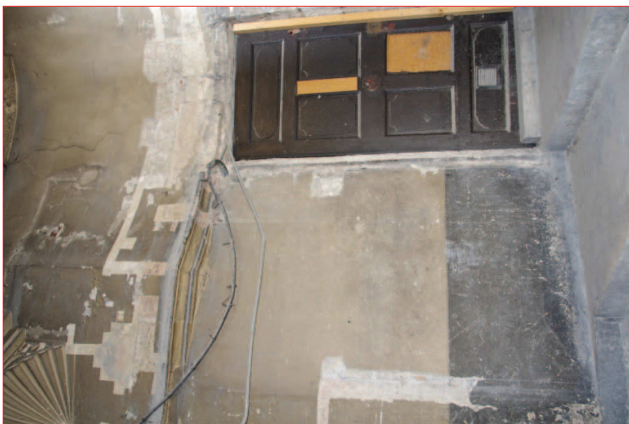
Mur ouest M 23 : vue générale (IMGP2782)
