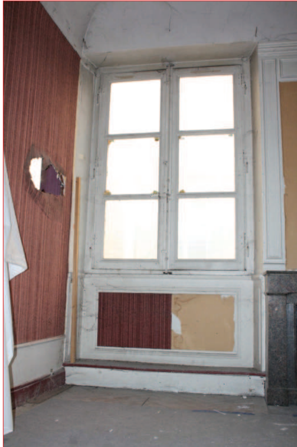
Mur ouest M 1 : fenêtre F 31 (IMG_0842)
