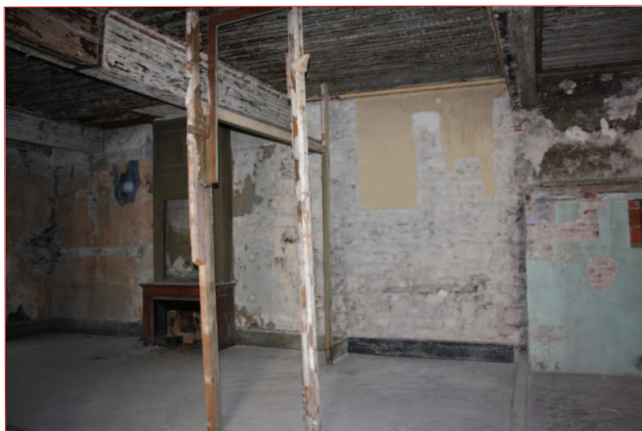
Mur est M 16 : moitié nord (IMG_0659)
