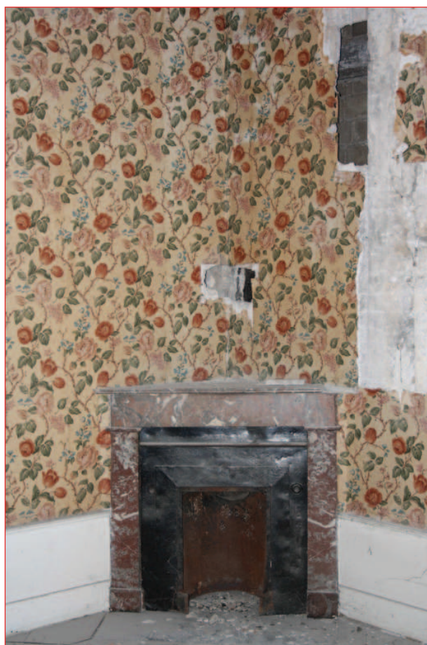
Mur ouest M 1 : cheminée CH 24 et fenêtre F 42 (IMG_2813)
