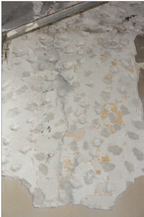
Mur sud M 15 : détail des enduits peints (IMG_0683)
