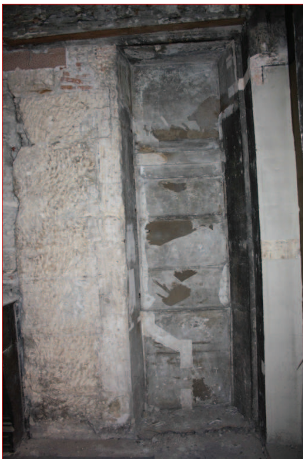
Mur sud M 2 : fenêtre F 34 (IMG_0831)
