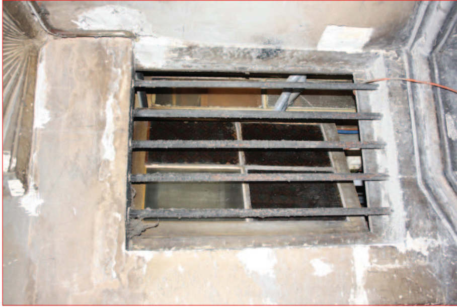
Mur ouest M 23 : fenêtre F 8 (IMG_0950)
