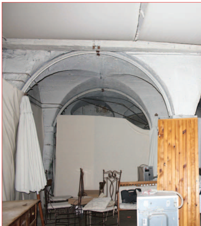
Angle sud-est (IMG_0468)
