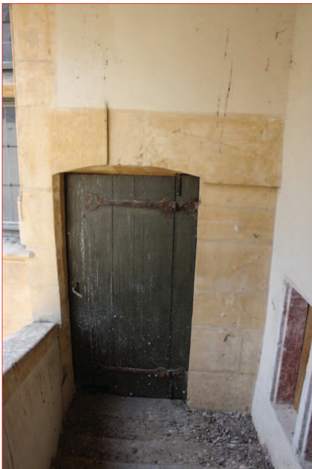
Mur ouest M 7 : porte P 41 (IMG_0990)
