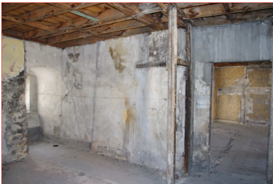
Mur est M 13 : vue générale (IMG_2758)
