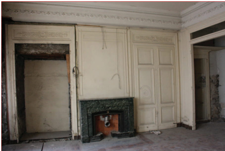
Mur nord M 3 : vue générale (IMG_0768)
