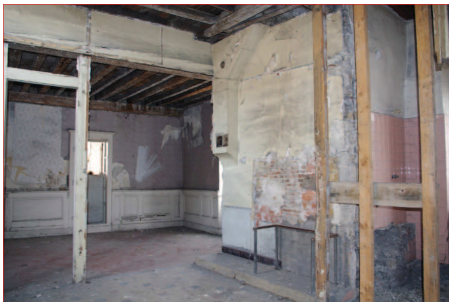
Mur nord M 3 : vue générale (IMG_2749)
