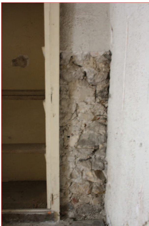
Mur nord M 3 : détail du sondage est (IMG_0769)
