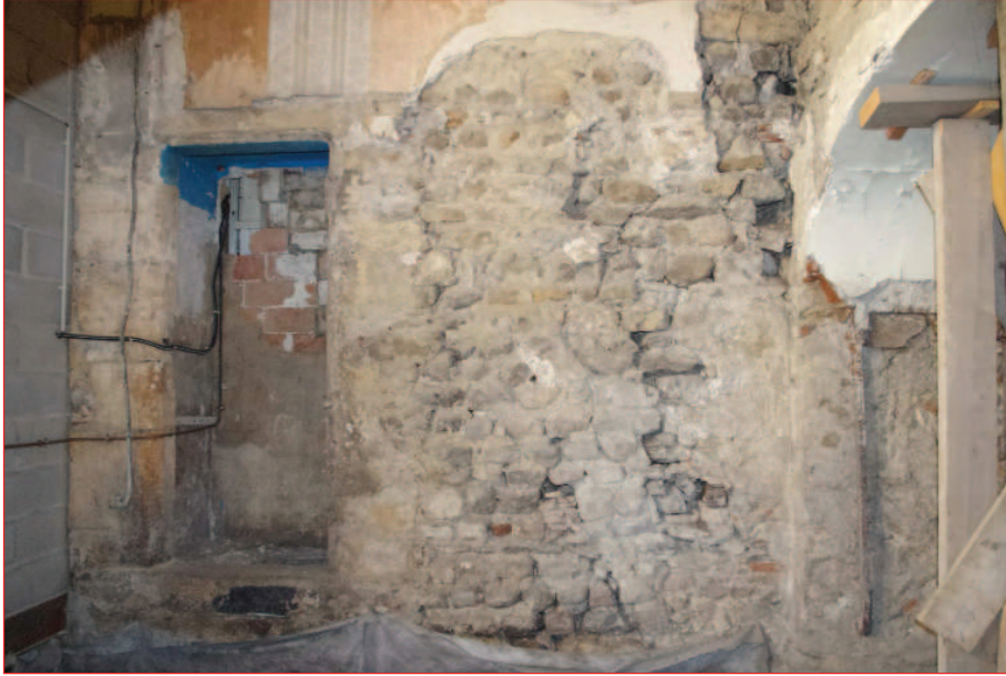
Mur ouest M 12 : vue générale (IMGP2810)
