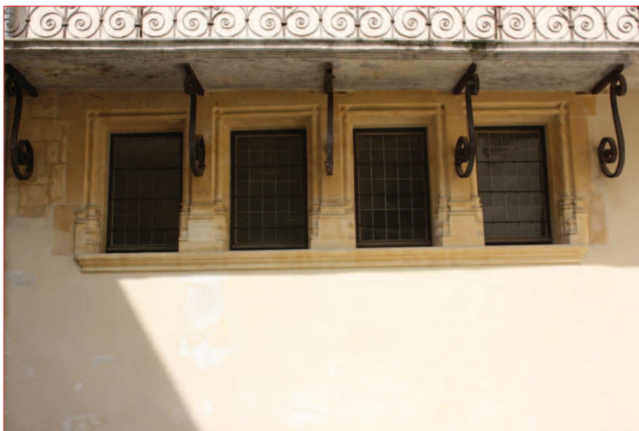
Bâtiment 2, mur 20 : fenêtres F 4, F 5, F 82 et F 83 (IMG_0981)
