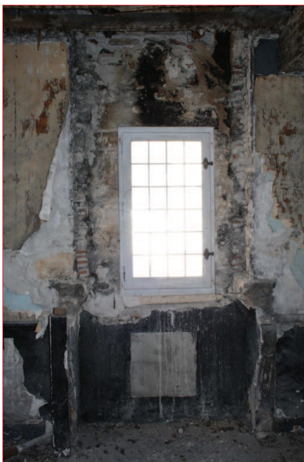
Mur ouest M 13 : cheminée CH 26 et fenêtre F 62 (IMG_0869)
