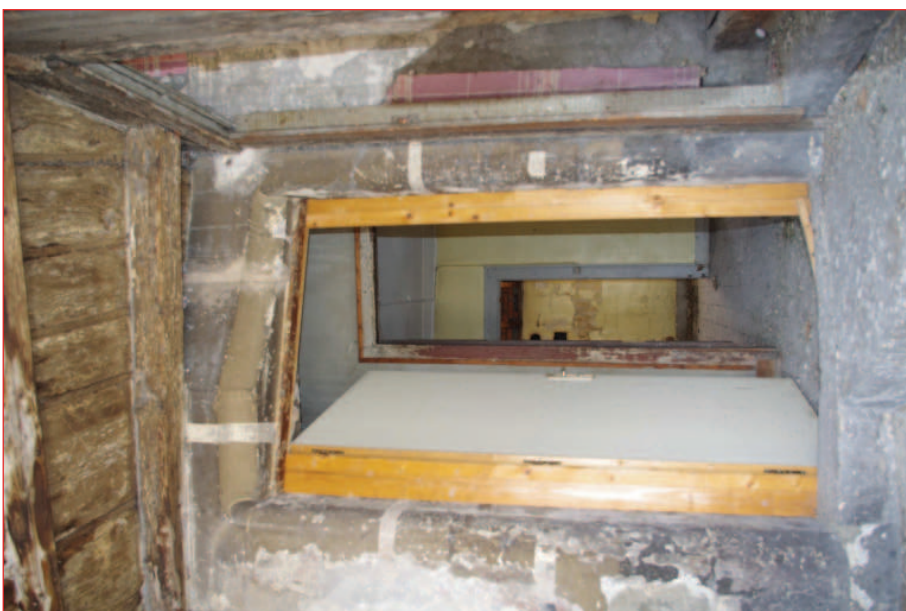
Mur ouest M 23 : porte P 53 (IMG2791)
