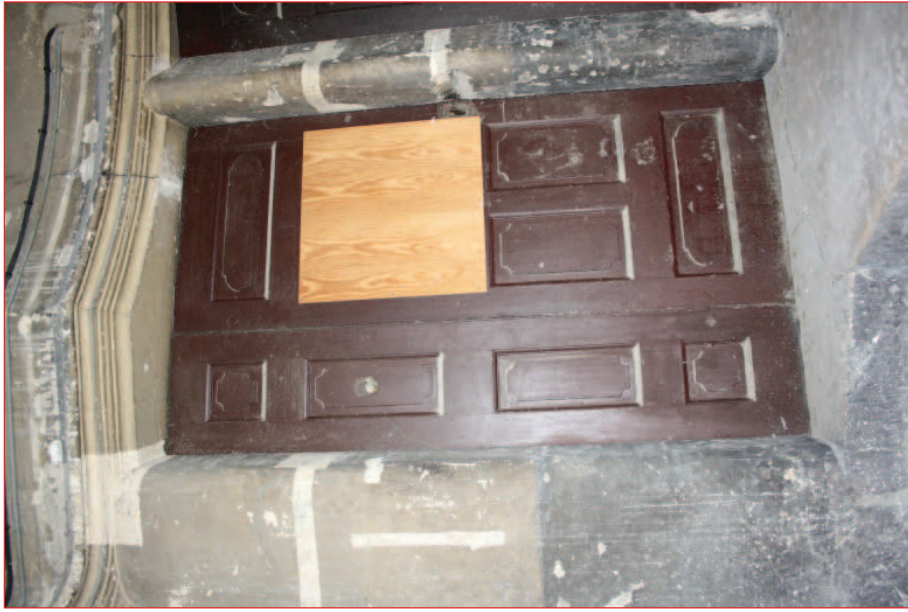
Mur ouest M 23 : porte P 44 (IMG_0964)
