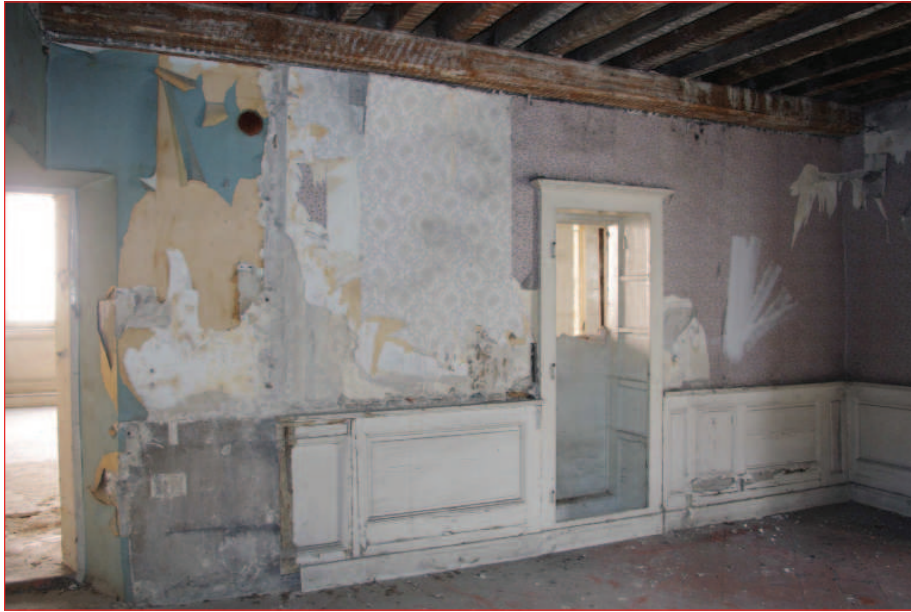
Mur ouest M 5 : vue générale (IMG_2741)
