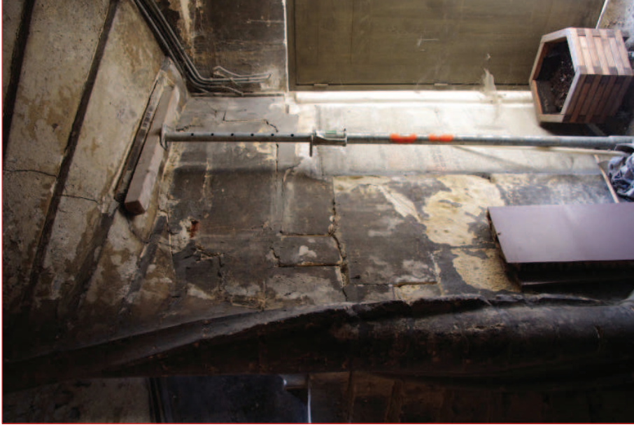
Mur intermédiaire M 10 : vue générale (IMG2775)
