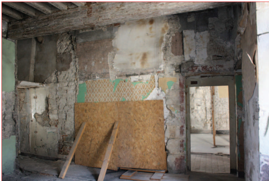
Mur est M 13 : vue générale (IMG_0728)
