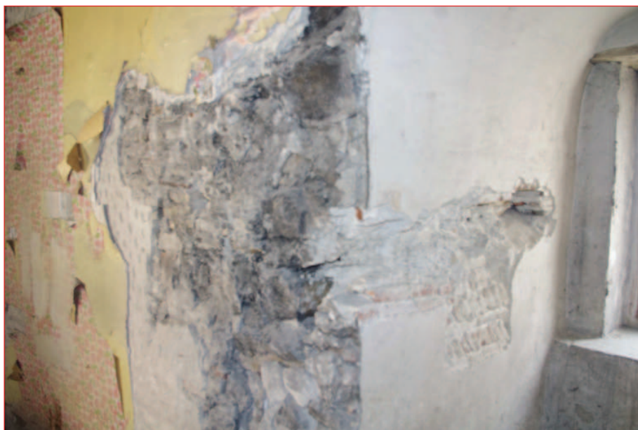
Mur nord M 3 : piédroit de la cheminée CH 11 (IMG_2757)
