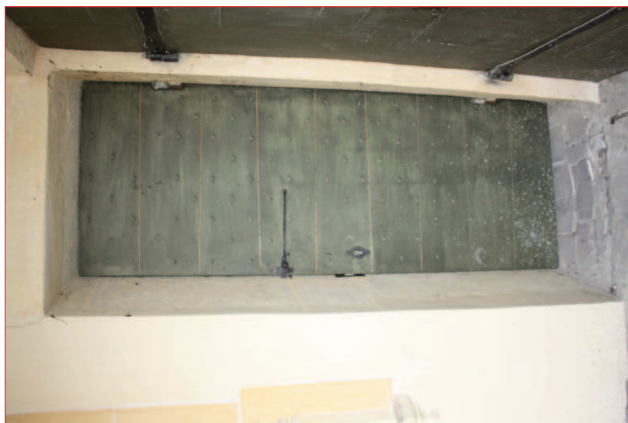
Mur ouest M 4 : porte P 45 (IMG_0925)
