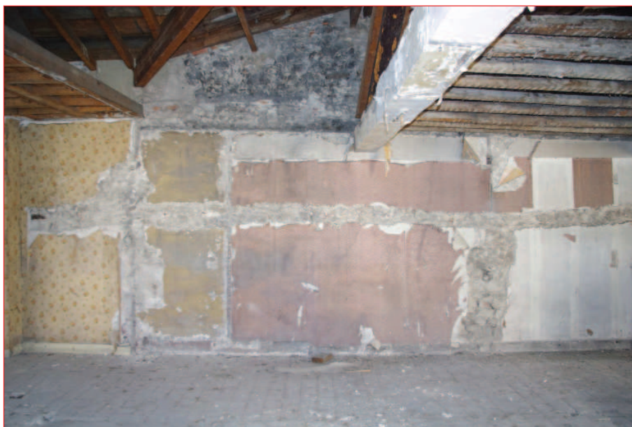
Mur est M 16 : partie centrale (IMGP2770)
