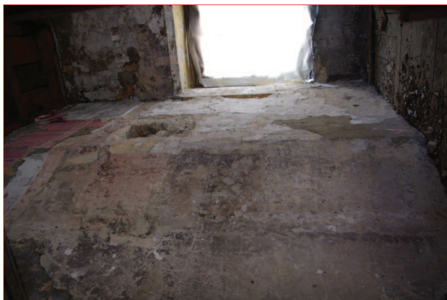
Mur ouest M 23 : moitié nord (IMGP2792)
