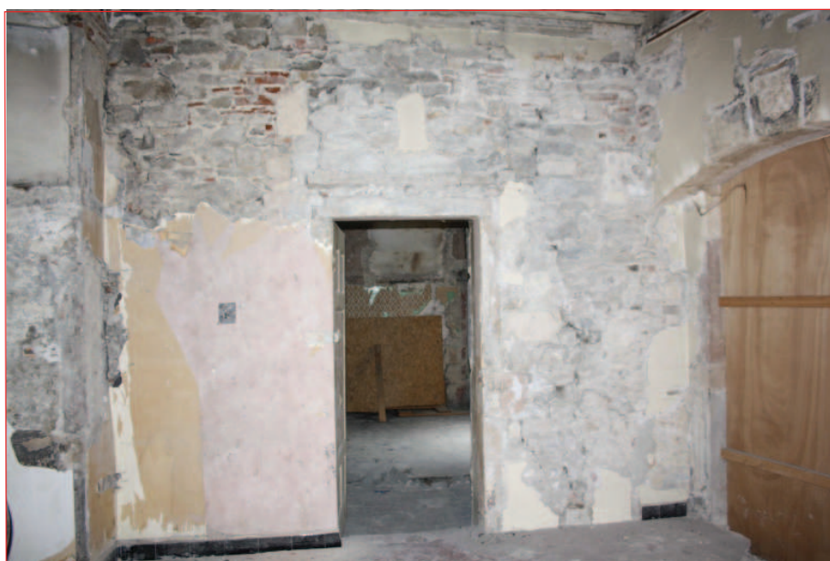
Mur est M 12 : vue générale (IMG_0748)
