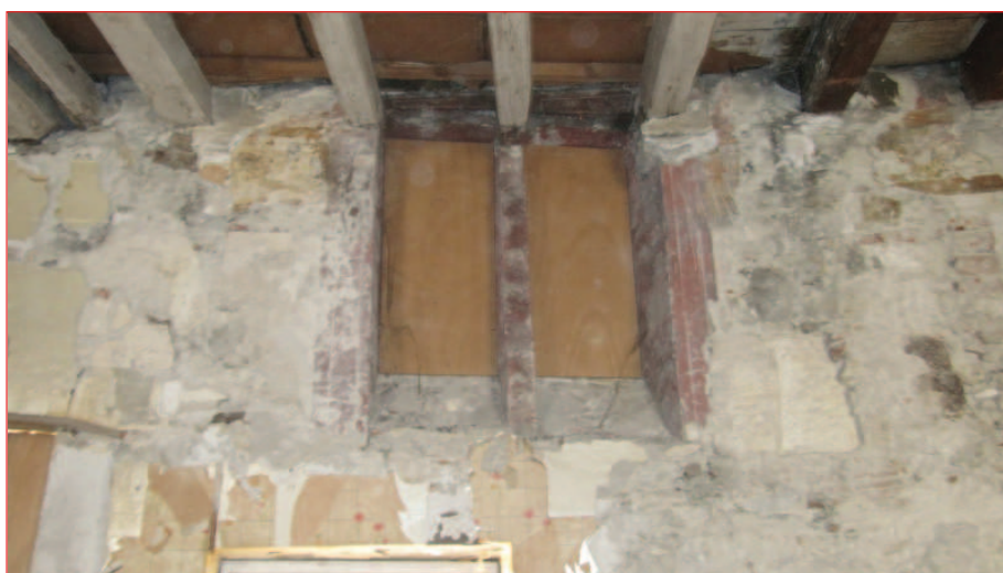
Mur sud M 6 : fenêtre F 25 (XVII)
