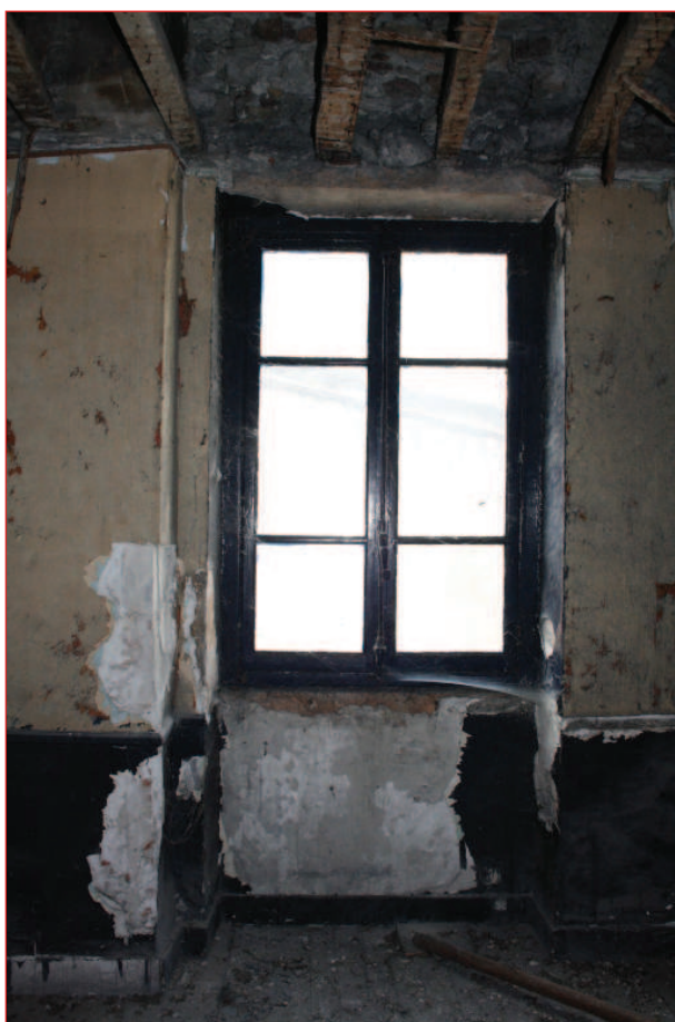
Mur sud M 15 : fenêtre F 61 (IMG_0869)
