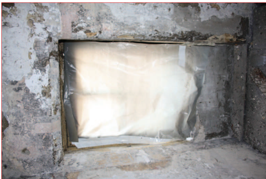
Mur nord M 21 : porte P 54 (IMGP2793)
