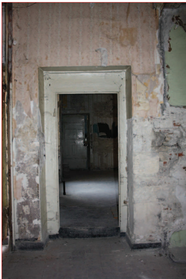
Mur ouest M 13 : porte P 30 (IMG_0674)
