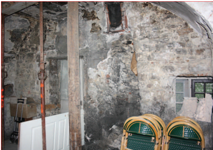
Mur est M 13 : vue générale de la cheminée CH 1 (IMG_0463)
