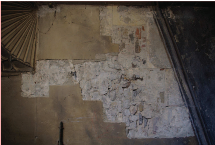
Mur nord M 21 : détail de la maçonnerie (IMG2778)
