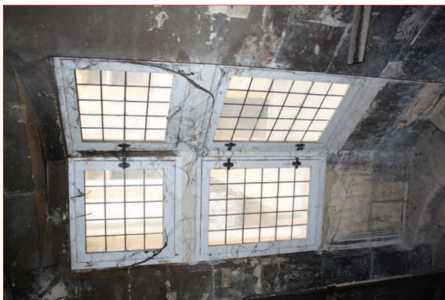
Mur sud-est M 7 : fenêtre F 9 (IMG_0952)
