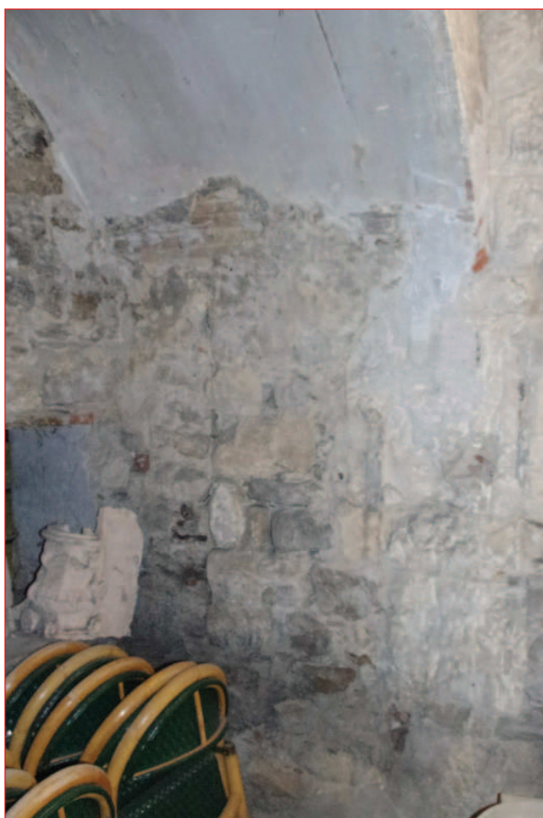
Mur sud M 20 : paroi sud de la cheminée CH 1 (IMGP2809)
