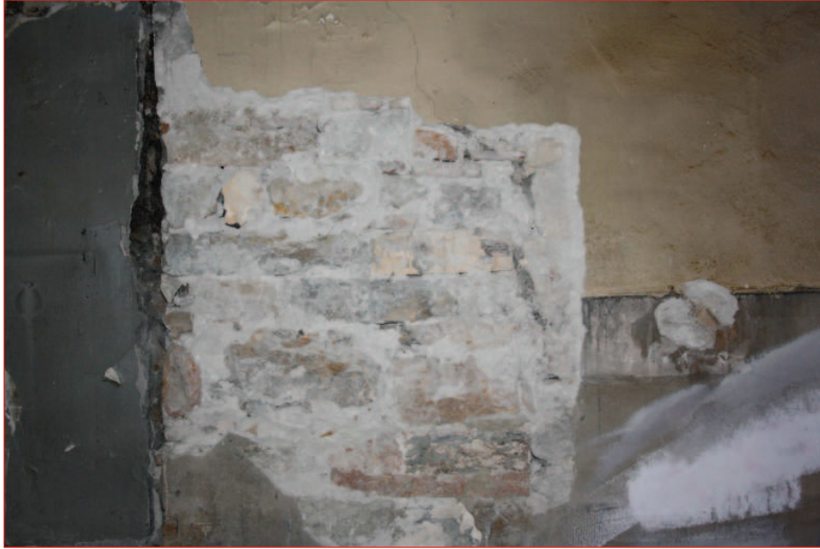
Mur sud M 15 : sondage central (IMG_0666)
