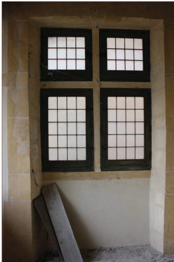
Mur sud M 9 : fenêtre F 48 (IMG_0927)
