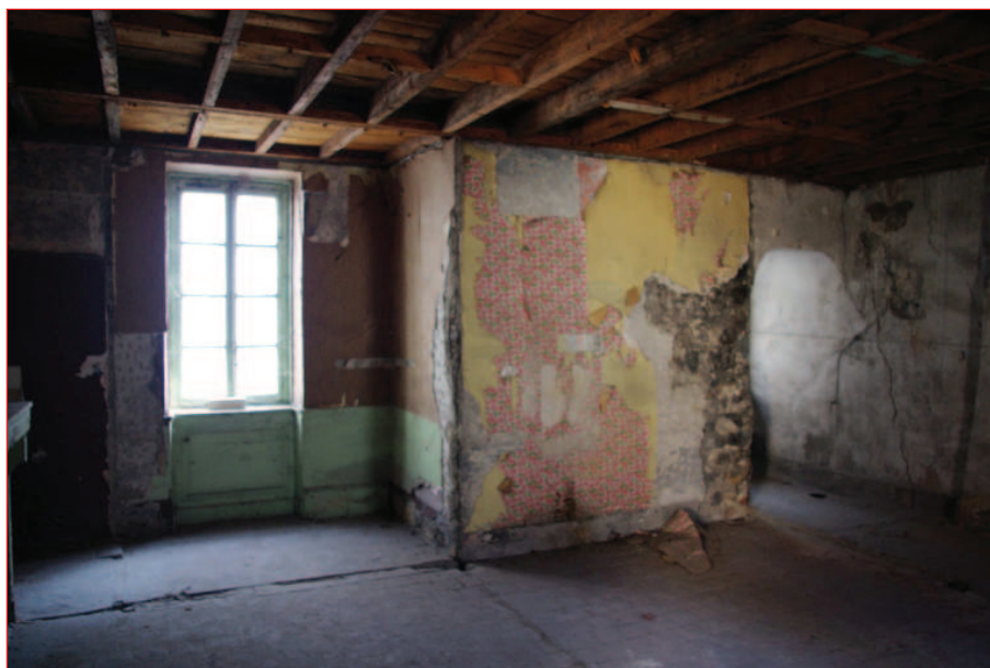
Mur nord M 3 : vue générale (IMG_2756)
