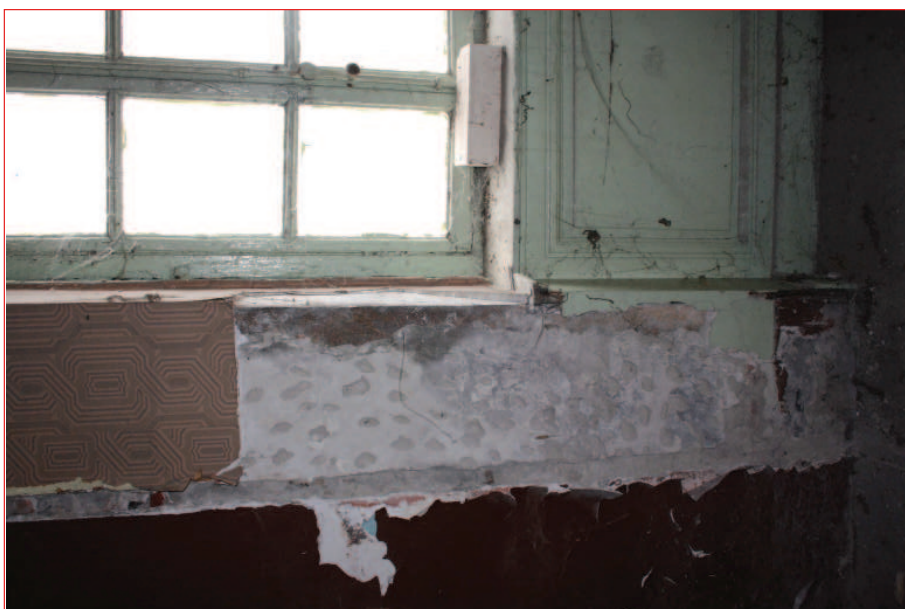
Mur nord M 3 : piédroit de la fenêtre F 54 (IMG_0884)
