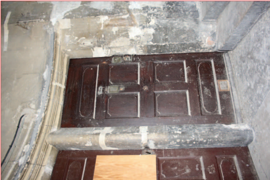
Mur ouest M 23 : porte P 43 (IMG_0965)
