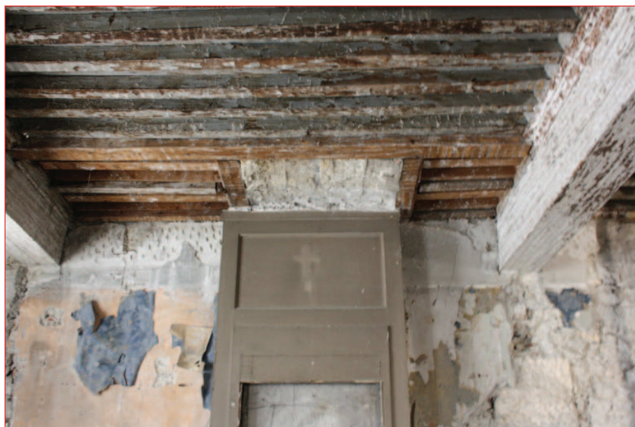
Mur est M 16 : cheminées CH 2 et CH 20 (IMG_0713)
