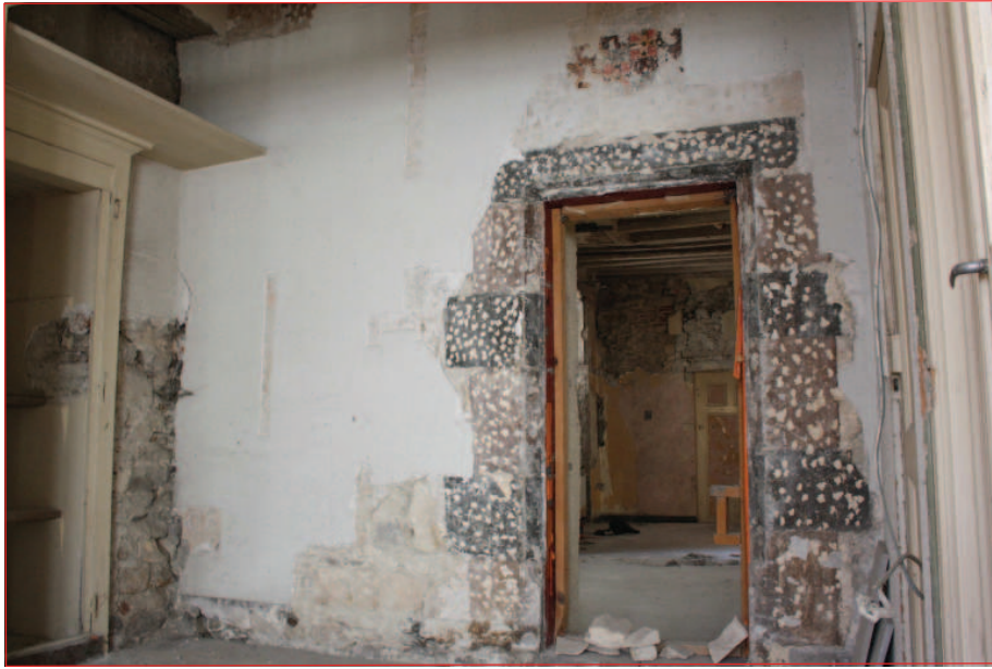
Mur est M 5 : vue générale (IMG_0770)
