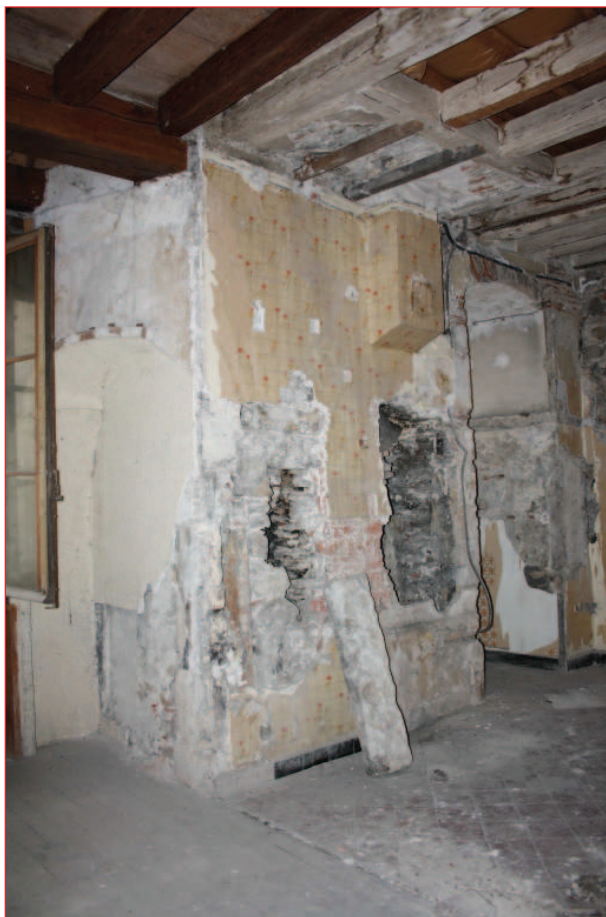
Mur nord M 3 : vue générale (IMG_0517)
