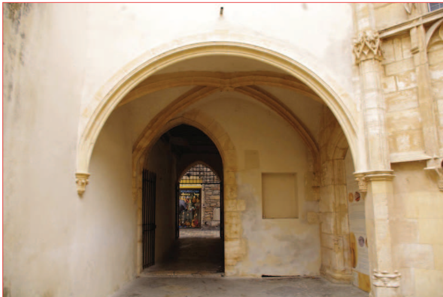
Bâtiment 1 : moitié sud, partie basse (IMGP2593)
