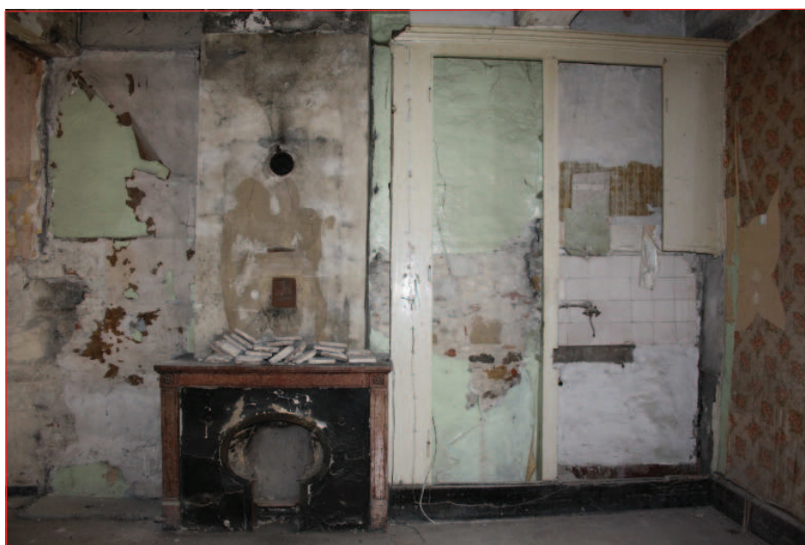
Mur ouest M 13 : moitié nord et cheminée CH 3 (IMG_0504)
