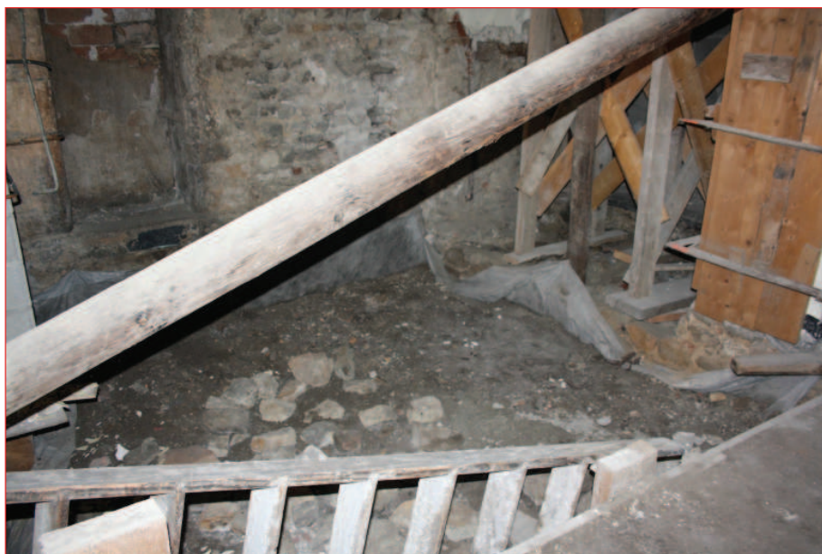
Sondage archéologique réalisé en 2004 : état actuel (IMG_0459)
