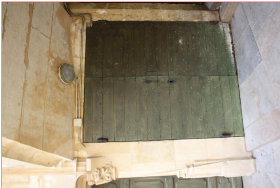
Bâtiment 4, mur M 7 : porte P.12 (IMG_0974)
