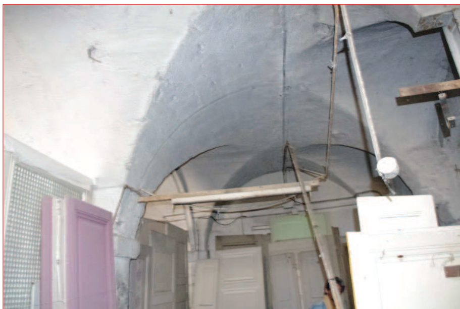
Angle sud-est : système de voûtement (IMG_2802)
