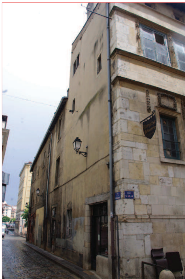
Bâtiments 1, 2 et 3 : murs M 3 et M 14 (IMGP2627)
