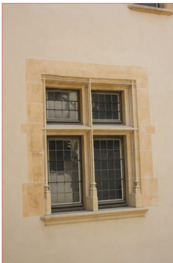
Bâtiment 3, mur M 13 : fenêtre F 14 (IMG_0685)
