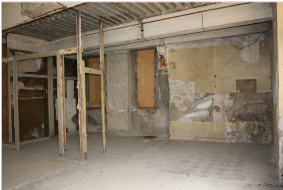
Mur sud M 15 : vue générale (IMG_0499)
