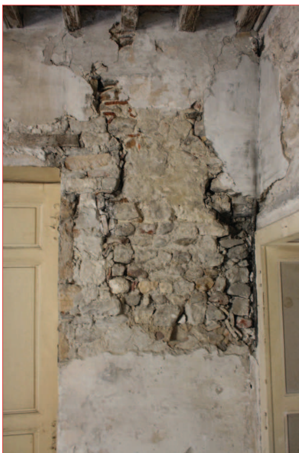
Mur ouest M 12 : sondage nord (IMG_0719)
