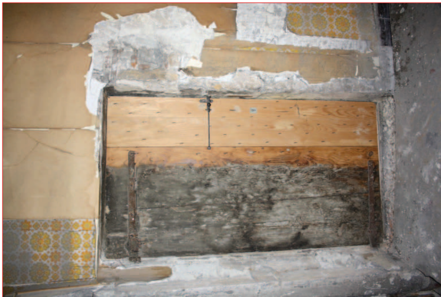
Mur sud M 6 : porte P 48 (IMG_0890)
