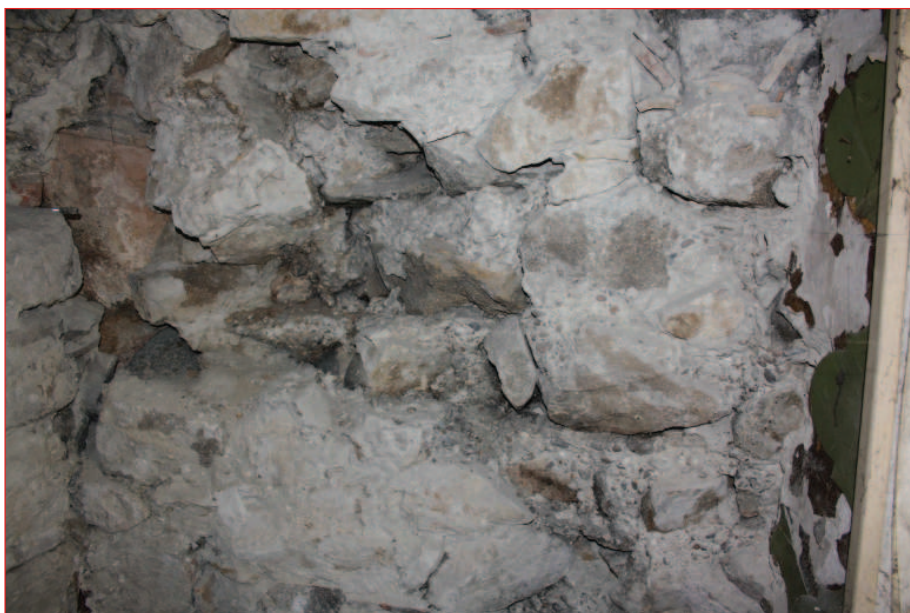
Mur nord M 3 : détail de la fourrure du mur primitif (IMG_0741)
