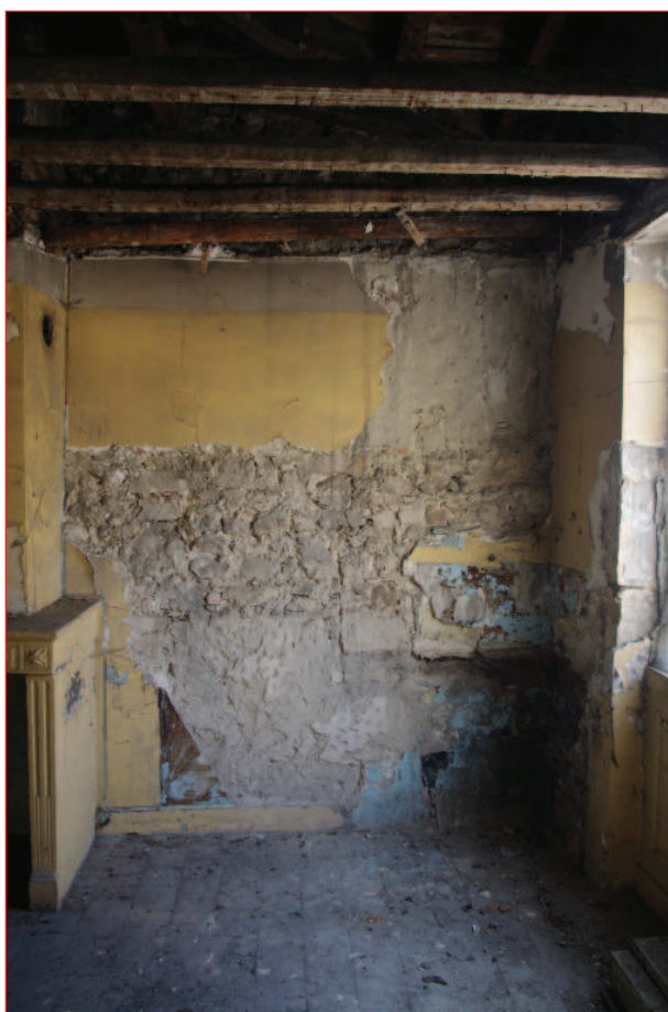
Mur est M 16 : sondage sud (IMGP2772)
