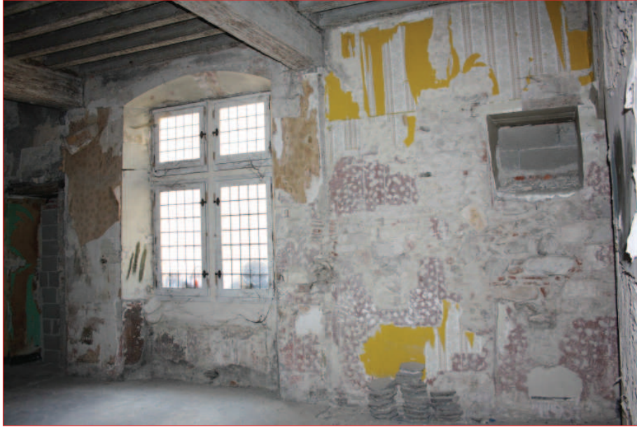
Mur sud M 20 : vue générale (IMG_0721)
