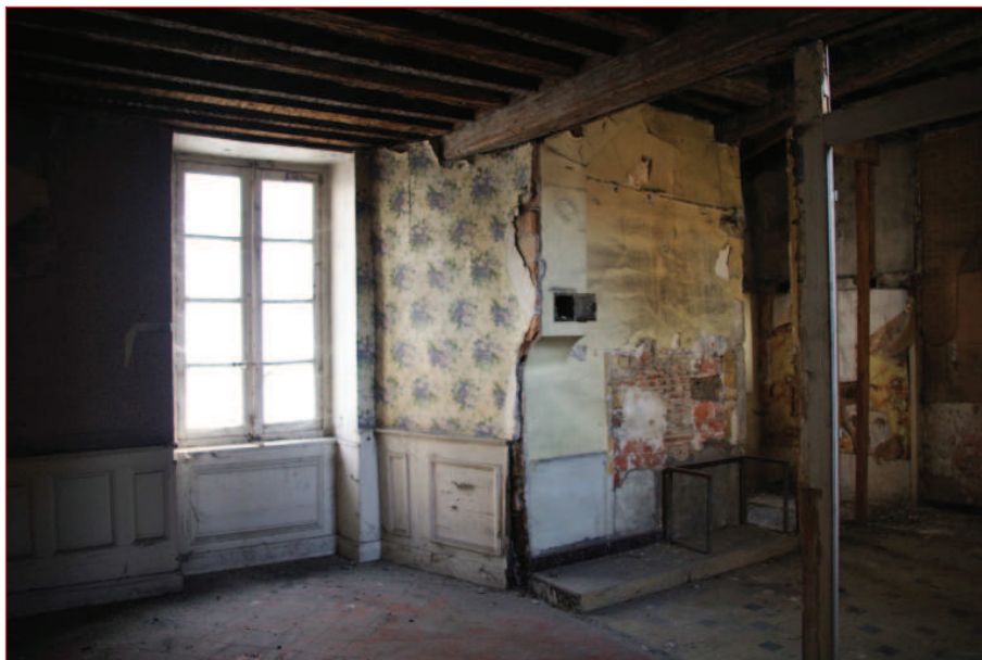
Mur nord M 3 : vue générale (IMG_2748)
