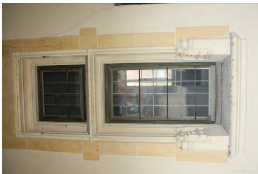
Mur ouest M 4 : fenêtre F 50 (IMG_0926)
