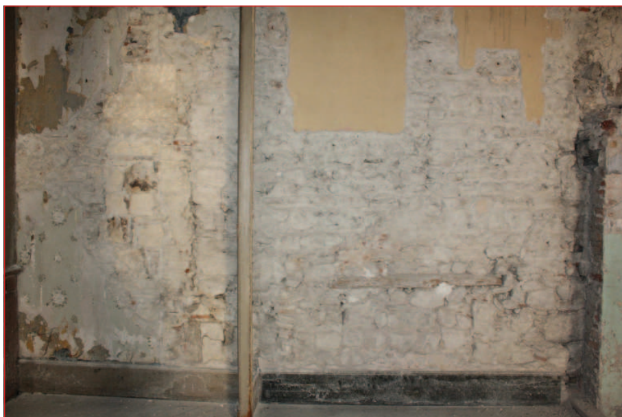
Mur est M 16 : sondage nord (IMG_0661)
