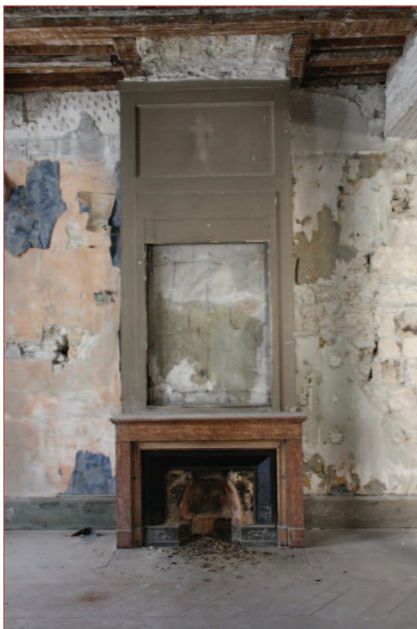
Mur est M 16 : cheminée CH 2 (IMG_0690)
