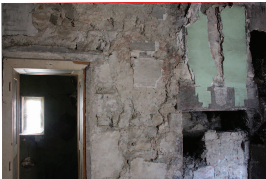
Mur nord M 3 : sondage ouest (IMG_0737)
