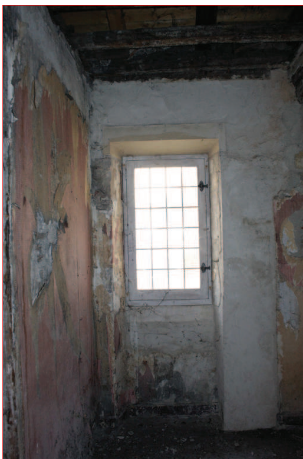
Mur ouest M 13 : fenêtre F 63 (IMG_0871)
