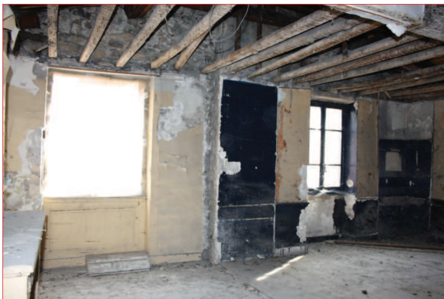
Mur sud M 15 : vue générale (IMG_0564)
