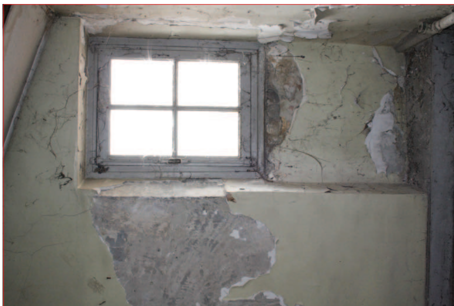
Mur sud M 2 : fenêtre F 70 (IMG_0941)
