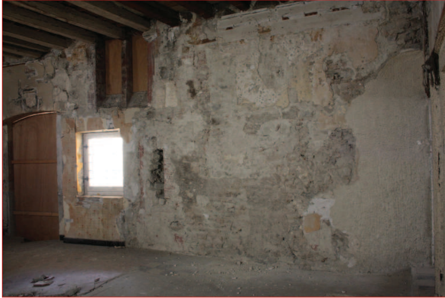
Murs sud M 6 et M 21 : vue générale (IMG_0778)
