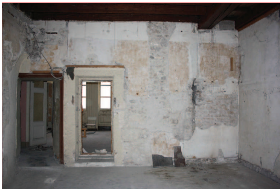
Mur ouest M 5 : vue générale (IMG_0764)
