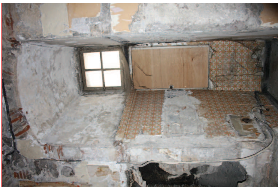
Mur nord M 3 : cabinet est (IMG_0518)
