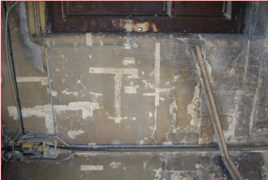
Mur nord M 9 : sondages ponctuels (IMG2781)
