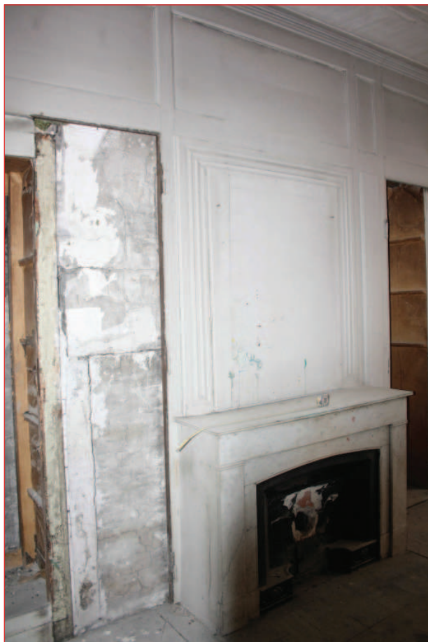
Mur sud M 2 : cheminée CH 8 (IMG_0804)
