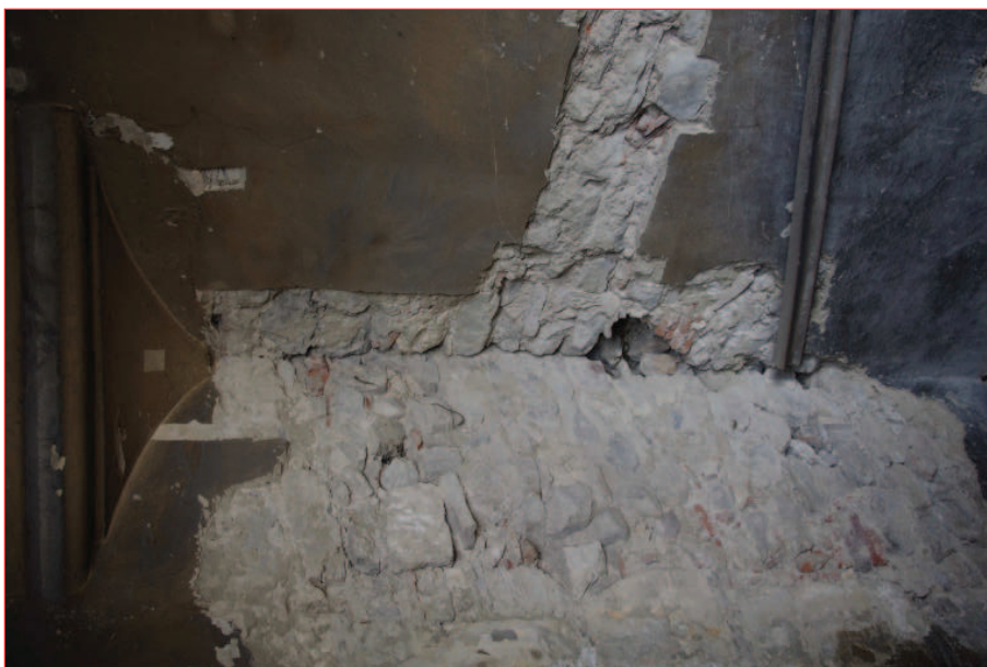
Angle du mur ouest M 23 et du mur nord M 21 : sondage (IMGP2784)
