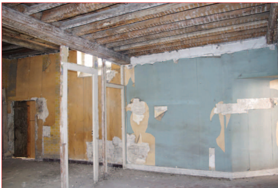
Murs sud M 6 et M 21 : vue générale (IMG_2742)
