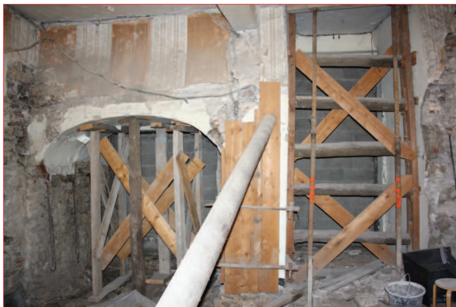
Mur nord M 3 : portes P 17 et P 18 (IMG_0460)
