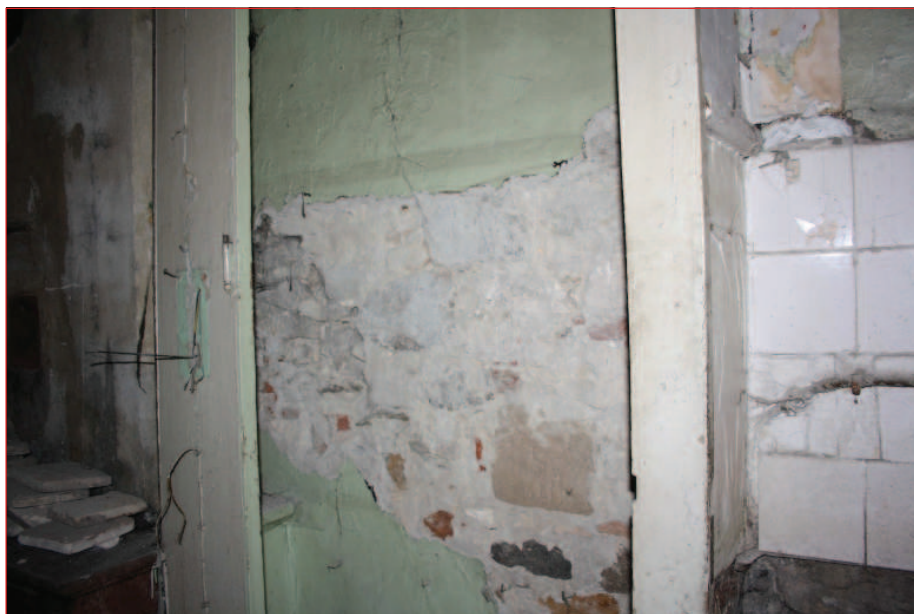
Mur ouest M 13 : détail de la maçonnerie dans le sondage nord (IMG_0706)
