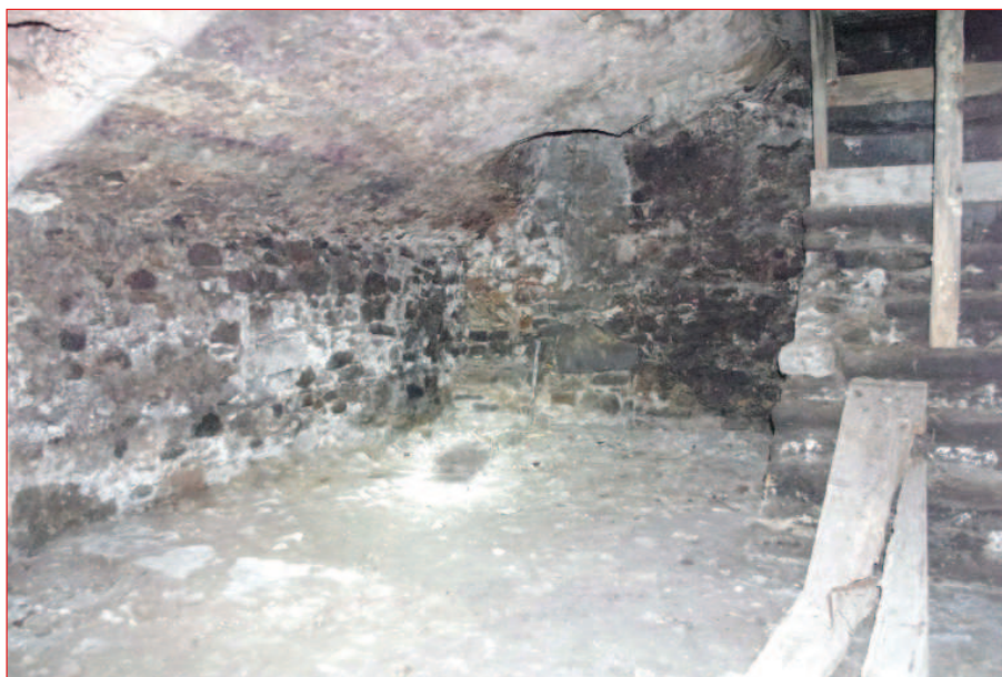
Angle du mur sud M 15 et du mur est M 16 (IMGP2803)
