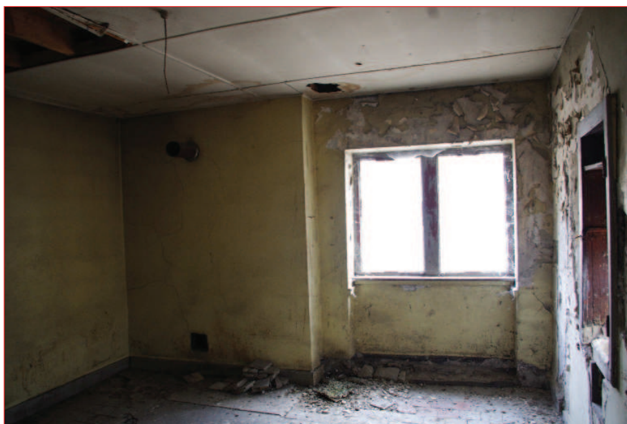
Mur nord M 3 : vue générale (IMGP2795)
