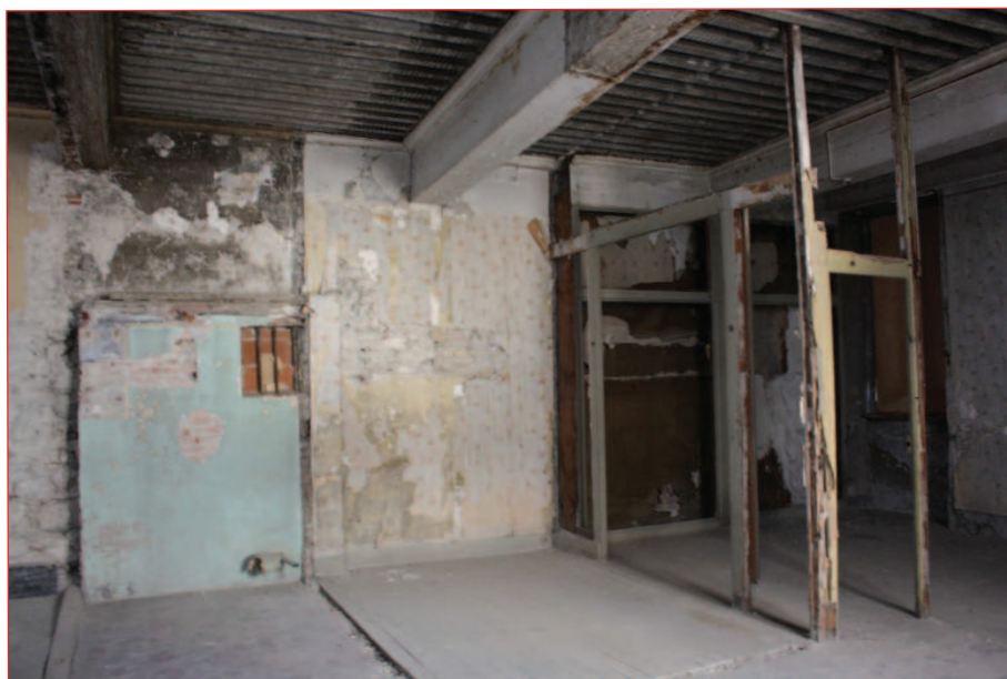
Mur est M 16 : moitié sud (IMG_0658)
