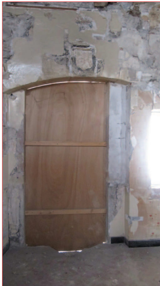
Mur sud M 6 : porte 11 (XXII)
