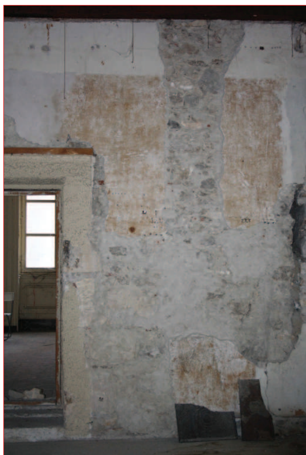
Mur ouest M 5 : sondage central (IMG_0765)
