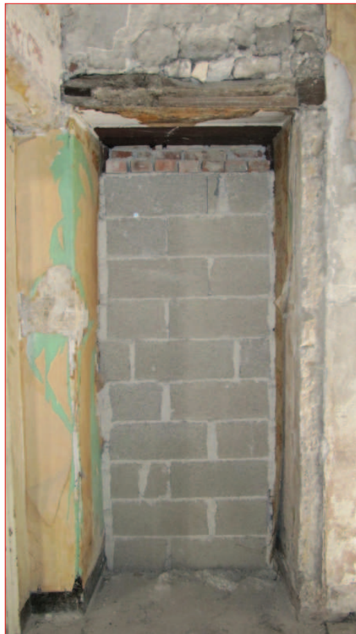
Mur sud M 20 : porte P 31 (X)
