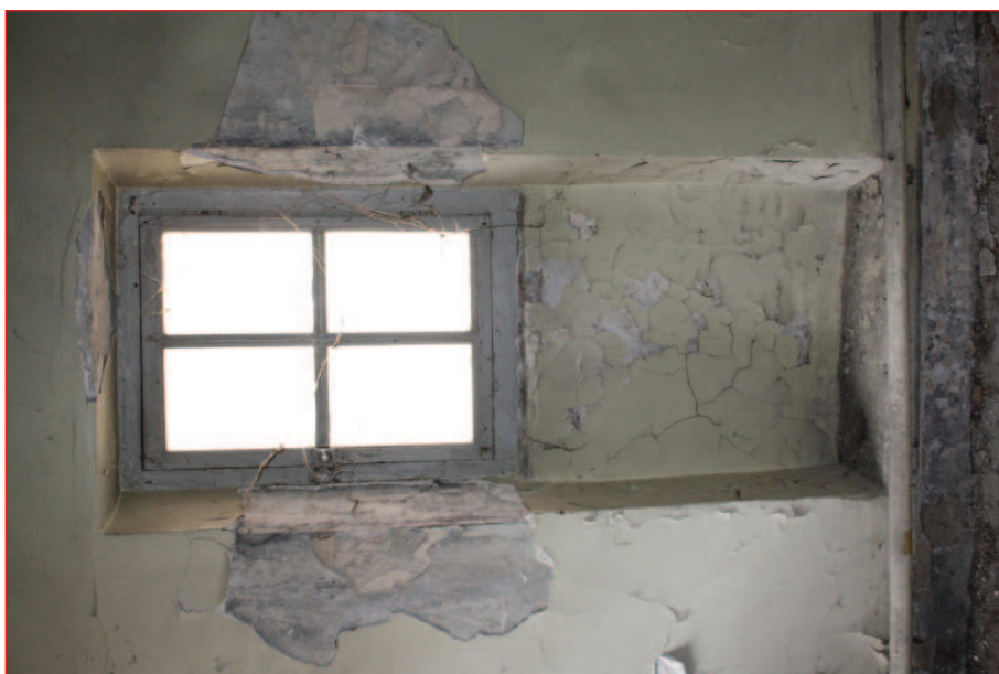
Mur ouest M 1 : fenêtre F 71 (IMG_0940)
