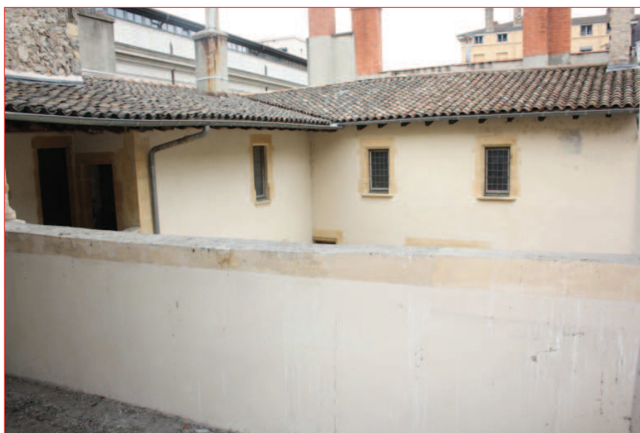
Mur est M 8 : clôture (IMG_0929)
