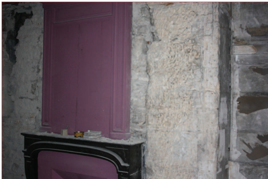
Mur sud M 2 : cheminées CH 7 et CH 23 (IMG_0791)
