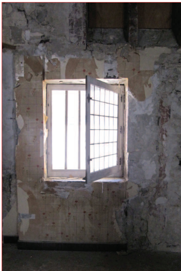
Mur sud M 6 : fenêtre F 10 (XV)
