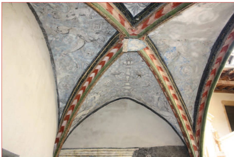
Voûte : vue générale des fresques (IMG_0533)
