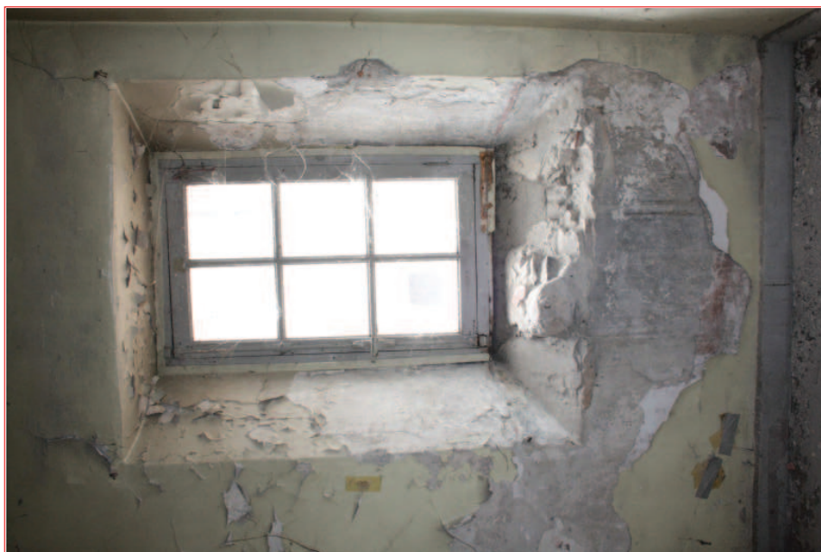
Mur sud M 2 : fenêtre F 69 (IMG_0942)
