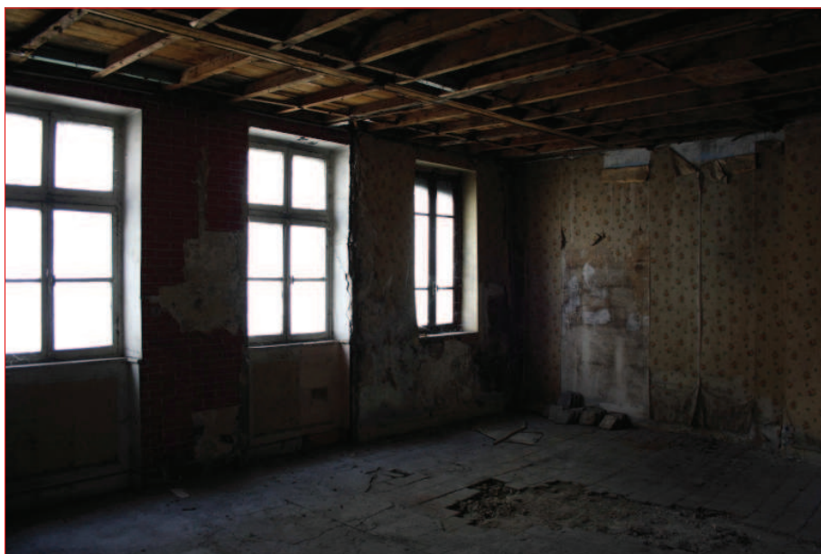
Mur nord M 14 : vue générale (IMG_0563)
