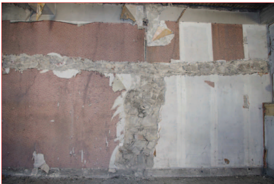
Mur est M 16 : sondage (IMGP2771)
