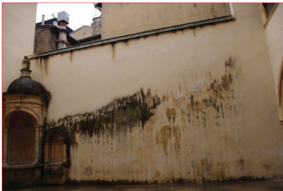
Clôture sud : vue générale (IMGP2608)
