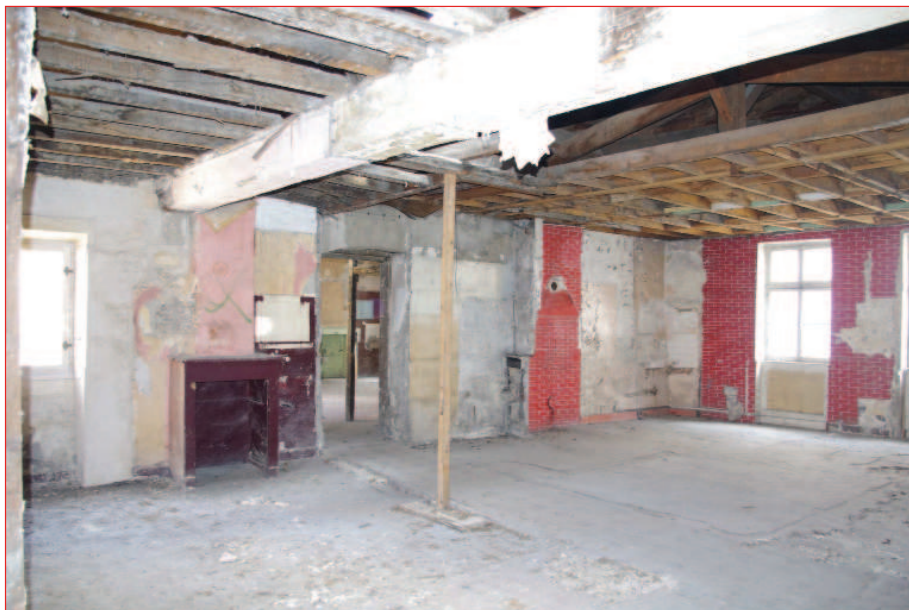
Mur ouest M 13 : moitié nord (IMGP2766)
