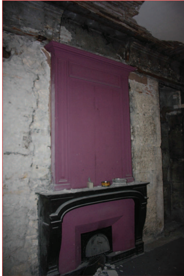
Mur sud M 2 : cheminées CH 7 et CH 23 (IMG_0528)
