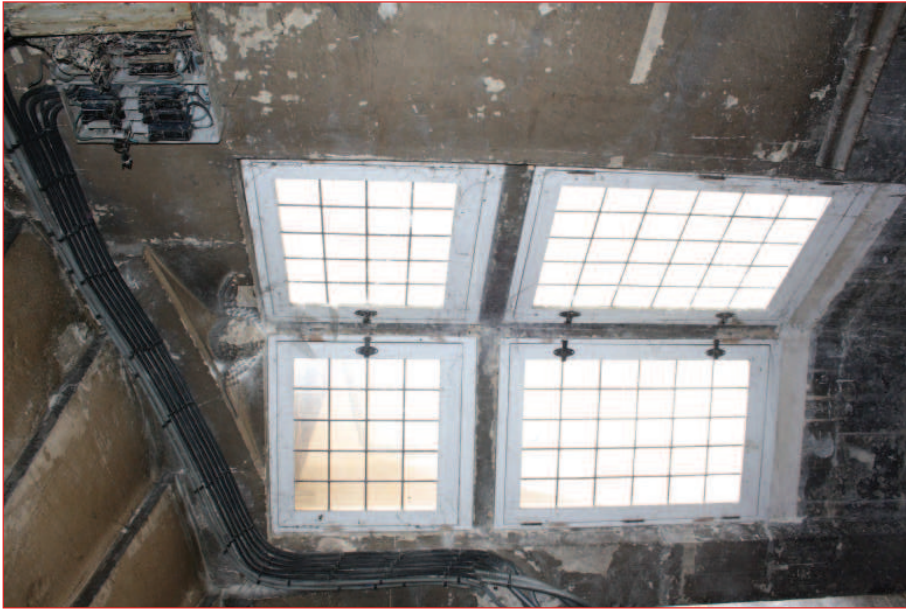
Mur sud-est M 7 : fenêtre F 64 (IMG_0961)
