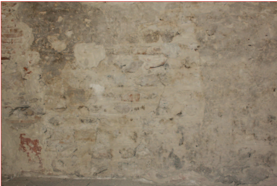
Mur sud M 21 : détail du mur primitif (IMG_0767)
