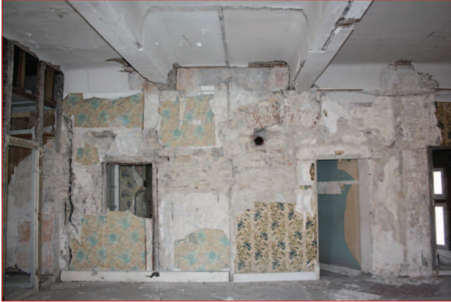
Mur est M 5 : vue générale (IMG_0818)
