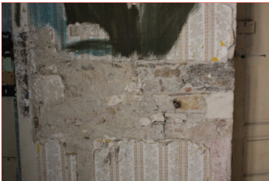
Mur ouest M 12 : sondage central bas (IMG_0718)
