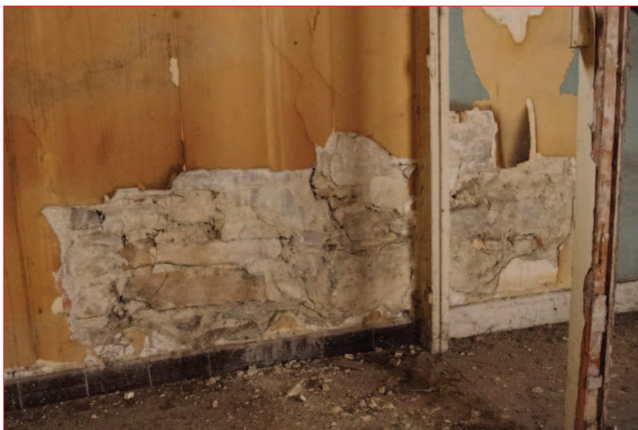
Murs sud M 6 et M 21 : sondages (IMG_2745)
