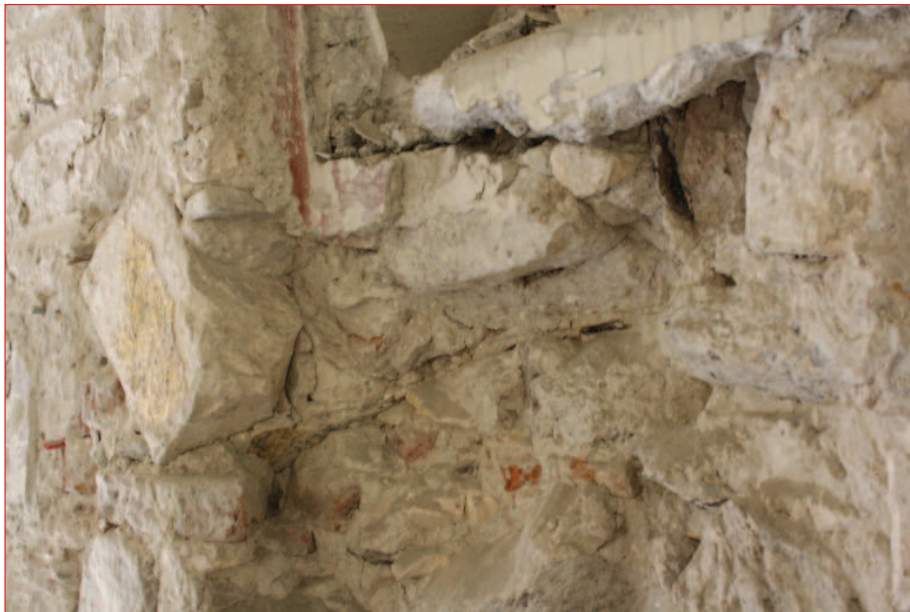
Mur est M 20 : détail des enduits peints sur l'arc de la porte P 58 (IMG_0744)
