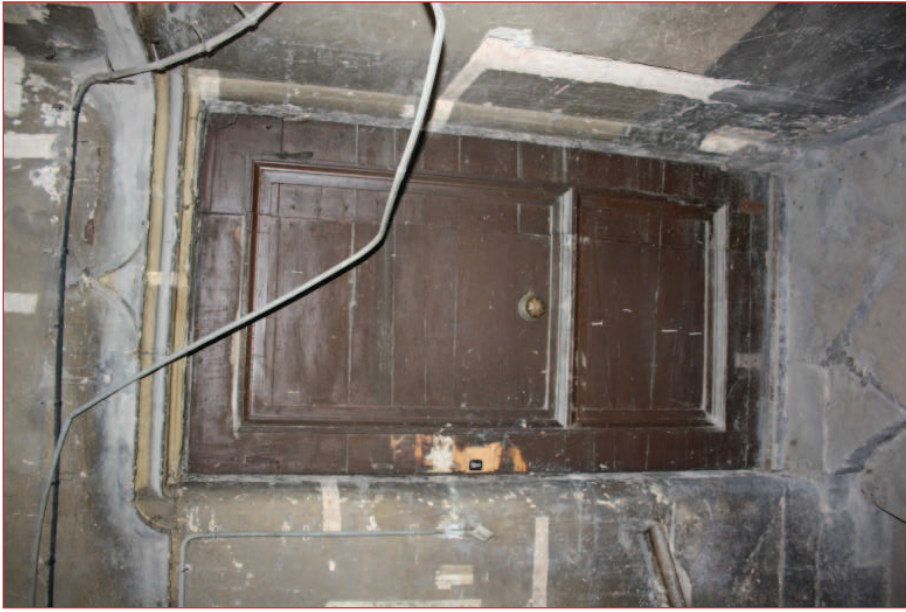
Mur nord M 9 : porte P 39 (IMG-0953)
