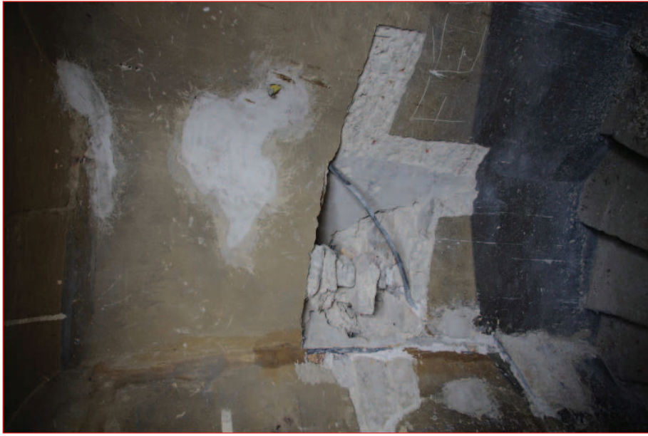
Mur nord M 21 : sondage dans l'angle ouest (IMGP2788)
