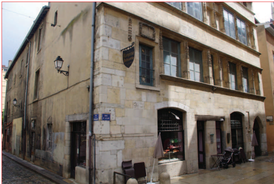
Mur ouest M 1 : vue générale (IMGP2624)
