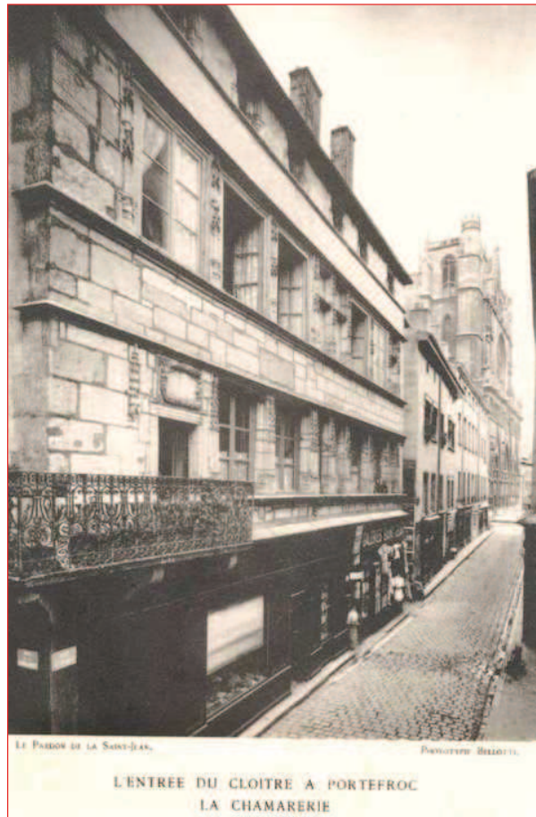
Vue générale de la façade avant 1905 (Gadagne, N 2712)
