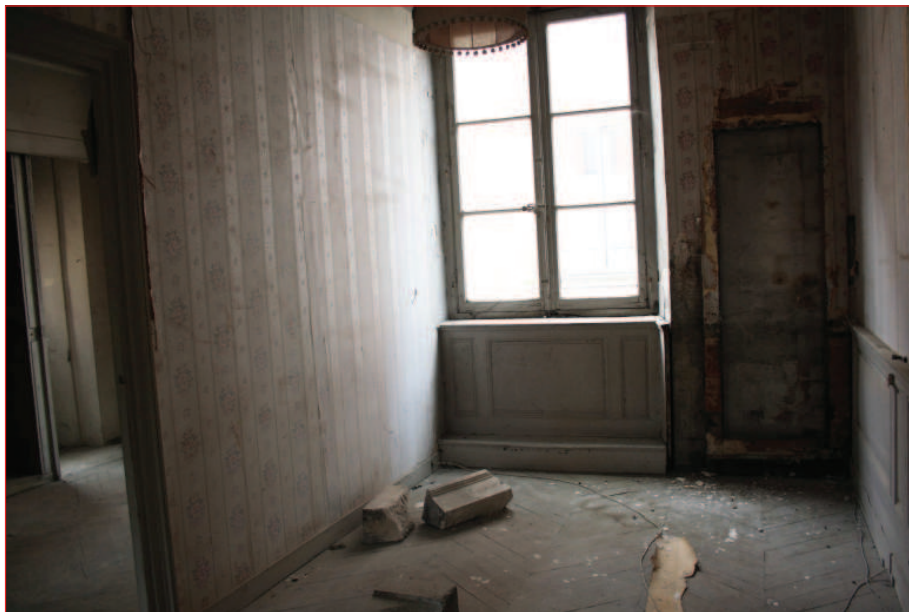
Mur ouest M 1 : fenêtre F 44 (IMG_0803)
