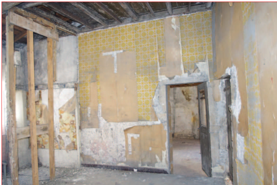
Mur est M 12 : vue générale (IMG_2753)
