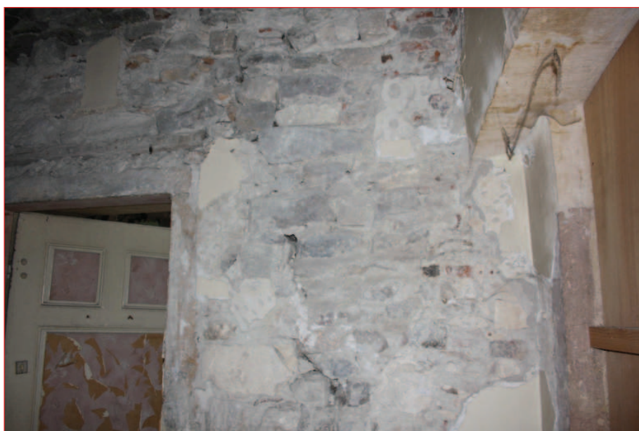
Mur est M 12 : détail du mur primitif (IMG_0752)
