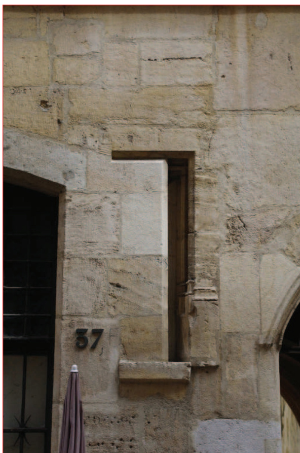
Mur ouest M 1 : fenêtre F 79 (IMGP2618)
