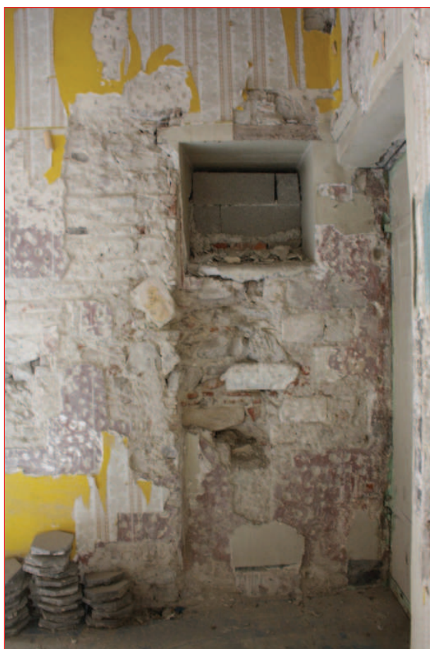
Mur sud M 20 : porte P 58 (IMG_0723)
