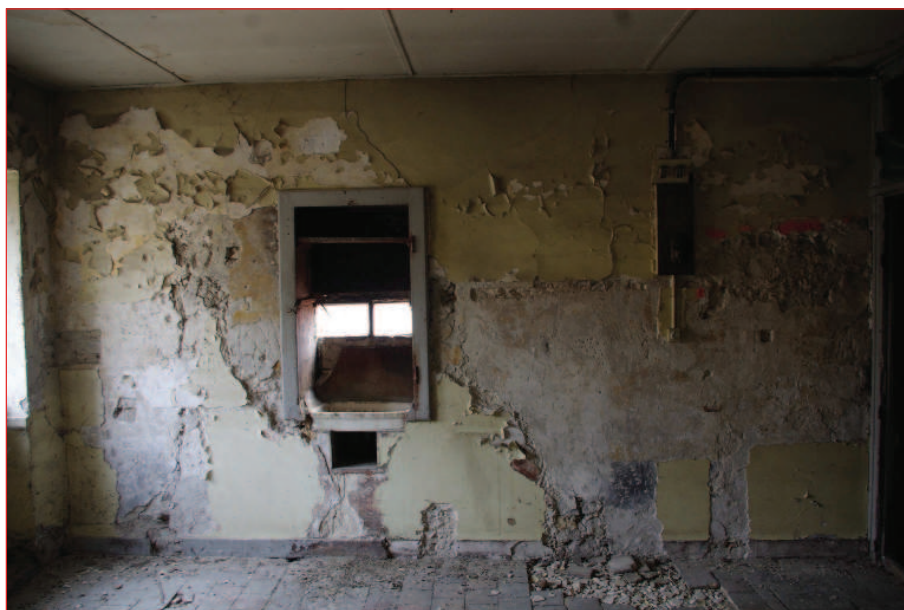
Mur est M 5 : vue générale (IMGP2794)
