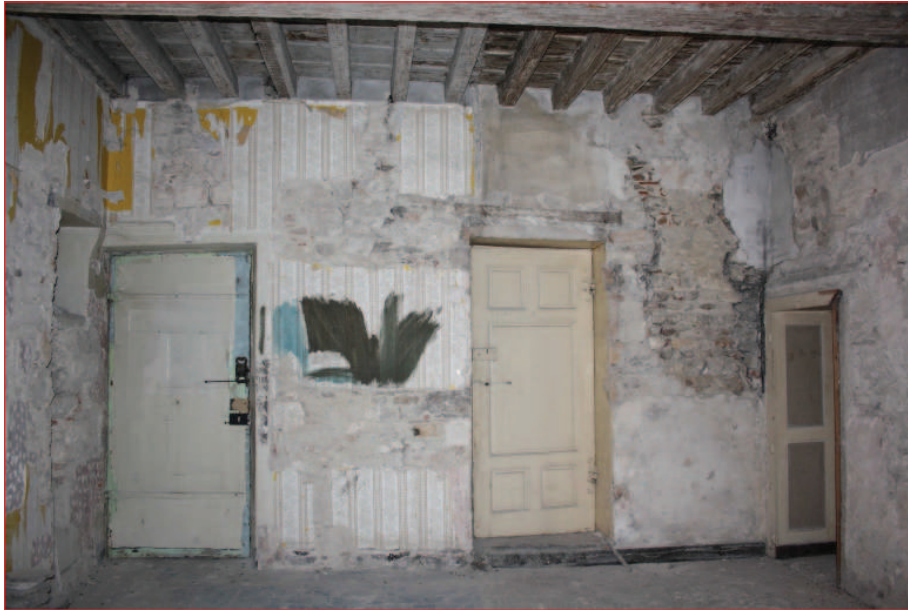
Mur ouest M 12 : vue générale (IMG_0715)
