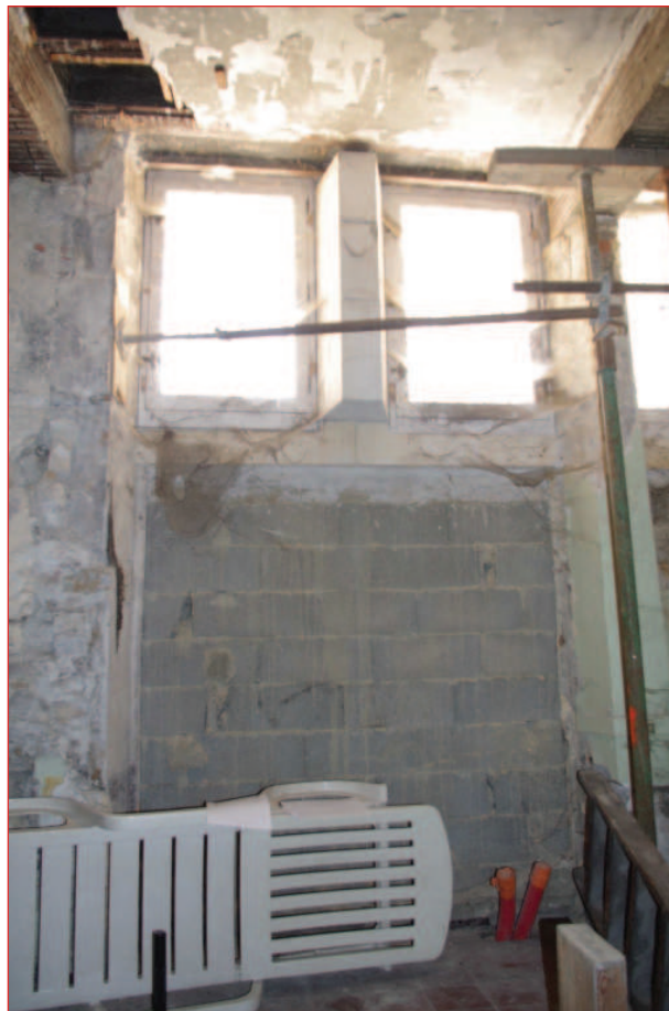
Mur sud M 20 : fenêtres F 82 et F 83, porte P 14 (IMGP2812)
