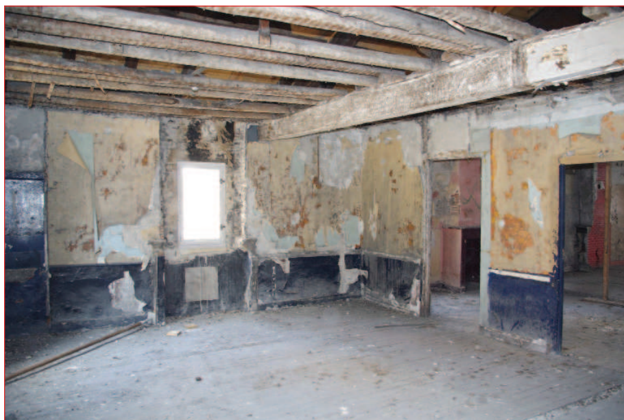
Mur ouest M 13 : moitié sud (IMGP2764)
