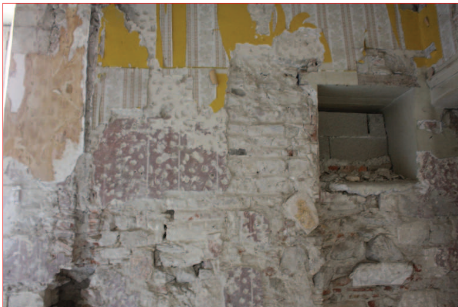
Mur sud M 20 : détail du mur primitif (IMG_0722)
