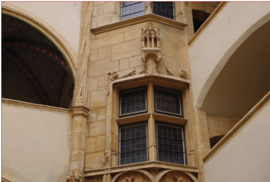
Bâtiment 4 : fenêtre basse F 9 (IMGP2616)
