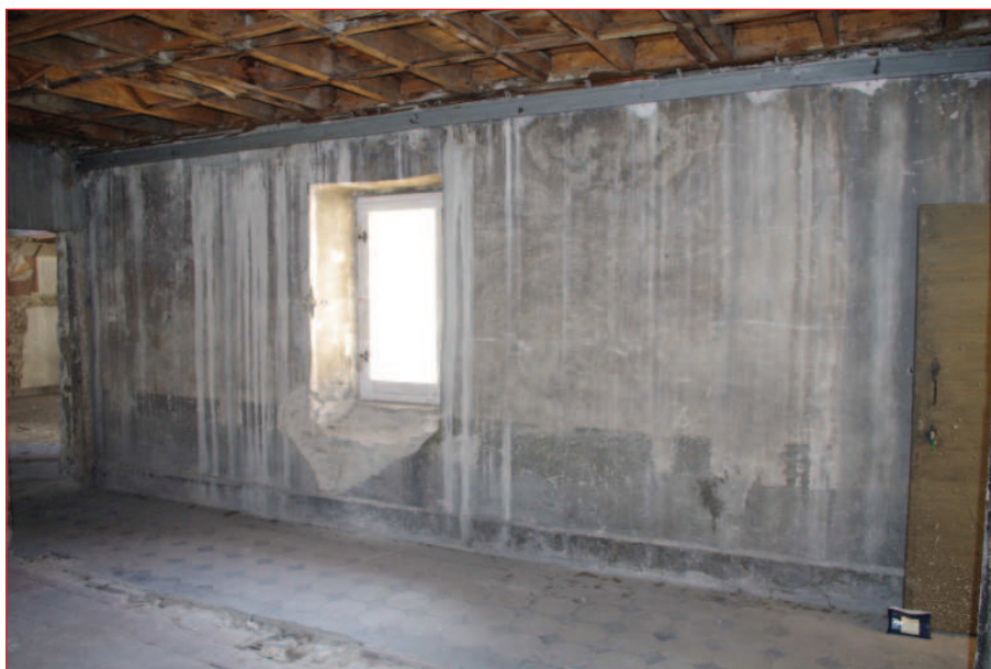
Mur sud M 20 : vue générale (IMG_2759)
