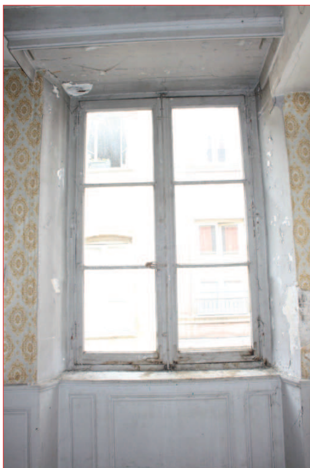
Mur ouest M 1 : fenêtre F 45 (IMG_0922)
