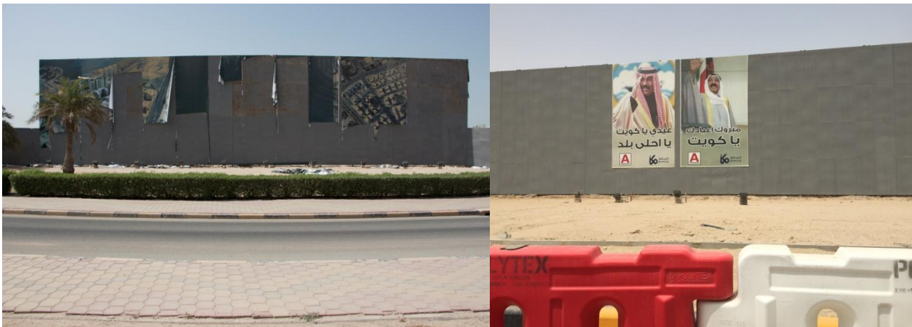
Photos 3 : Hessah al-Mubarak District : arrachage des bâches publicitaires avant début des travaux & apport du soutien émiral au projet (Manuel Benchetrit, 2017 & Roman Stadnicki, 2018)
