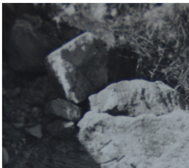
Fig. 33 - Vue de l'un des blocs tombés (septembre 1956)
